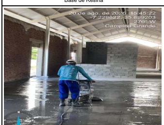
16.8.1.12 - Polimento de Piso de Mármore/Granito
