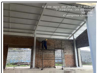
16.1.2 - Locação de Andaime
