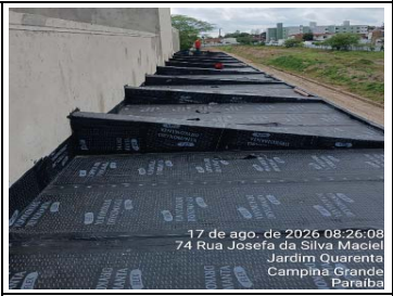
18.8.2.01 - Impermeabilização de superfície com Manta Asfáltica
