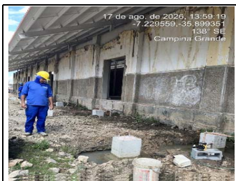
16.4.1 - Esgotamento de vala
