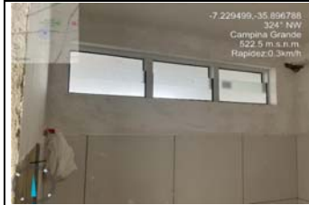
17.7.2.16 - Janela Boca de Lobo
