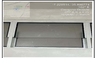
17.7.2.16 - Janela Boca de Lobo
