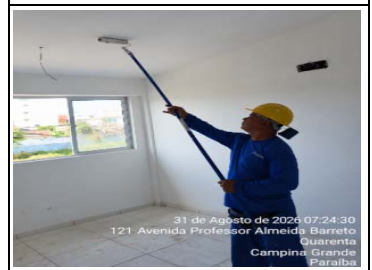
17.8.3.7 - Pinturas para Interiores de Teto
