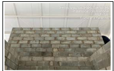
19.7.1.2 - Alvenaria de Concreto Estrutural
