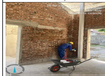
16.8.1.10 - Impermeabilização de Superfície com Membrana a Base de Resina
