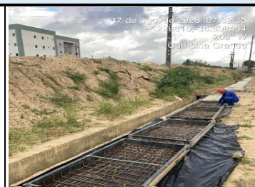
4.10.1 - Laje Pré Fabricada Maciça
