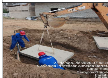
4.10.1 - Laje Pré Fabricada Maciça
