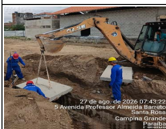
4.10.1 - Laje Pré Fabricada Maciça
