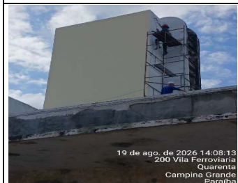
18.8.3.4 - Aplicação Manual de Massa Acrílica
