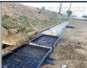
4.10.1 - Laje Pré Fabricada Maciça
