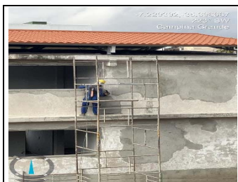
17.2.1.1 - Locação de Andaime
