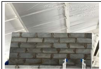
19.7.1.2 - Alvenaria de Concreto Estrutural
