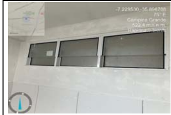
17.7.2.16 - Janela Boca de Lobo
