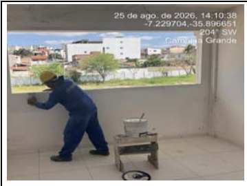
17.8.3.6 - Emassamento com Massa Latex
