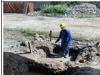
16.5.2.1 - Execução de Fundação
