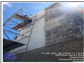
18.8.3.4 - Aplicação Manual de Massa Acrílica
