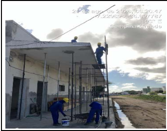
18.2.1.1 - Locação de Andaime
