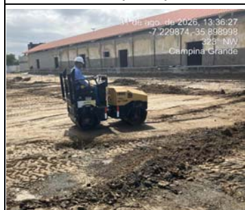
3.4.2 - Compactação de Corpo de Aterro
