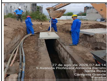
4.10.1 - Laje Pré Fabricada Maciça
