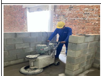
16.8.1.12 - Polimento de Piso de Mármore/Granito
