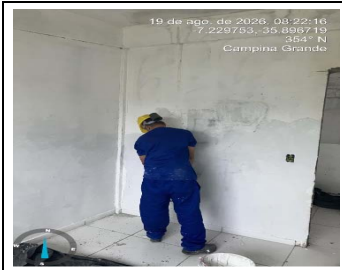
17.8.3.7 - Emassamento com Massa Latex
