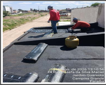
18.8.2.01 - Impermeabilização de superfície com Manta Asfáltica
