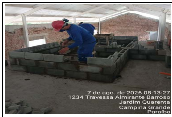
19.7.1.2 - Alvenaria de Concreto Estrutural
