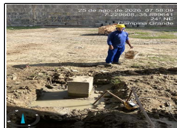
16.4.1 - Esgotamento de vala
