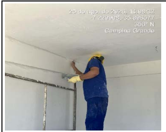
17.8.3.7 - Emassamento com Massa Latex
