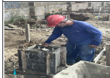
16.5.2.1 - Execução de Pilar
