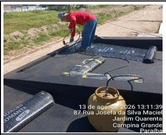
18.8.2.01 - Impermeabilização de superfície com Manta Asfáltica
