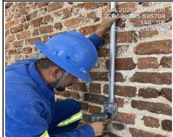
19.9.1.4 - Conduleite em Alumínio
