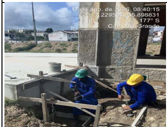
16.5.2.1 - Execução de Fundação
