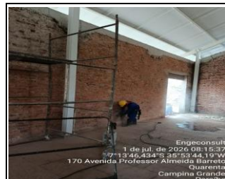
16.8.1.8 - Escarificação Mecânica
