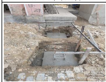
16.5.2.2 - Estrutura para Pilares
