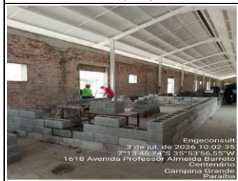
16.7.1.2 - Alvenaria em Bloco
