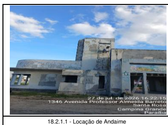
18.2.1.1 - Locação de Andaime
