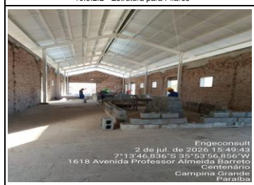
16.7.1.2 - Alvenaria em Bloco
