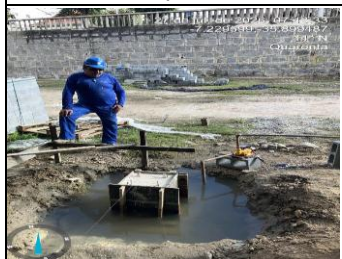
16.4.1 - Esgotamento de vala
