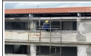
17.8.3.3 - Restauro - Remoção de Pintura
