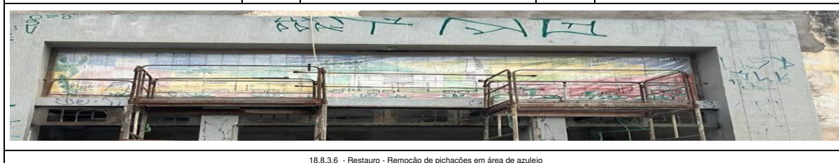
18.8.3.6 - Restauro - Remoção de pichações em área de azulejo
