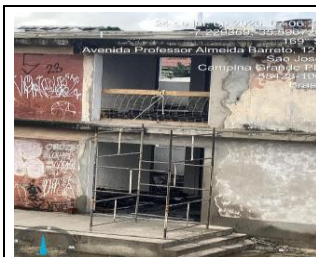
17.2.1.1 - Locação de Andaime
