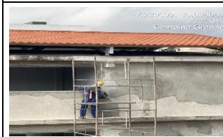
17.8.3.3 - Restauro - Remoção de Pintura
