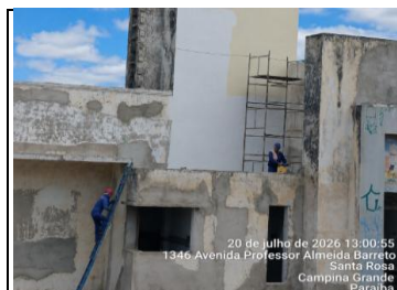
16.1.4 - Montagem e Desmontagem de Andaime
