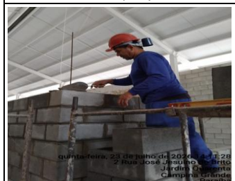
16.7.1.2 - Alvenaria em Bloco
