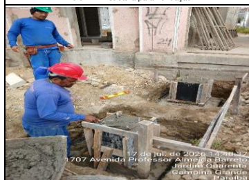
16.5.2.2 - Estrutura para Pilares
