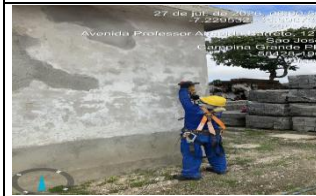
17.8.3.3 - Restauro - Remoção de Pintura
