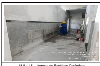
18.8.1.15 - Limpeza de Pastilhas Cerâmicas
