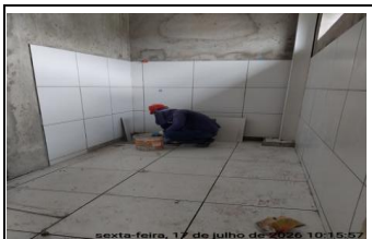
19.8.1.14 - Revestimento de Parede
