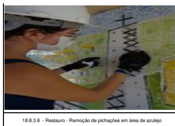
18.8.3.6 - Restauro - Remoção de pichações em área de azulejo
