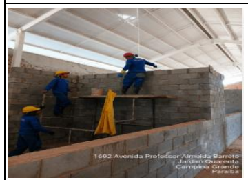
16.7.1.2 - Alvenaria em Bloco
