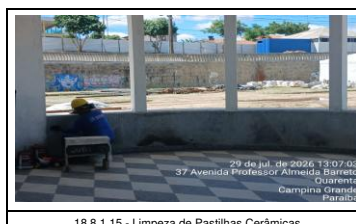
18.8.1.15 - Limpeza de Pastilhas Cerâmicas
