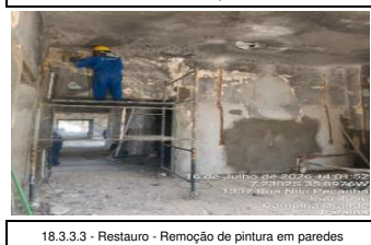
18.3.3.3 - Restauro - Remoção de pintura em paredes
