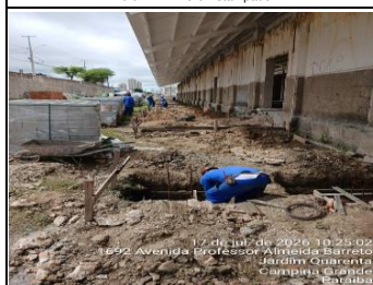
16.5.2.1 - Estrutura para Fundação
