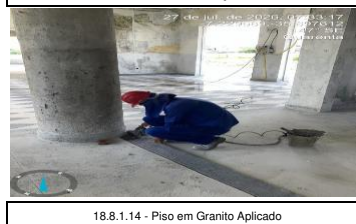
18.8.1.14 - Piso em Granito Aplicado
