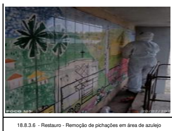
18.8.3.6 - Restauro - Remoção de pichações em área de azulejo
