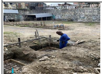
16.5.2.1 - Estrutura para Fundação
