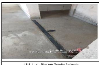
18.8.1.14 - Piso em Granito Aplicado
