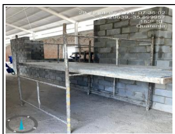
16.1.2 - Locação de Andaime
