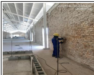
16.8.1.8 - Escarificação Mecânica
