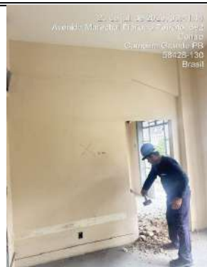
DEMOLIÇÃO DE PAREDE DE ALVENARIA 1º PAV SL ADM 08
