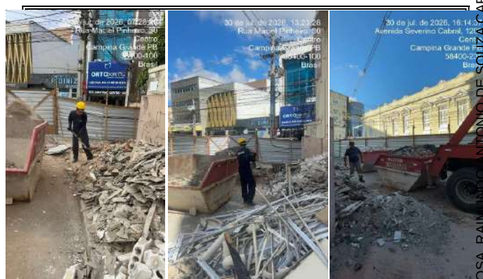
REALIZADO O ENCHIMENTO DA CAÇAMBA ESTACIONARIA (PAPA METRALHA)
