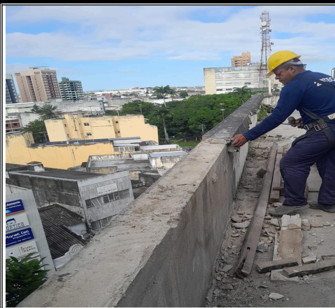
ITEM 3.4.3 (FASE 02) - REMOÇÃO CALHAS E RUFOS, DE FORMA MANUAL, SEM REAPROVEITAMENTO
