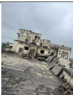
RETIRADA DE TELHA FIBROCIMENTO DE FORMA MANUAL
