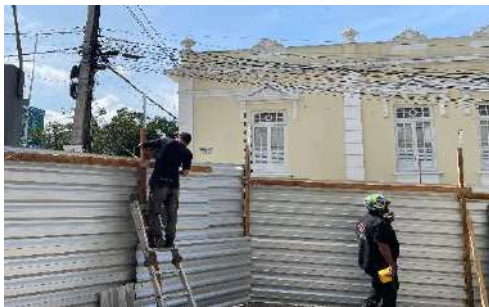
INSTALAÇÃO DE CERCA ELÉTRICA
