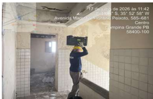
COLETA E CARGA DE ENTULHO DE FORMA MANUAL - FASE 02
