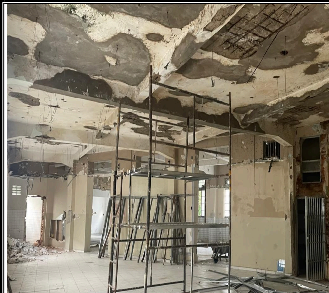
ITEM 2.2 (FASE 02) -MONTAGEM E DESMONTAGEM DE ANDAIME TUBULAR TIPO "TORRE"
