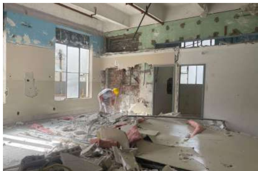
REMOÇÃO DE CHAPAS E PERFIS DE DRYWALL, DE FORMA MANUAL, SEM REAPROVEITAMENTO (FASE 02)
