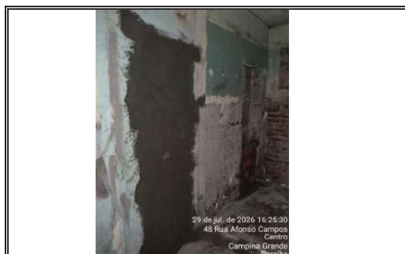
FECHAMENTO+CONSTRUÇÃO DE ALVENARIA SUBSOLO (APOIO SESUMA)
