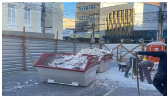
REALIZADO O ENCHIMENTO DA CAÇAMBA ESTACIONÁRIA (PAPA METRALHA)
