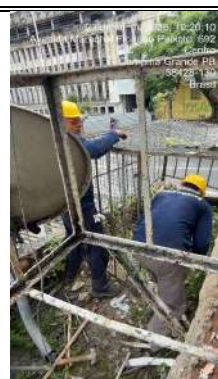
REMOÇÃO DE GRADE DE FERRO COBERTA SUBSOLO
