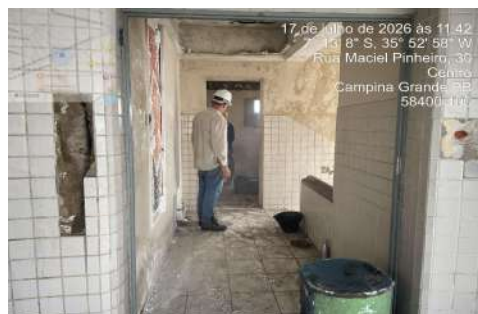
COLETA E CARGA DE ENTULHO DE FORMA MANUAL - FASE 02
