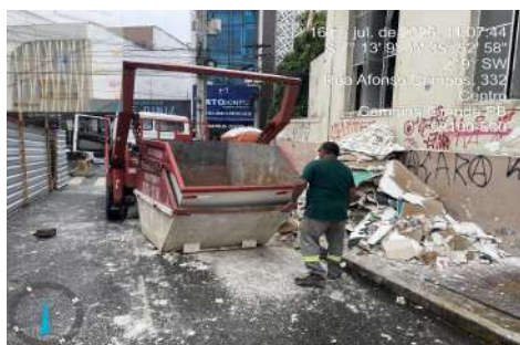
REALIZADO O ENCHIMENTO DA CAÇAMBA ESTACIONÁRIA (PAPA METRALHA)
