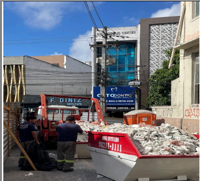
REMOÇÃO DE ENTULHOS DA OBRA
