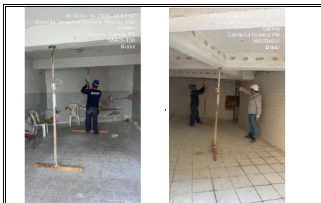
MONTAGEM ESCORA TUBULAR ESCORAMNETO LAJE SUBSOLO ATEND 01/02
