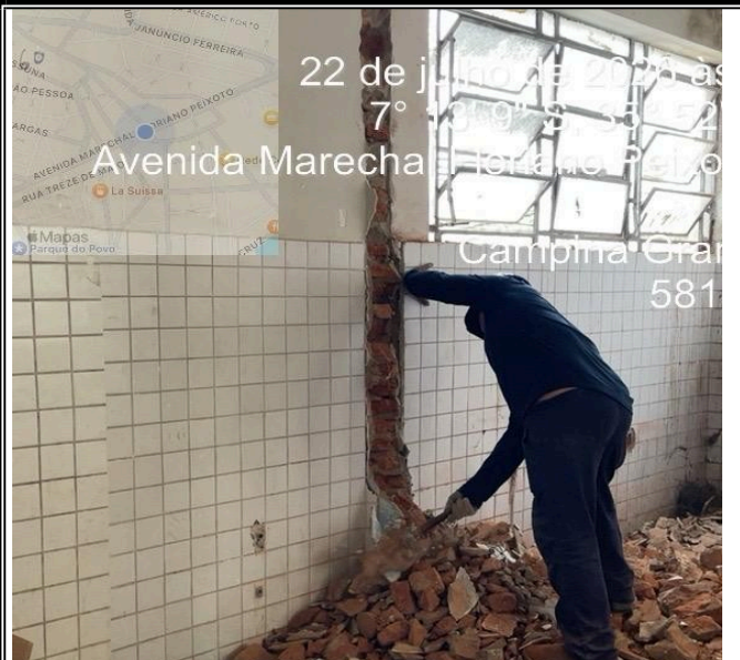
ITEM 3.1.1 (FASE 02) DEMOLIÇÃO DE ALVENARIA DE BLOCO CERÂMICO
