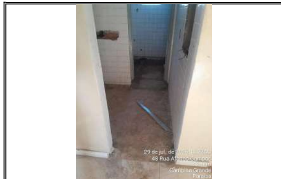
DEMOLIÇÃO REBAIXO DE PISO MARTELETE LAVABO 1ºPAV
