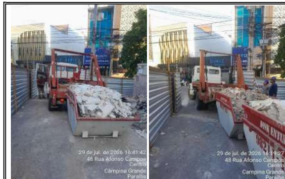
REALIZADO O ENCHIMENTO DA CAÇAMBA ESTACIONÁRIA (PAPA METRALHA)
