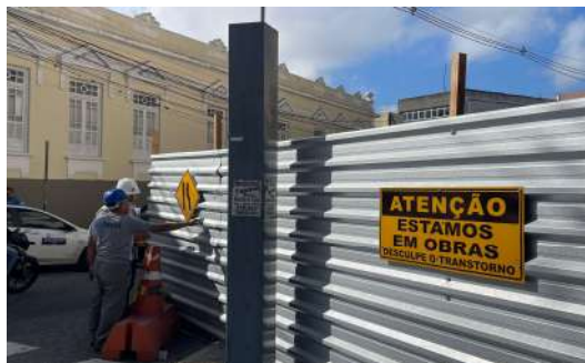
INSTALAÇÕES DE PLACAS DE SINALIZAÇÃO
