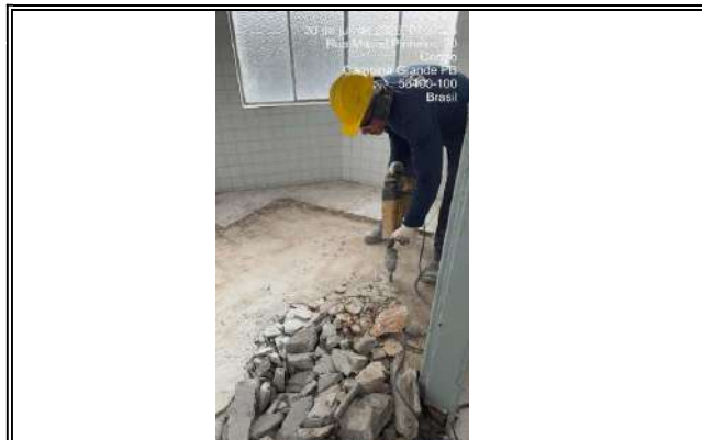
DEMOLIÇÃO REBAIXO DE PISO MARTELETE APOIO/APOIO PREF 1ºPAV
