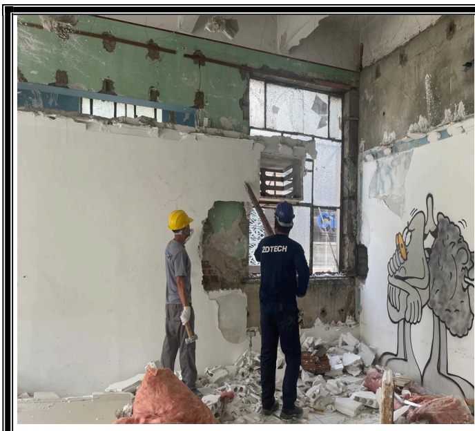
ITEM 3.1.2 (FASE 02) -REMOÇÃO DE CHAPAS E PERFIS DE DRYWALL, DE FORMA MANUAL, SEM REAPROVEITAMENTO
