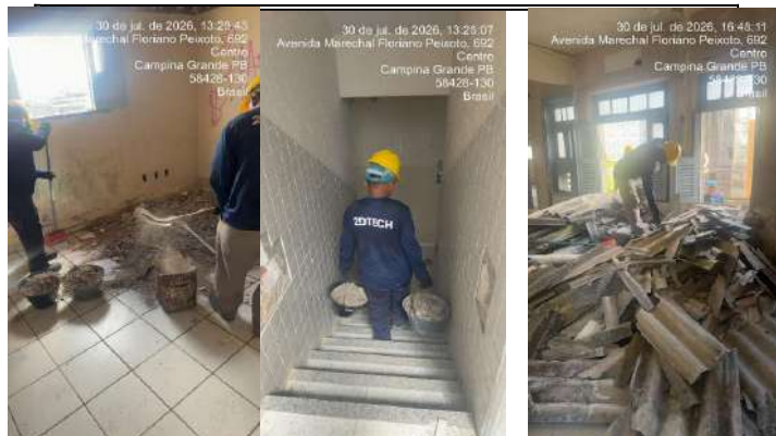
COLETA E CARGA DE ENTULHO DE FORMA MANUAL
