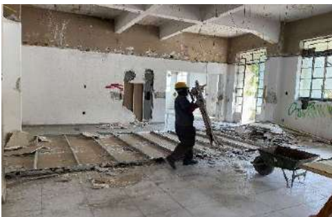
COLETA E CARGA MANUAIS DE ENTULHO
