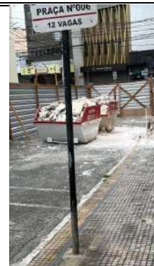
REALIZADO O ENCHIMENTO DA CAÇAMBA ESTACIONÁRIA (PAPA METRALHA)
