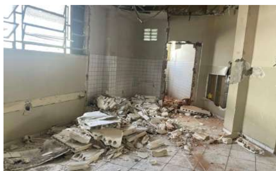
REMOÇÃO DE CHAPAS E PERFIS DE DRYWALL, DE FORMA MANUAL, SEM REAPROVEITAMENTO (FASE 02)
