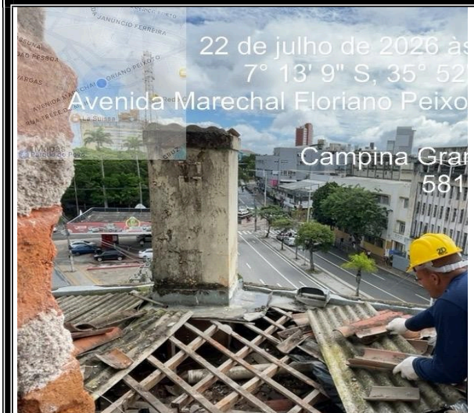
ITEM 3.4.1 (FASE 02) -REMOÇÃO DE TRAMA DE MADEIRA PARA COBERTURA, DE FORMA MANUAL, SEM REAPROVEITAMENTO
