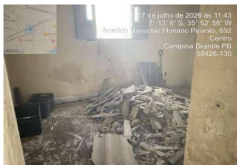
COLETA E CARGA DE ENTULHO DE FORMA MANUAL - FASE 02
