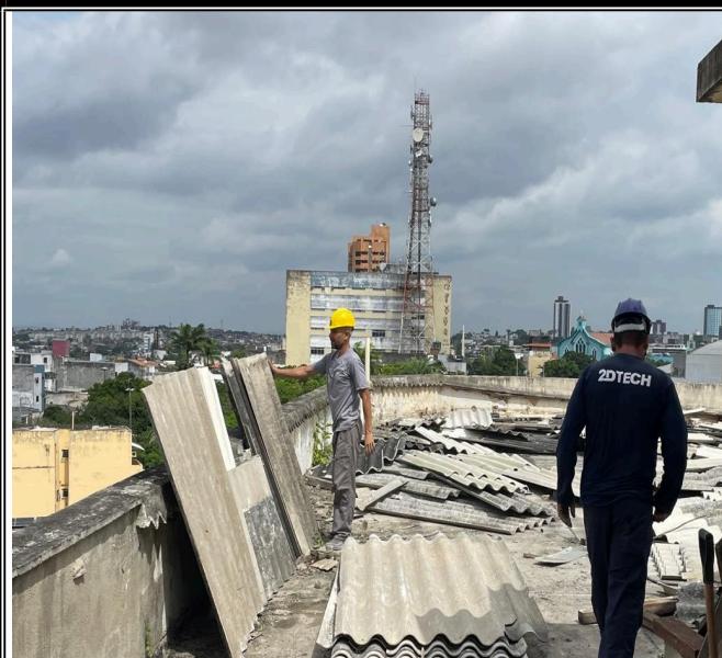
ITEM 3.4.2 (FASE – 02) - REMOÇÃO DE TELHAS DE FIBROCIMENTO METÁLICA E CERÂMICA, DE FORMA MANUAL, SEM REAPROVEITAMENTO
