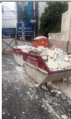
REALIZADO O ENCHIMENTO DA CAÇAMBA ESTACIONÁRIA (PAPA METRALHA)
