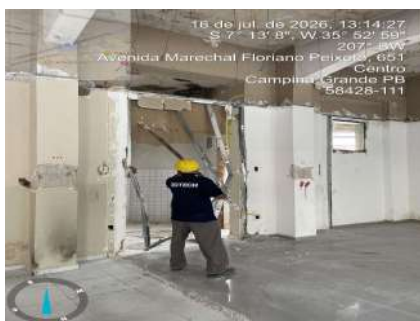
REMOÇÃO DE CHAPAS E PERFIS DE DRYWALL, DE FORMA MANUAL, SEM REAPROVEITAMENTO - FASE 02
