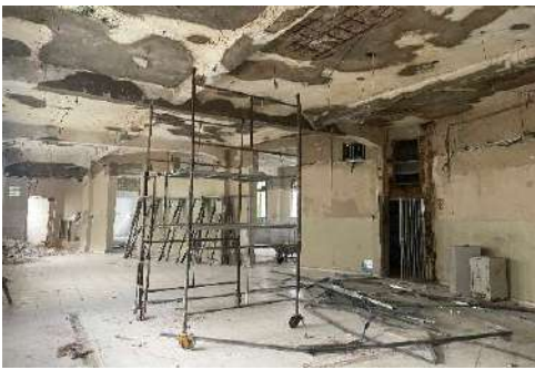
MONTAGEM DE ANDAIME TUBULAR TIPO "TORRE"
