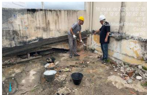
REMOÇÃO DE TELHAS DE FIBROCIMENTO, DE FORMA MANUAL
