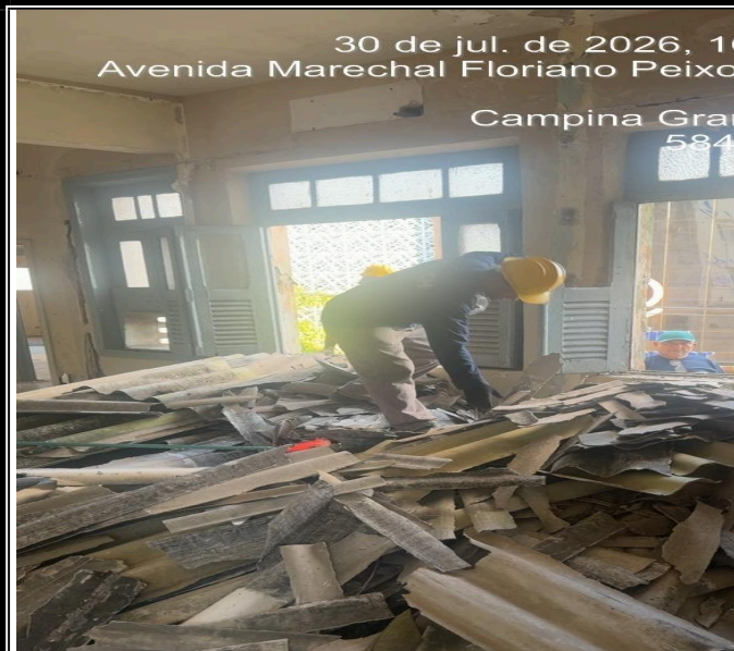
ITEM 2.3 (FASE 01) -REMOÇÃO DE TELHAS DE FIBROCIMENTO, METÁLICA E CERÂMICA, DE FORMA MECANIZADA, COM USO DE GUINDASTE, SEM RREAPROVEITAMENTO. AF_09/2023
