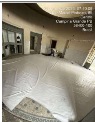
PROTEÇÃO DO PISO DO HALL PRINCIPAL DE ENTRADA DO EDIFÍCIO
