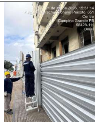
CONCLUSÃO DO RECUO EM TRECHO DO TAPUME NA AV. FLORIANO PEIXOTO (EXIGENCIA DA SECOB)
