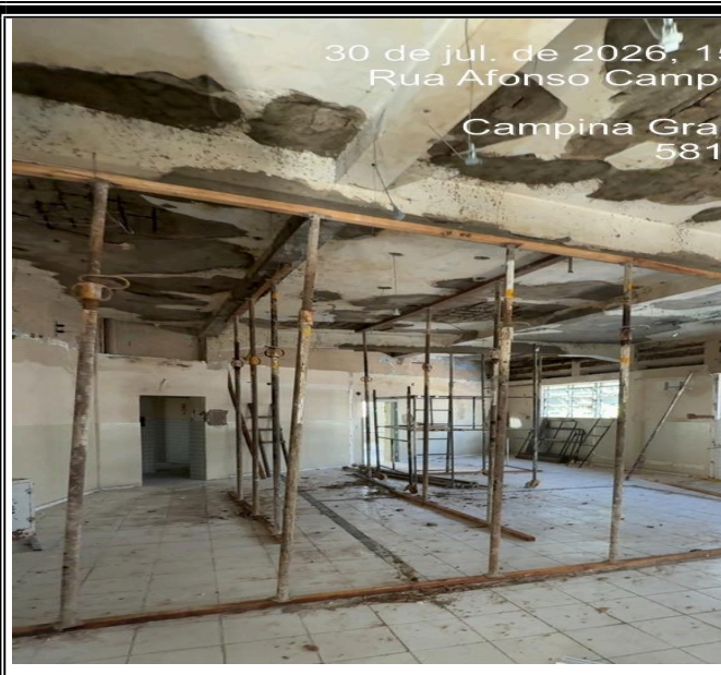
ITEM 1.5 (FASE 01) -CIMBRAMENTO / ESCORAMENTO TUBULAR DESMONTÁVEL, PARA PONTE OU VIADUTO, EDIFICAÇÃO CIVIL E INDUSTRIAL, INCLUSAS MONTAGEM E DESMONTAGEM
