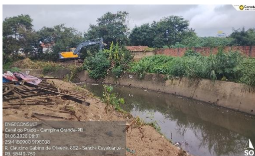
Figura 4.1 – Limpeza de área Est. 15~18 LD
