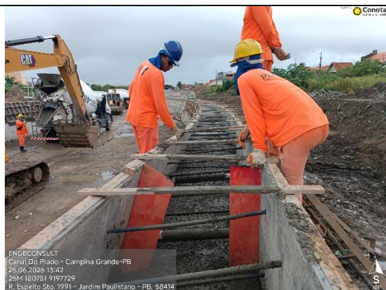
Figura 4.5 – Concretagem 2º nível parede LD Est. 32 ~ 33
