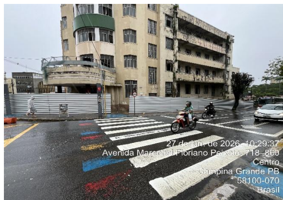
Figura 4.4 – Instalação de tapume
