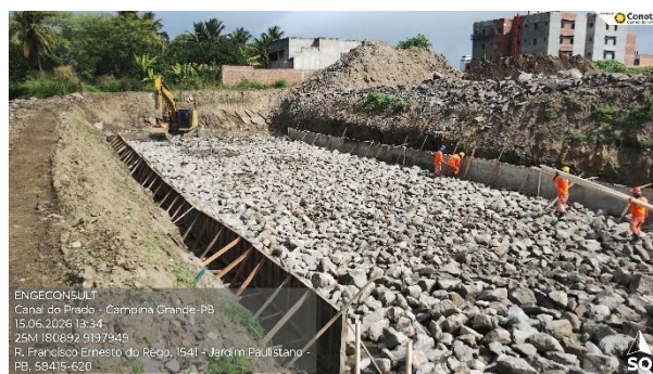
Figura 4.8 – Enrocamento e piso
