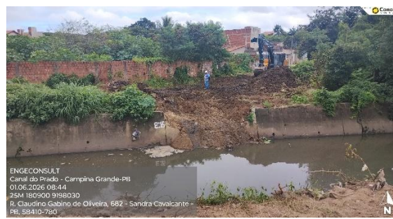
Figura 4.2 – Limpeza de área Est. 15~18 LD
