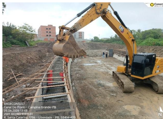
Figura 4.4 – Concretagem 2º nível parede LD Est. 32 ~ 33
