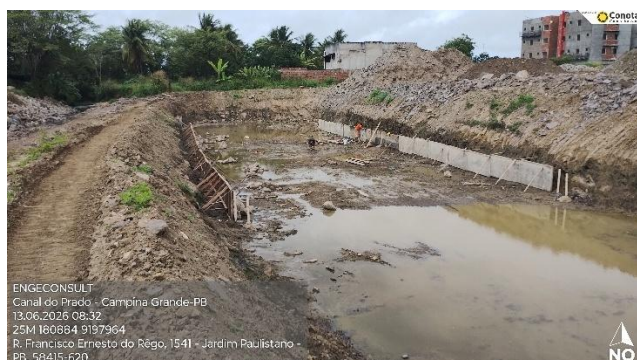
Figura 4.7 – Forma para enrocamento e piso
