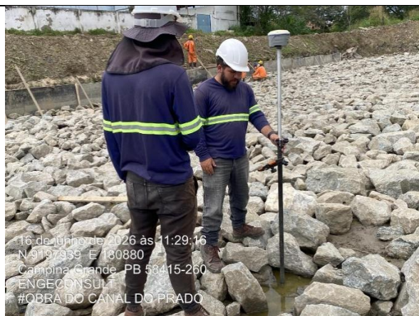
Figura 4.3 – Conferencia de cota do enrocamento Est. 20 ~ 22
