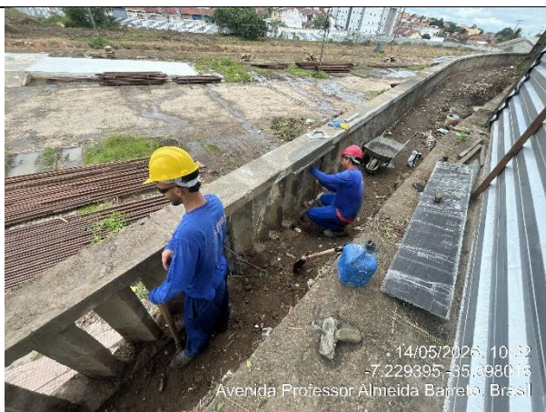
Figura 4.5 – Limpeza e recomposição da balastrada
