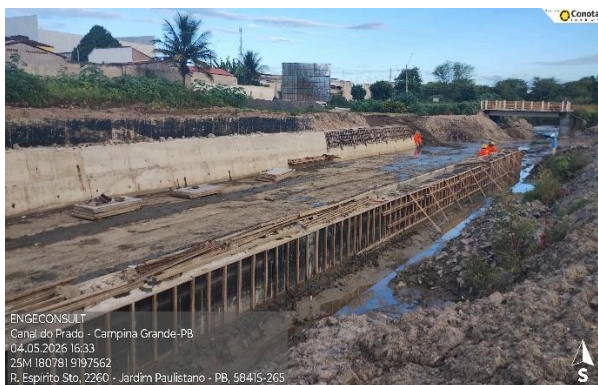
Figura 4.35 – Forma e concreto parede LD
