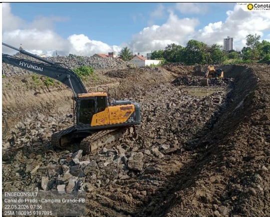
Figura 4.33 – Corte material 3ª cat. com uso de rompedor hidráulico
