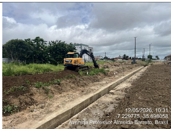
Figura 4.6 – Limpeza mecanizada de valetas e caixas existentes
