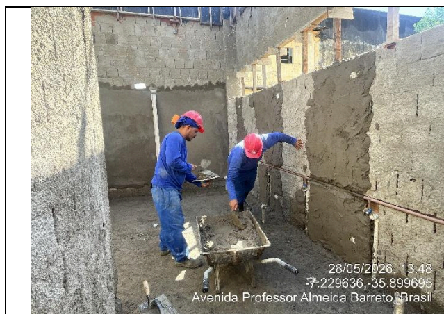
Figura 4.17 – Instalações hidrossanitárias / chapisco e reboco
