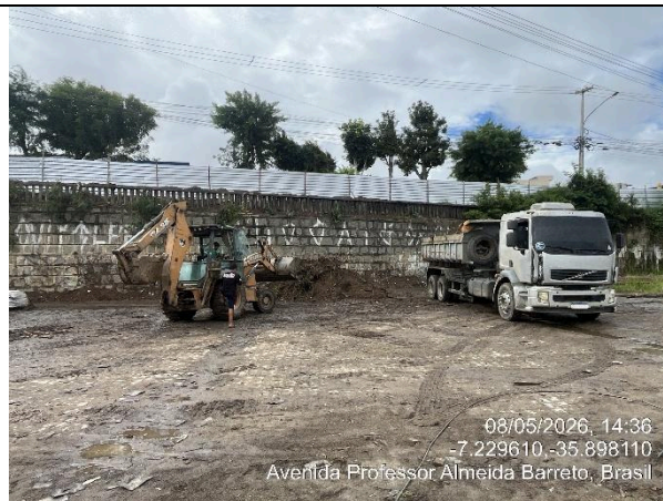
Figura 4.6 – Limpeza mecanizada de valetas e caixas existentes
