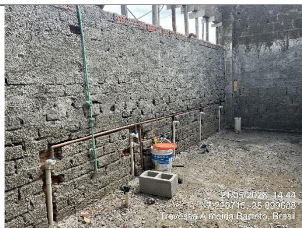
Figura 4.18 – Instalações hidrossanitárias
