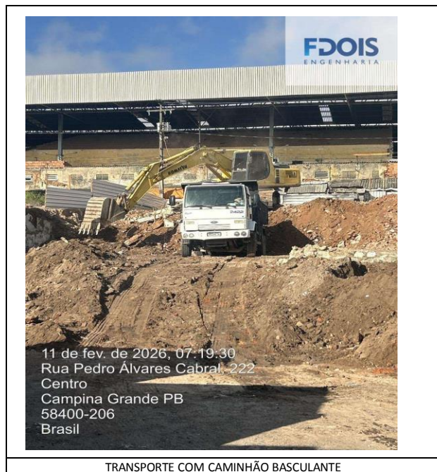
TRANSPORTE COM CAMINHÃO BASCULANTE
