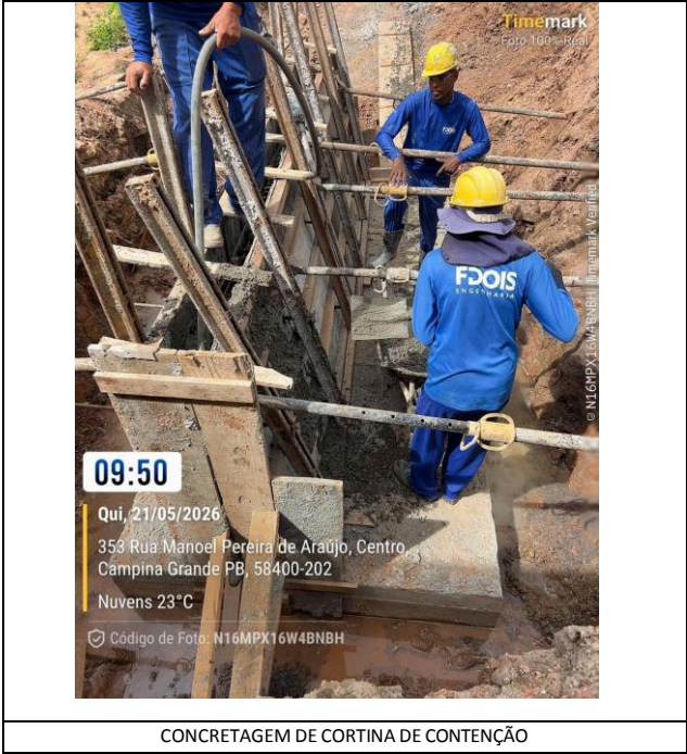
CONCRETAGEM DE CORTINA DE CONTENÇÃO
