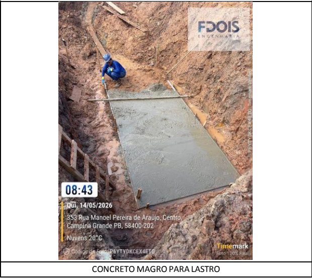
CONCRETO MAGRO PARA LASTRO
