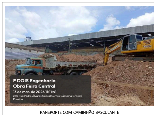
TRANSPORTE COM CAMINHÃO BASCULANTE
