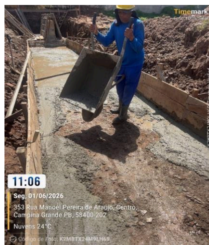
CONCRETO MAGRO PARA LASTRO
