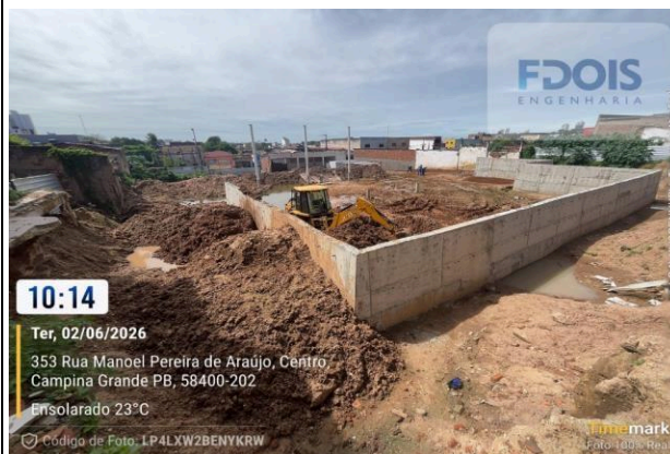
REATERRO MECANIZADO DE VALA COM MINICARREGADEIRA
