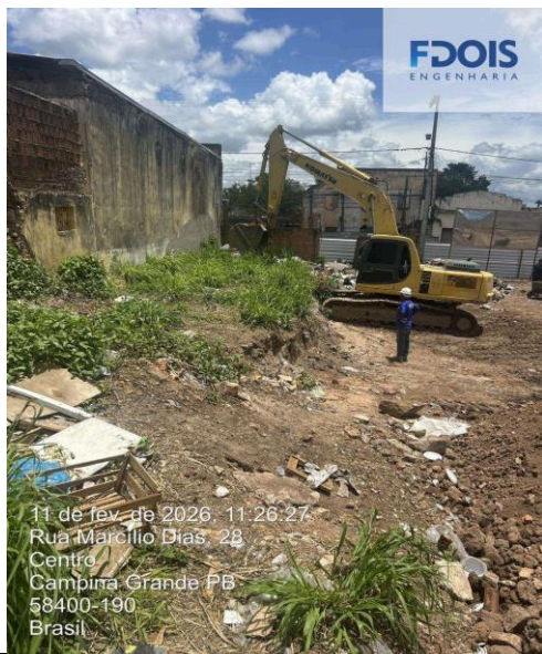
LIMPEZA MECANIZADA DE CAMADA VEGETAL
