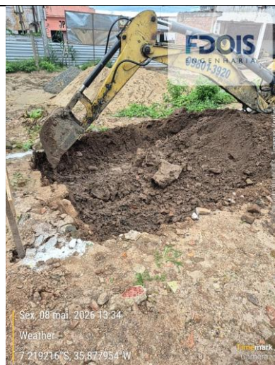
ESCAVAÇÃO HORIZONTAL, INCLUINDO CARGA E DESCARGA EM SOLO
