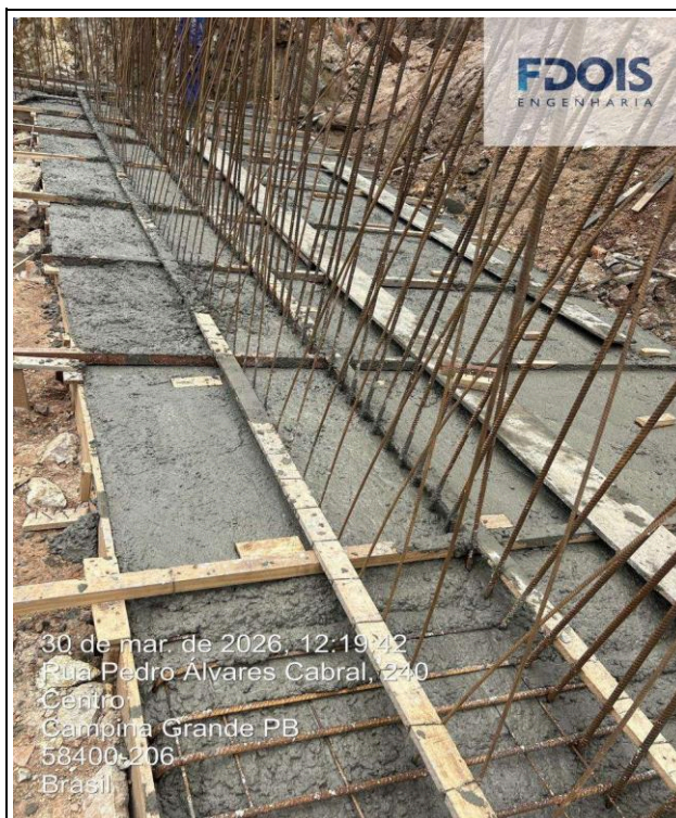
CONCRETAGEM DE CORTINA DE CONTENÇÃO
