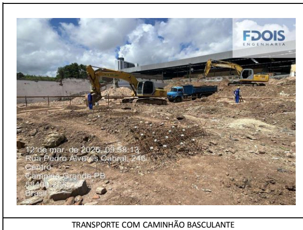
TRANSPORTE COM CAMINHÃO BASCULANTE
