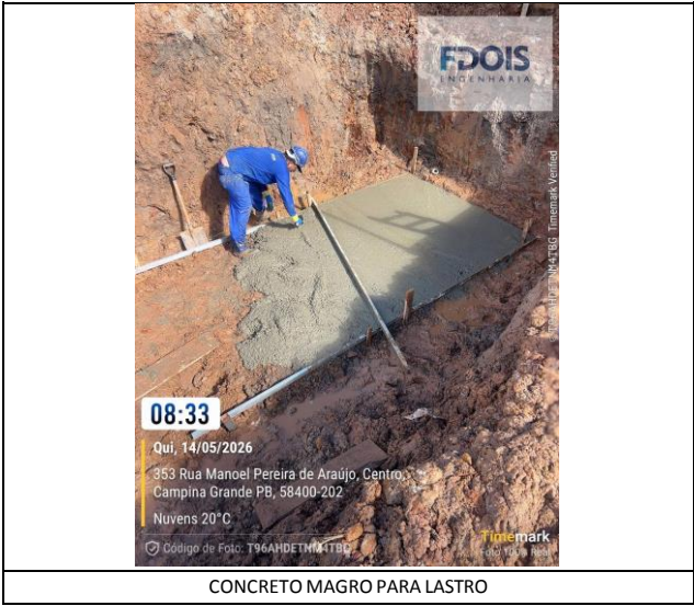
CONCRETO MAGRO PARA LASTRO
