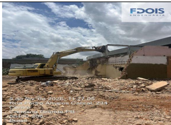
DEMOLIÇÃO DE LAJES
