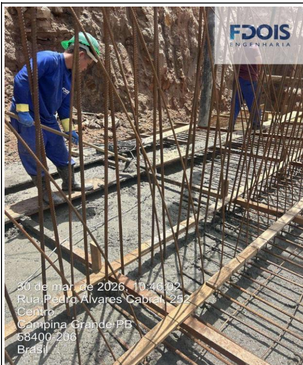
CONCRETAGEM DE CORTINA DE CONTENÇÃO
