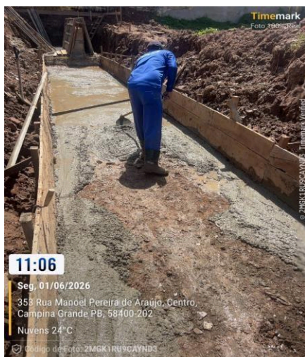
CONCRETO MAGRO PARA LASTRO
