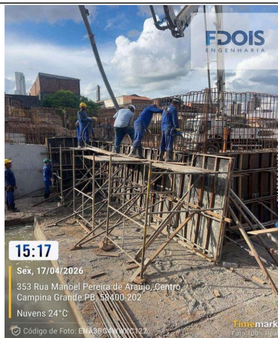
CONCRETAGEM DE CORTINA DE CONTENÇÃO, ATRAVÉS DE BOMBA
