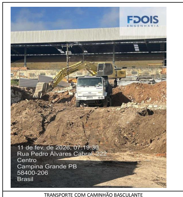
TRANSPORTE COM CAMINHÃO BASCULANTE
