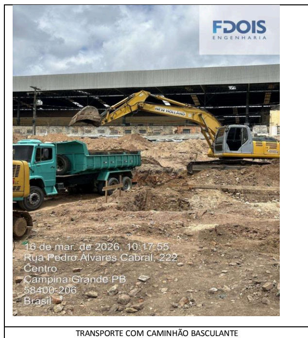
TRANSPORTE COM CAMINHÃO BASCULANTE
