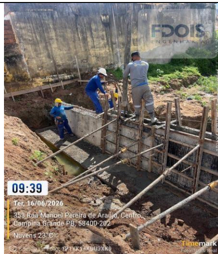
CONCRETAGEM DE CORTINA DE CONTENÇÃO
