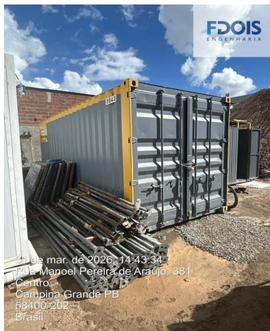
LOCAÇÃO DE CONTAINER - ALMOXARIFADO
