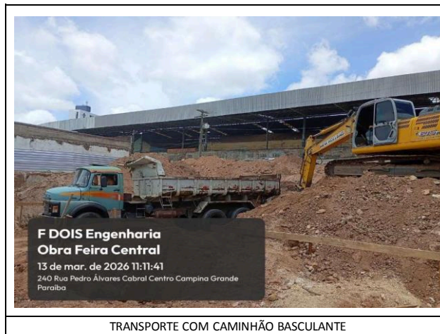
TRANSPORTE COM CAMINHÃO BASCULANTE
