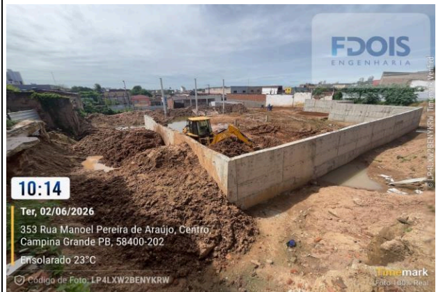
REATERRO MECANIZADO DE VALA COM MINICARREGADEIRA
