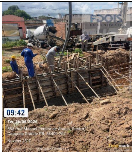
CONCRETAGEM DE CORTINA DE CONTENÇÃO
