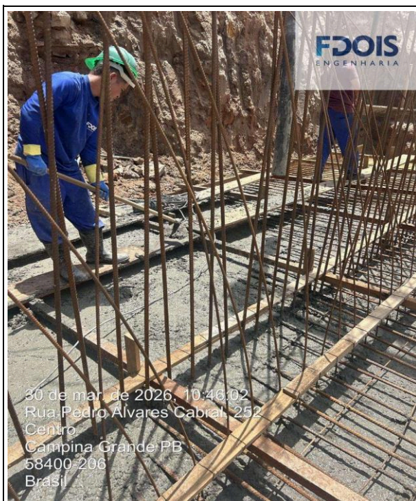
CONCRETAGEM DE CORTINA DE CONTENÇÃO
