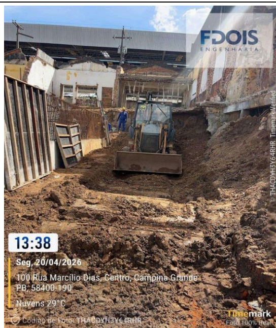
REATERRO MECANIZADO DE VALA COM MINICARREGADEIRA
