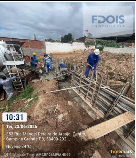
CONCRETAGEM DE CORTINA DE CONTENÇÃO
