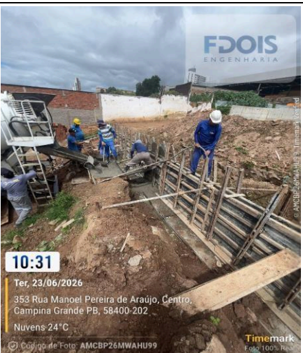
CONCRETAGEM DE CORTINA DE CONTENÇÃO
