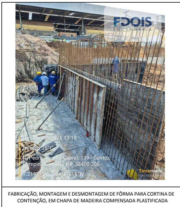
FABRICAÇÃO, MONTAGEM E DESMONTAGEM DE FÔRMA PARA CORTINA DE CONTENÇÃO, EM CHAPA DE MADEIRA COMPENSADA PLASTIFICADA
