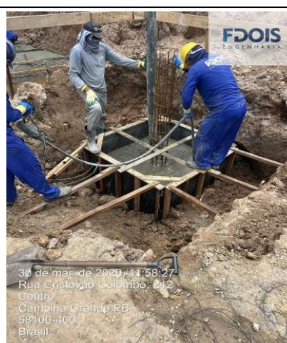
CONCRETAGEM DE BLOCO
