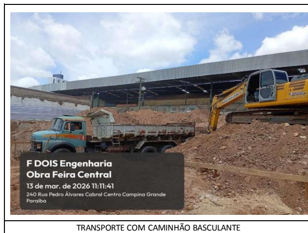
TRANSPORTE COM CAMINHÃO BASCULANTE
