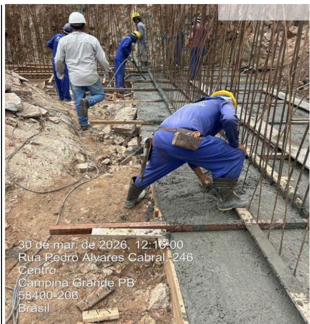
CONCRETAGEM DE CORTINA DE CONTENÇÃO
