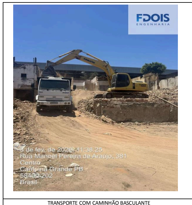
TRANSPORTE COM CAMINHÃO BASCULANTE
