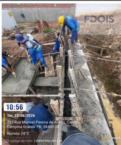
CONCRETAGEM DE CORTINA DE CONTENÇÃO
