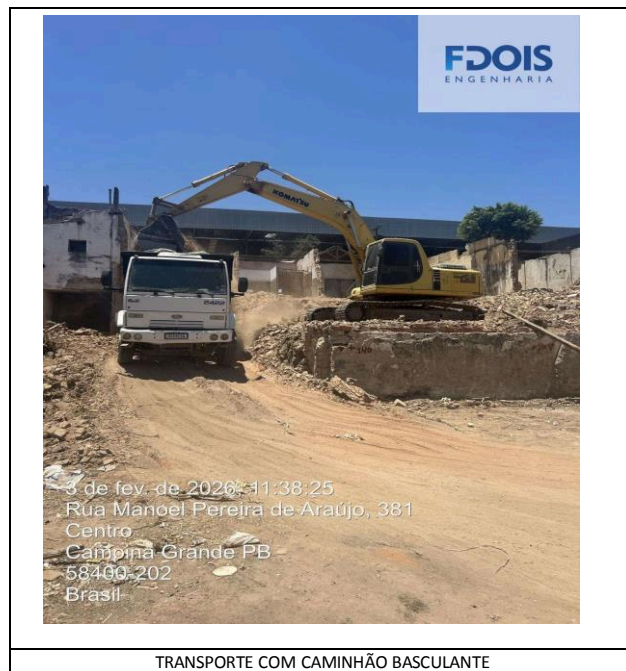
TRANSPORTE COM CAMINHÃO BASCULANTE
