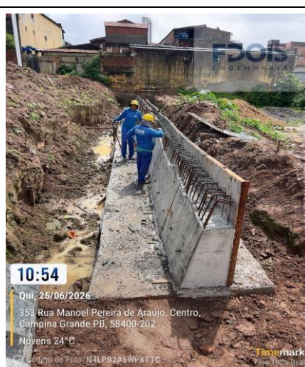
CONCRETAGEM DE CORTINA DE CONTENÇÃO
