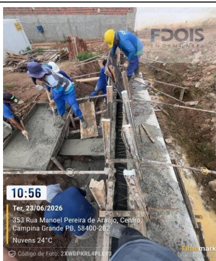
CONCRETAGEM DE CORTINA DE CONTENÇÃO
