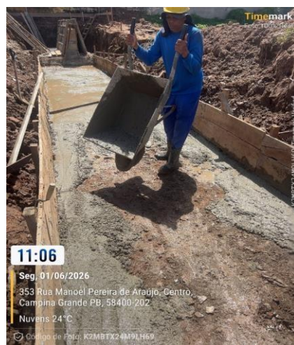
CONCRETO MAGRO PARA LASTRO
