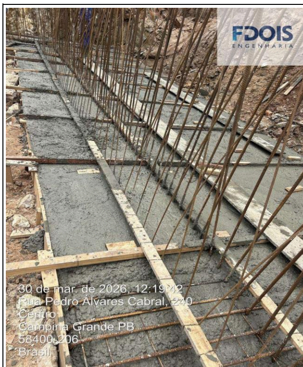
CONCRETAGEM DE CORTINA DE CONTENÇÃO
