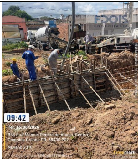
CONCRETAGEM DE CORTINA DE CONTENÇÃO
