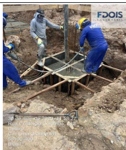
CONCRETAGEM DE BLOCO
