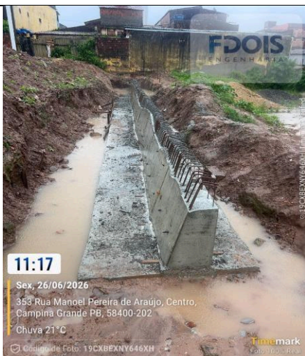
CONCRETAGEM DE CORTINA DE CONTENÇÃO
