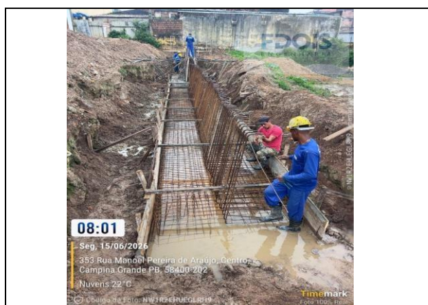
ARMAÇÃO DE CORTINA DE CONTENÇÃO EM CONCRETO ARMADO
