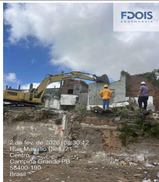
DEMOLIÇÃO DE ALVENARIA
