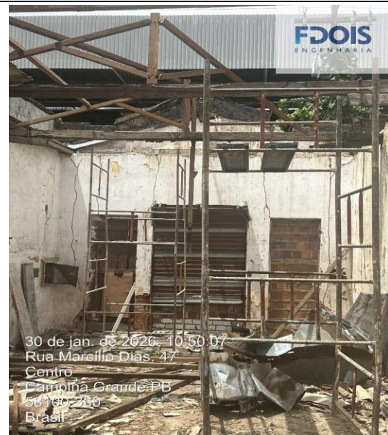
REMOÇÃO DE TELHAS DE FIBROCIMENTO
