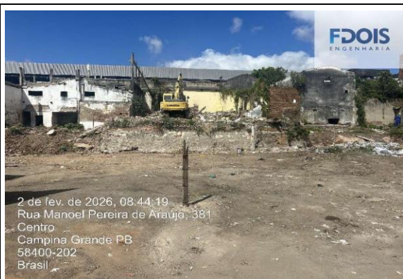
DEMOLIÇÃO DE ALVENARIA
