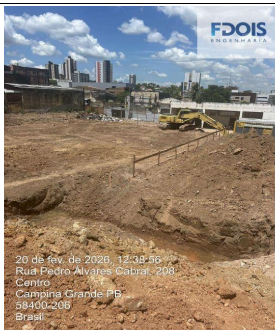
LOCAÇÃO CONVENCIONAL DE OBRA
