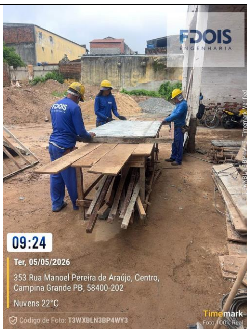
FABRICAÇÃO, MONTAGEM E DESMONTAGEM DE FÔRMA PARA CORTINA DE CONTENÇÃO
