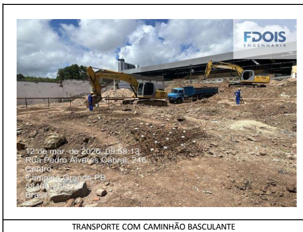
TRANSPORTE COM CAMINHÃO BASCULANTE
