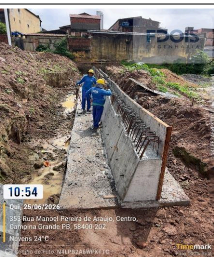
CONCRETAGEM DE CORTINA DE CONTENÇÃO
