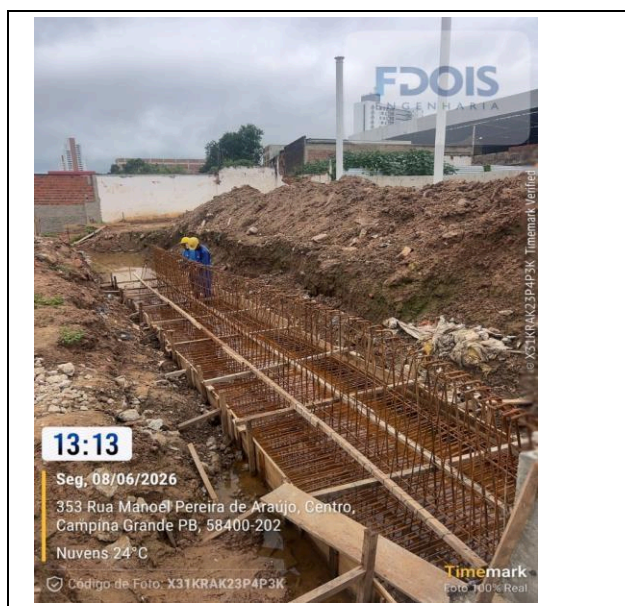
ARMAÇÃO DE CORTINA DE CONTENÇÃO EM CONCRETO ARMADO
