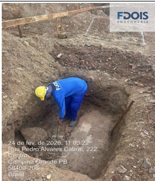
ESCAVAÇÃO MANUAL PARA BLOCO
