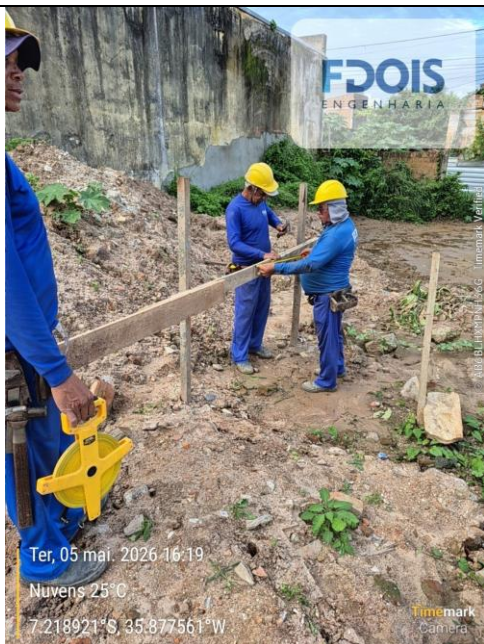
LOCAÇÃO CONVENCIONAL DE OBRA
