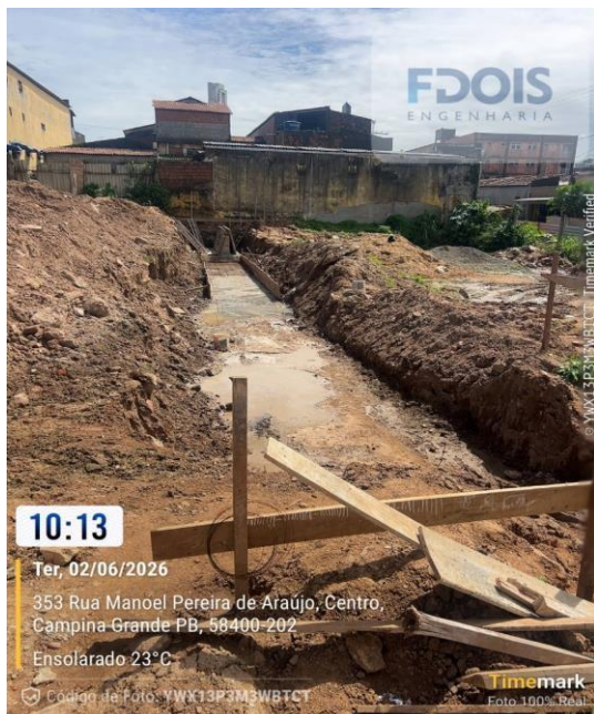
LOCAÇÃO CONVENCIONAL DE OBRA
