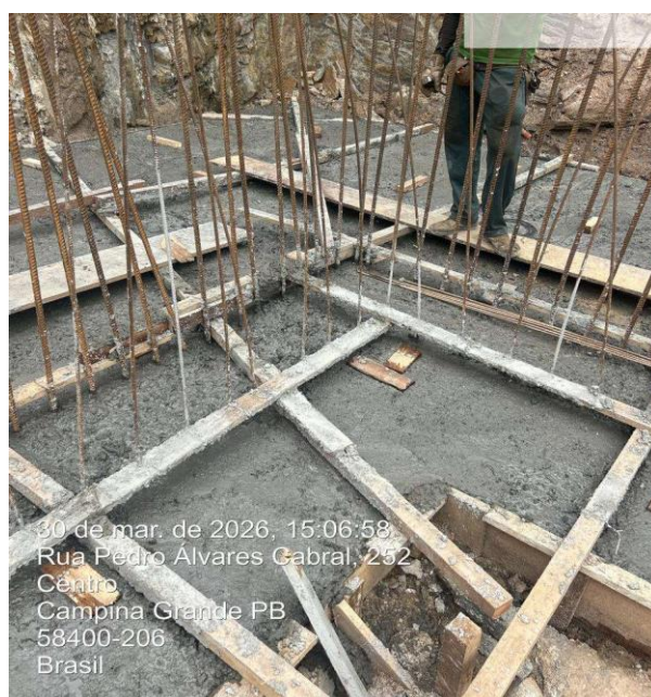
CONCRETAGEM DE CORTINA DE CONTENÇÃO
