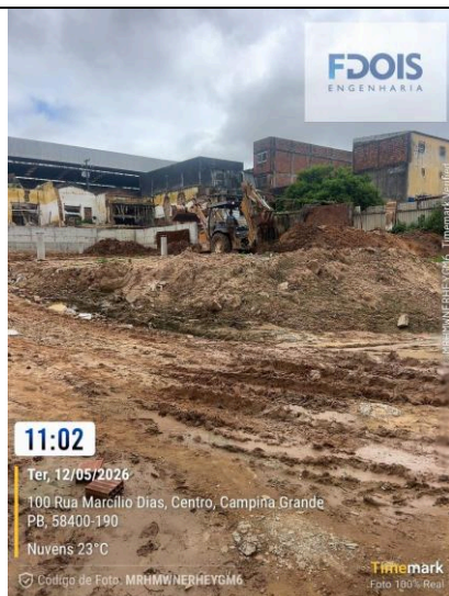
REATERRO MECANIZADO DE VALA COM MINICARREGADEIR
