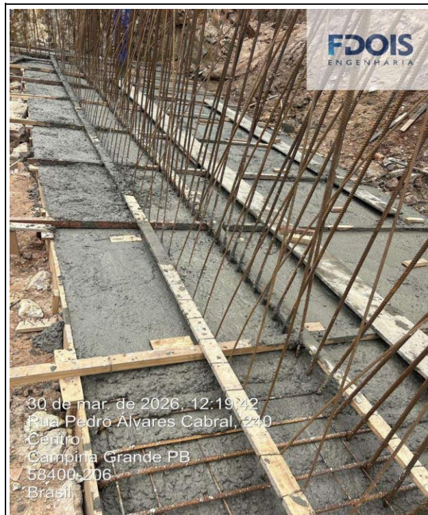
CONCRETAGEM DE CORTINA DE CONTENÇÃO
