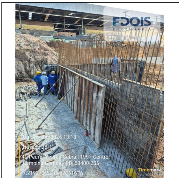
FABRICAÇÃO, MONTAGEM E DESMONTAGEM DE FÔRMA PARA CORTINA DE CONTENÇÃO, EM CHAPA DE MADEIRA COMPENSADA PLASTIFICADA
