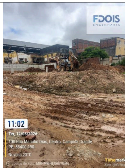
REATERRO MECANIZADO DE VALA COM MINICARREGADEIR
