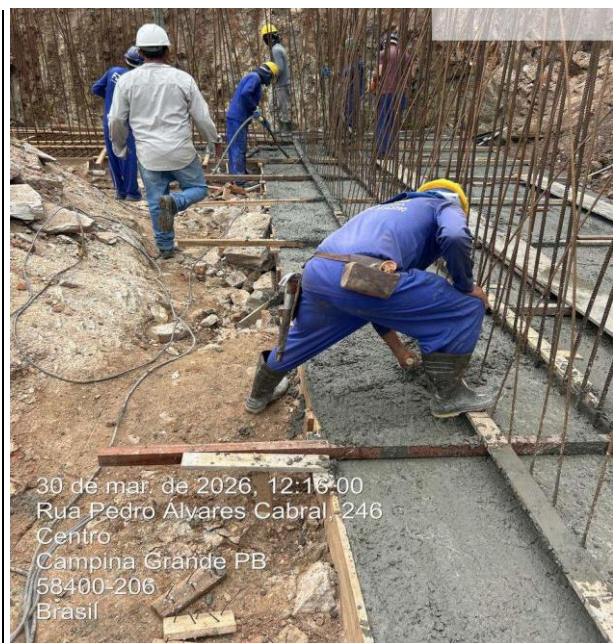
CONCRETAGEM DE CORTINA DE CONTENÇÃO
