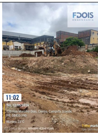
REATERRO MECANIZADO DE VALA COM MINICARREGADEIR
