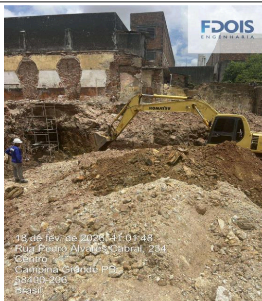
ESCAVAÇÃO MECANIZADA DE VALA PARA CONTENÇÃO
