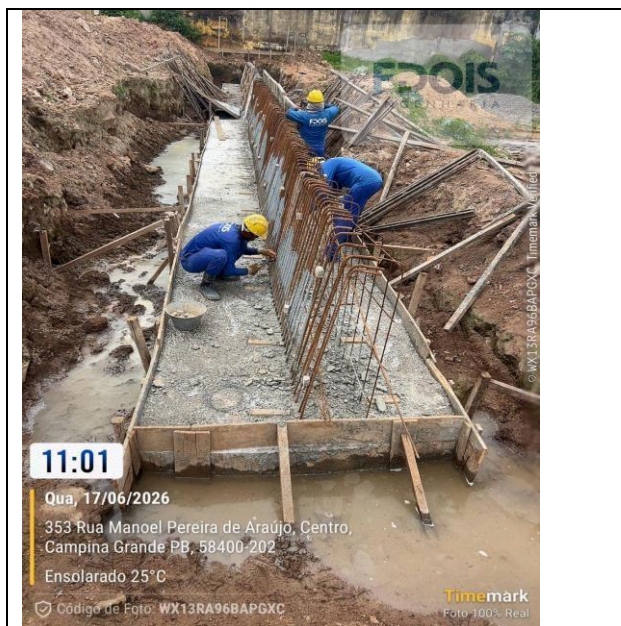
ARMAÇÃO DE CORTINA DE CONTENÇÃO EM CONCRETO ARMADO
