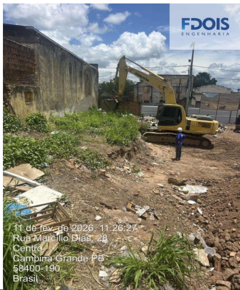
LIMPEZA MECANIZADA DE CAMADA VEGETAL
