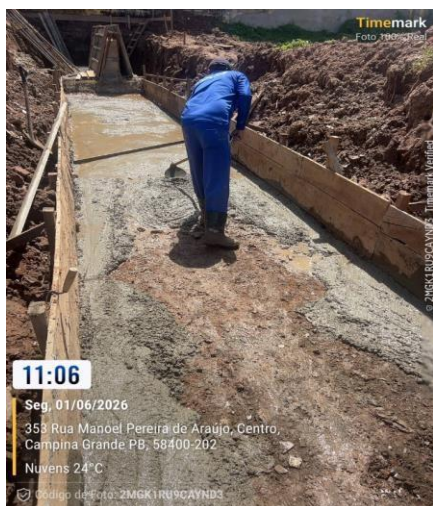
CONCRETO MAGRO PARA LASTRO
