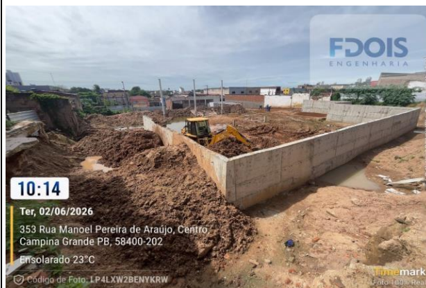
REATERRO MECANIZADO DE VALA COM MINICARREGADEIRA
