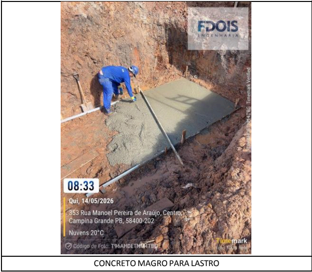
CONCRETO MAGRO PARA LASTRO
