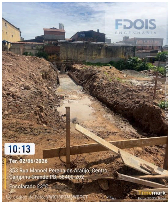
LOCAÇÃO CONVENCIONAL DE OBRA
