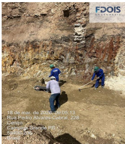
ESCAVAÇÃO MANUAL PARA BLOCO DE COROAMENTO OU SAPATA
