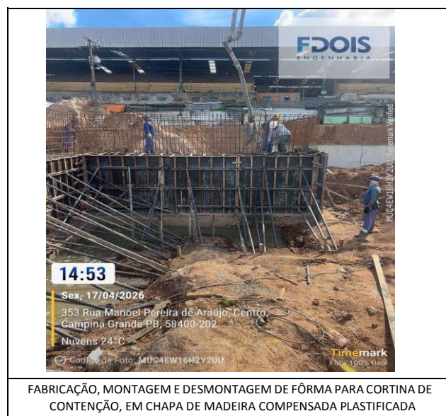
FABRICAÇÃO, MONTAGEM E DESMONTAGEM DE FÔRMA PARA CORTINA DE CONTENÇÃO, EM CHAPA DE MADEIRA COMPENSADA PLASTIFICADA
