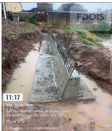
CONCRETAGEM DE CORTINA DE CONTENÇÃO
