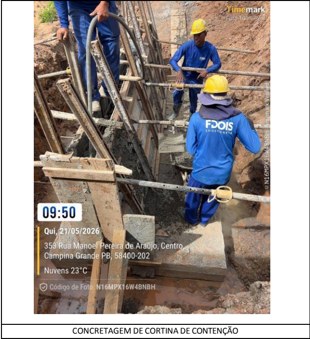
CONCRETAGEM DE CORTINA DE CONTENÇÃO
