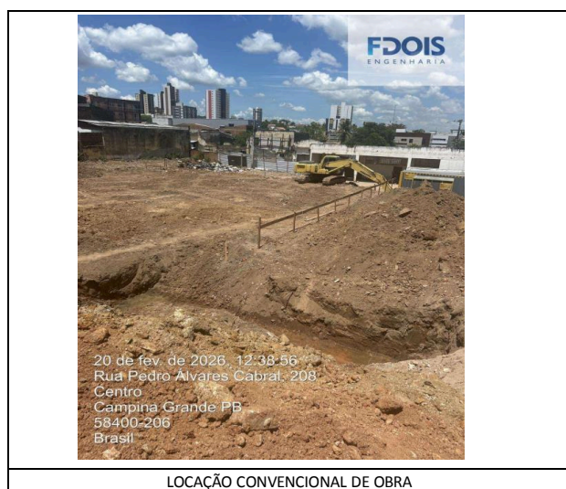
LOCAÇÃO CONVENCIONAL DE OBRA
