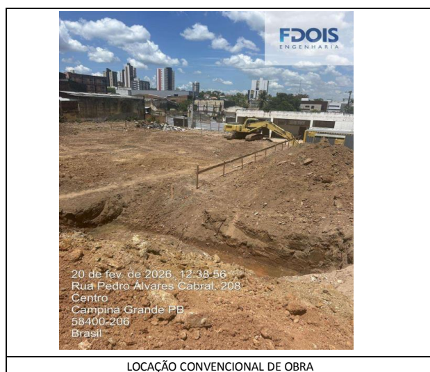
LOCAÇÃO CONVENCIONAL DE OBRA
