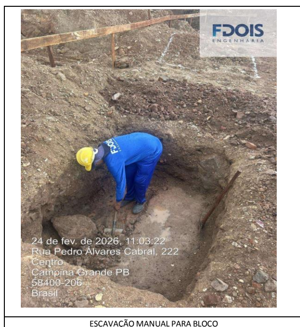
ESCAVAÇÃO MANUAL PARA BLOCO
