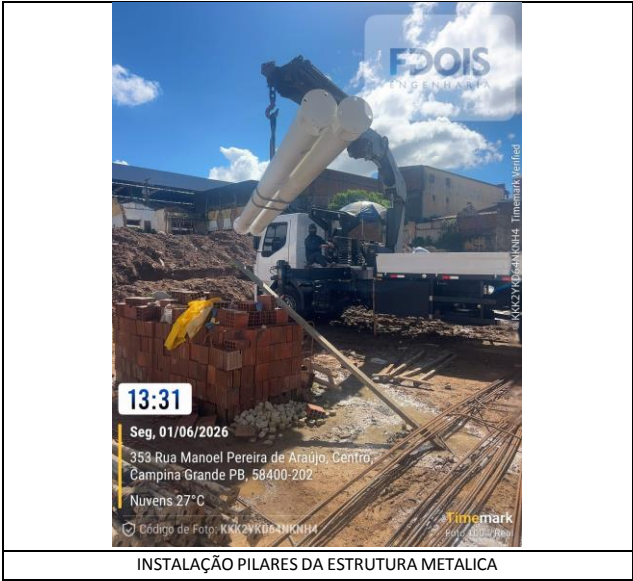
INSTALAÇÃO PILARES DA ESTRUTURA METALICA
