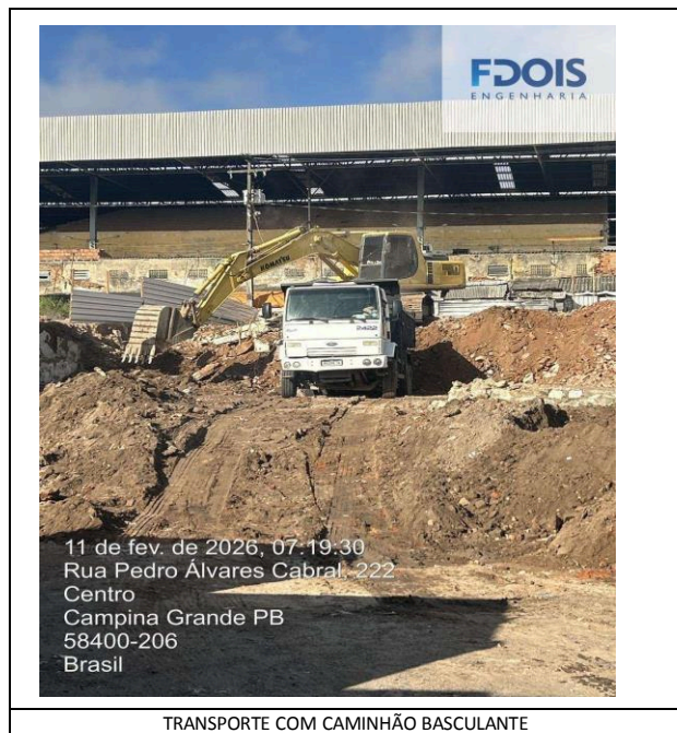
TRANSPORTE COM CAMINHÃO BASCULANTE
