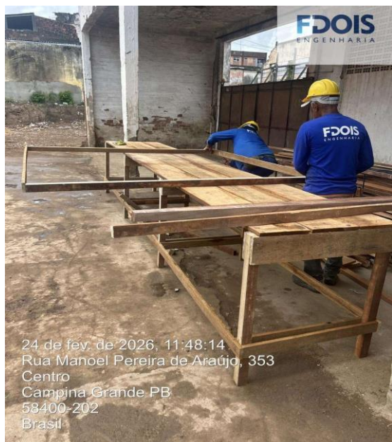
FABRICAÇÃO, MONTAGEM E DESMONTAGEM DE FÔRMA PARA CORTINA DE CONTENÇÃO
