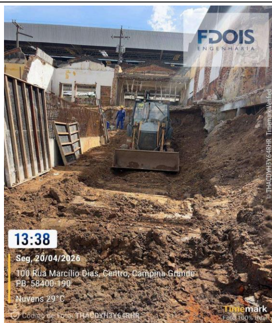
REATERRO MECANIZADO DE VALA COM MINICARREGADEIRA
