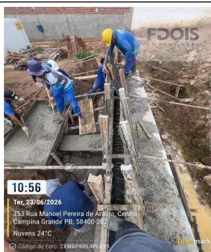
CONCRETAGEM DE CORTINA DE CONTENÇÃO
