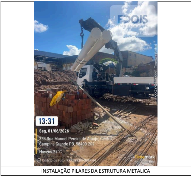
INSTALAÇÃO PILARES DA ESTRUTURA METALICA
