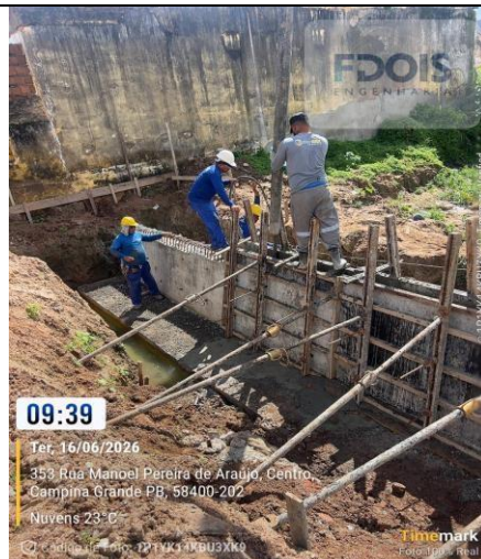
CONCRETAGEM DE CORTINA DE CONTENÇÃO
