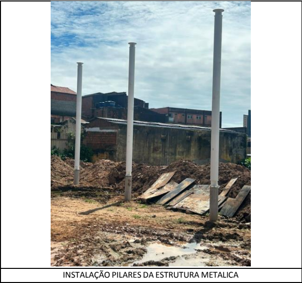
INSTALAÇÃO PILARES DA ESTRUTURA METALICA
