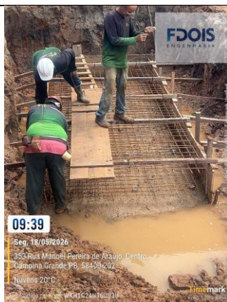
ARMAÇÃO DE CORTINA DE CONTENÇÃO EM CONCRETO ARMADO
