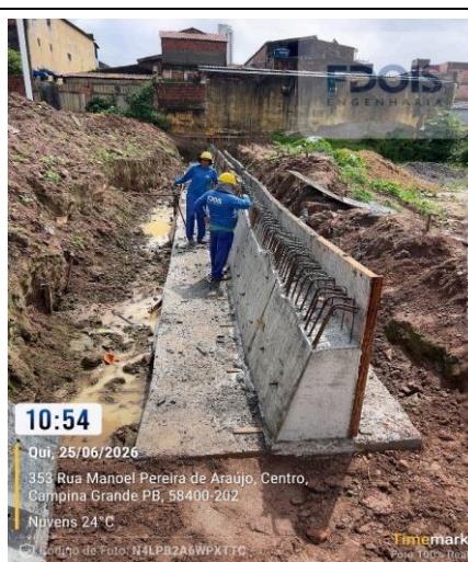
CONCRETAGEM DE CORTINA DE CONTENÇÃO
