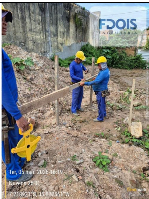
LOCAÇÃO CONVENCIONAL DE OBRA
