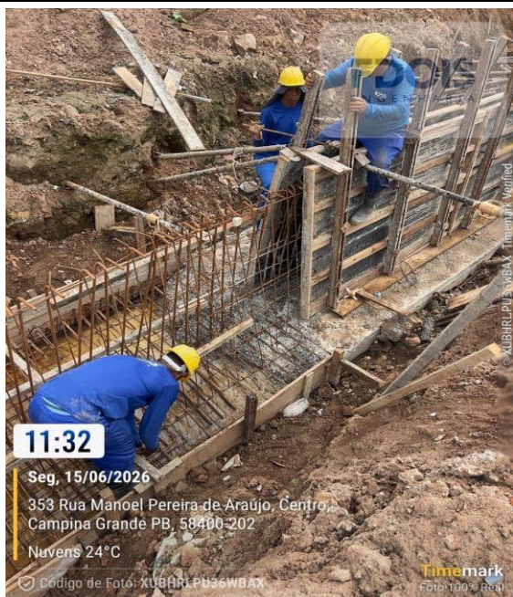
FABRICAÇÃO, MONTAGEM E DESMONTAGEM DE FÔRMA PARA CORTINA DE CONTENÇÃO
