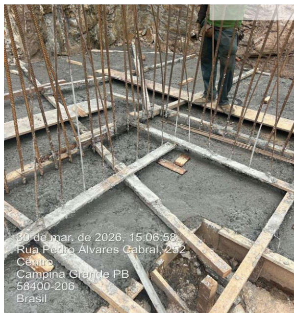
CONCRETAGEM DE CORTINA DE CONTENÇÃO
