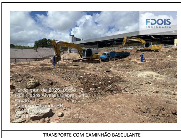
TRANSPORTE COM CAMINHÃO BASCULANTE
