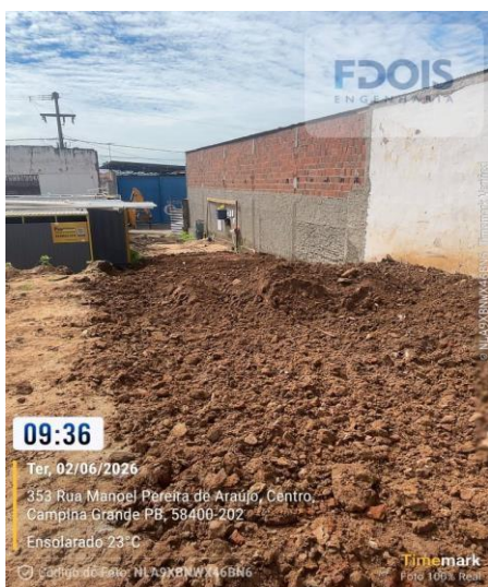
REATERRO MECANIZADO DE VALA COM MINICARREGADEIRA
