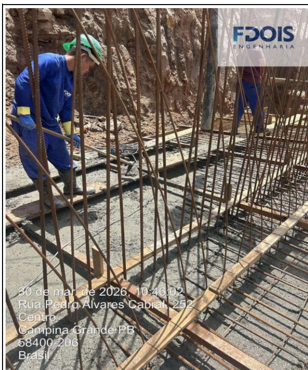
CONCRETAGEM DE CORTINA DE CONTENÇÃO
