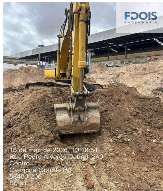
TRANSPORTE COM CAMINHÃO BASCULANTE
