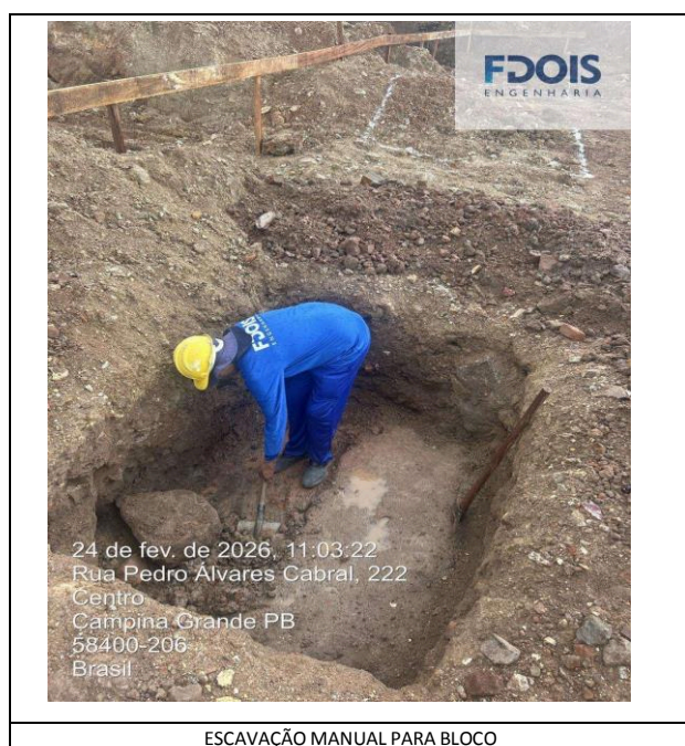
ESCAVAÇÃO MANUAL PARA BLOCO
