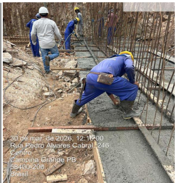
CONCRETAGEM DE CORTINA DE CONTENÇÃO
