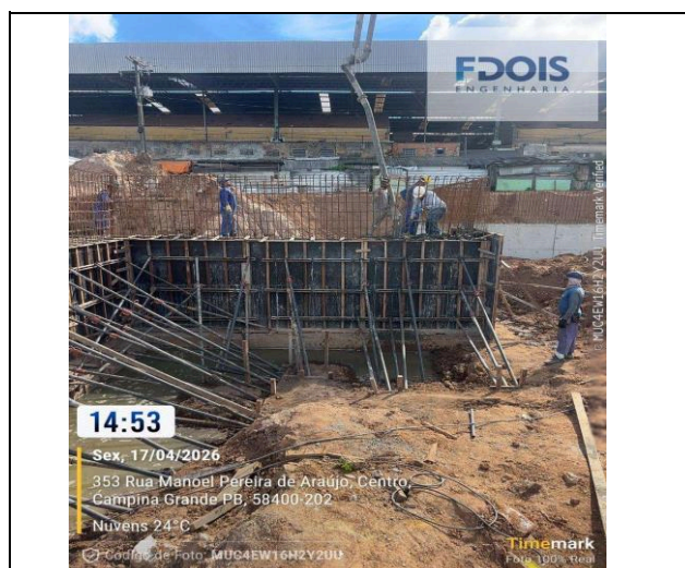
FABRICAÇÃO, MONTAGEM E DESMONTAGEM DE FÔRMA PARA CORTINA DE CONTENÇÃO, EM CHAPA DE MADEIRA COMPENSADA PLASTIFICADA
