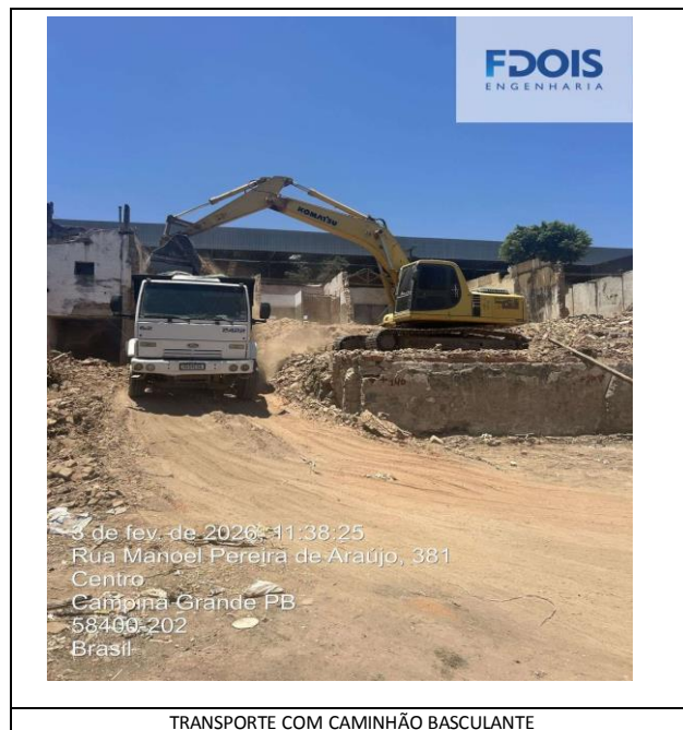
TRANSPORTE COM CAMINHÃO BASCULANTE
