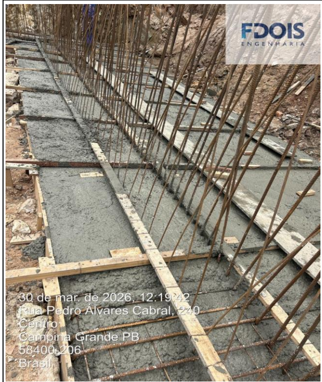
CONCRETAGEM DE CORTINA DE CONTENÇÃO
