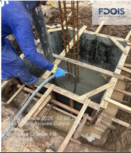
CONCRETAGEM DE BLOCO
