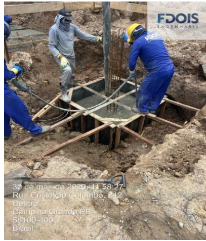
CONCRETAGEM DE BLOCO
