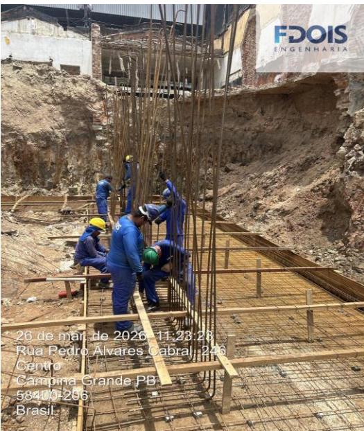
ARMAÇÃO DE CORTINA DE CONTENÇÃO EM CONCRETO ARMADO
