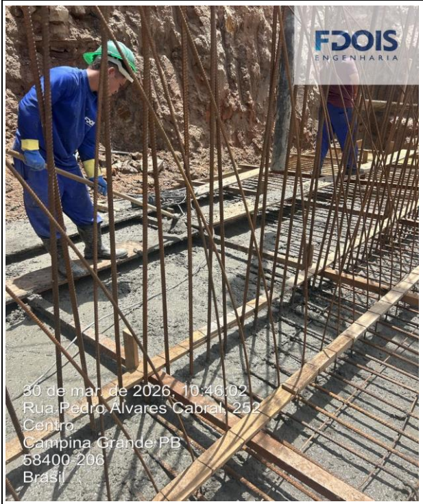
CONCRETAGEM DE CORTINA DE CONTENÇÃO
