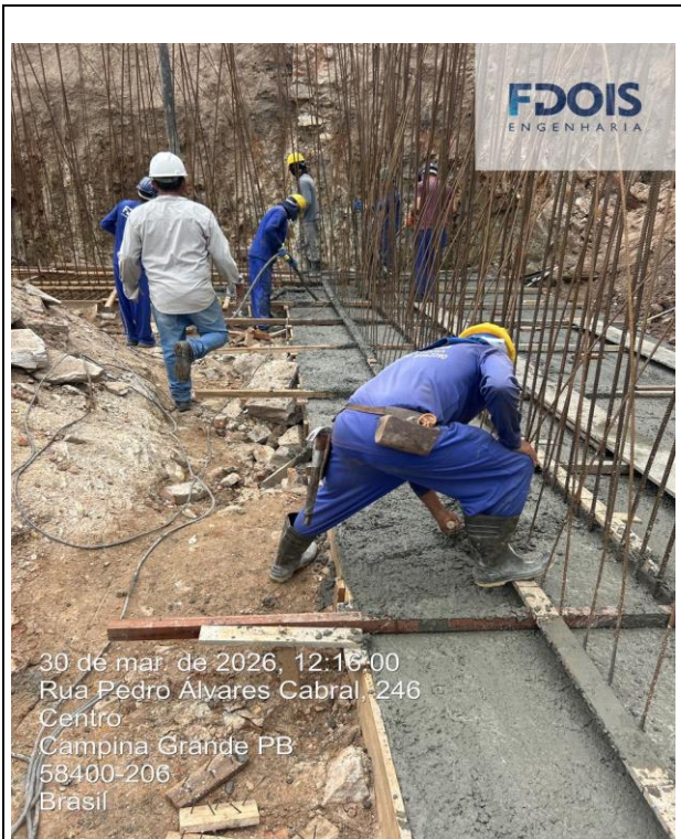
CONCRETAGEM DE CORTINA DE CONTENÇÃO
