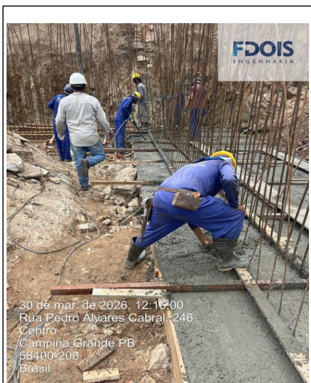
CONCRETAGEM DE CORTINA DE CONTENÇÃO
