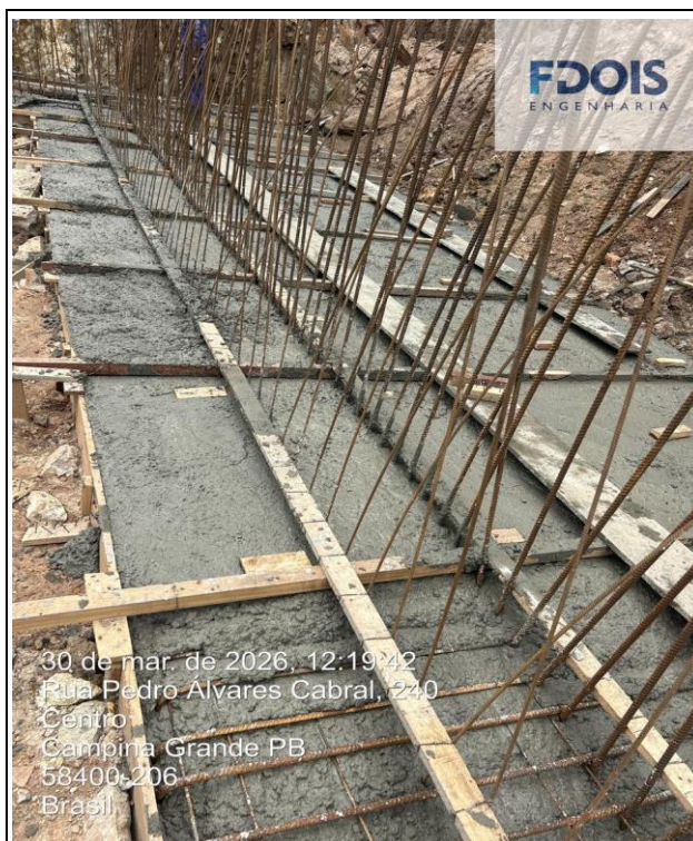
CONCRETAGEM DE CORTINA DE CONTENÇÃO
