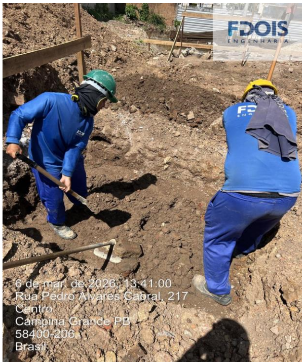
REATERRO MANUAL DE VALAS
