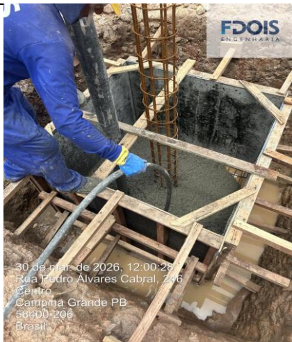
CONCRETAGEM DE BLOCO
