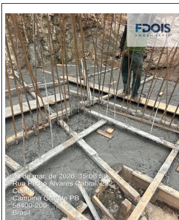
CONCRETAGEM DE CORTINA DE CONTENÇÃO
