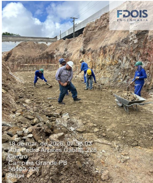
REATERRO MANUAL DE VALAS
