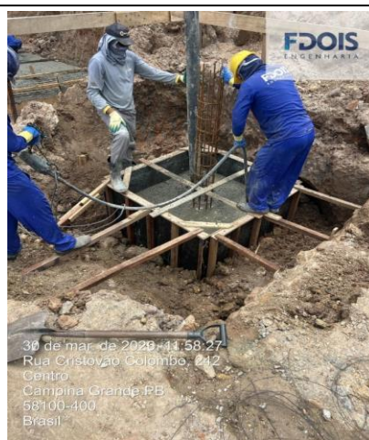
CONCRETAGEM DE BLOCO
