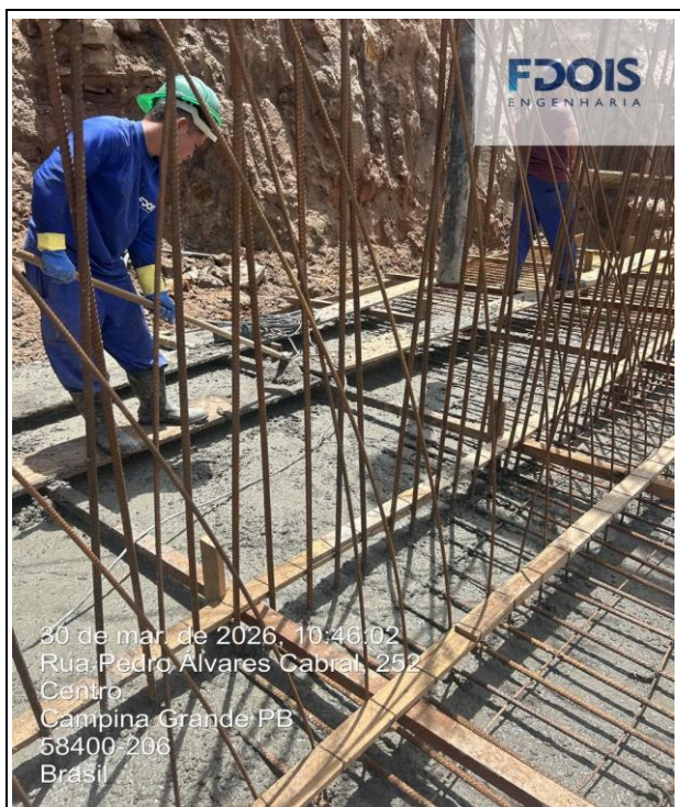
CONCRETAGEM DE CORTINA DE CONTENÇÃO
