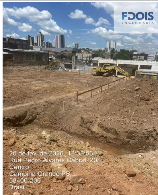
LOCAÇÃO CONVENCIONAL DE OBRA
