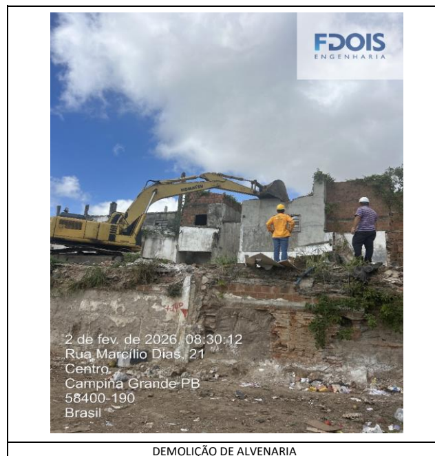
DEMOLIÇÃO DE ALVENARIA
