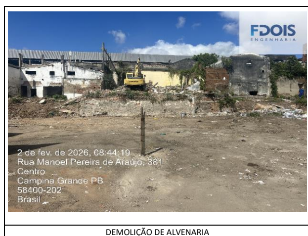
DEMOLIÇÃO DE ALVENARIA
