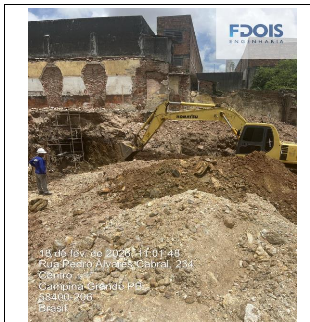
ESCAVAÇÃO MECANIZADA DE VALA PARA CONTENÇÃO
