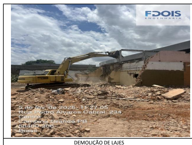
DEMOLIÇÃO DE LAJES
