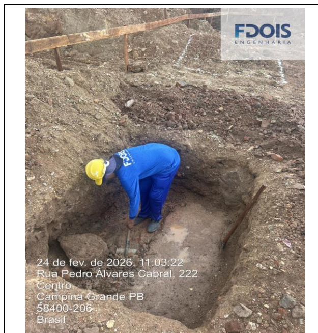
ESCAVAÇÃO MANUAL PARA BLOCO
