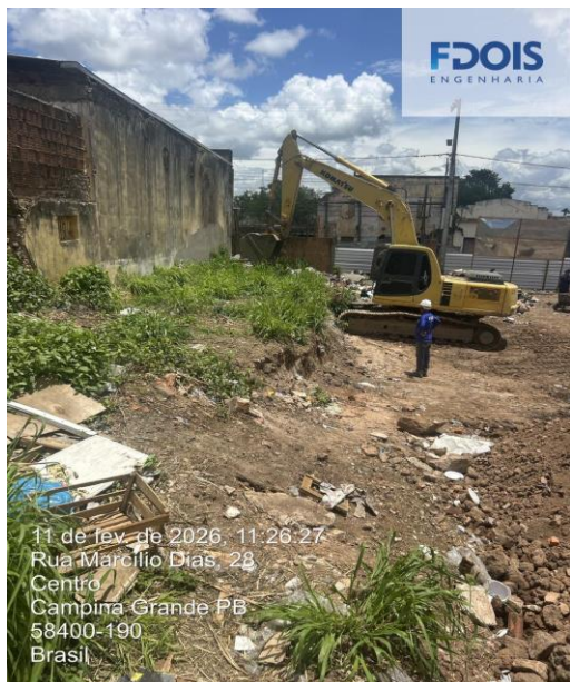
LIMPEZA MECANIZADA DE CAMADA VEGETAL
