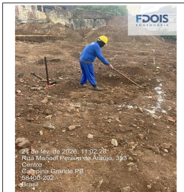
ESCAVAÇÃO MANUAL PARA BLOCO
