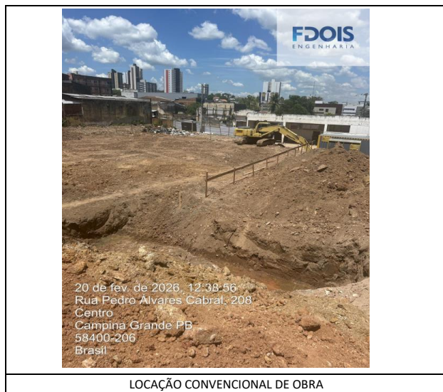
LOCAÇÃO CONVENCIONAL DE OBRA
