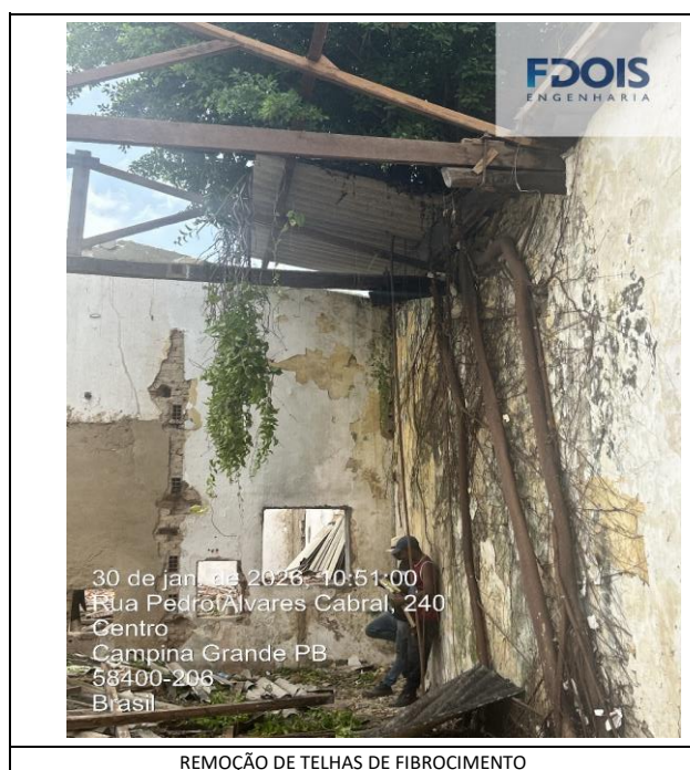
REMOÇÃO DE TELHAS DE FIBROCIMENTO
