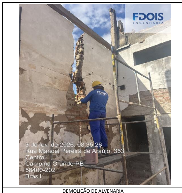
DEMOLIÇÃO DE ALVENARIA
