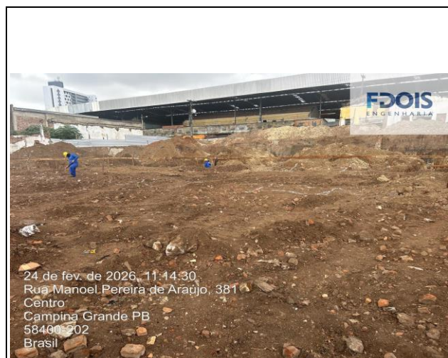
ESCAVAÇÃO MECANIZADA DE VALA PARA CONTENÇÃO
