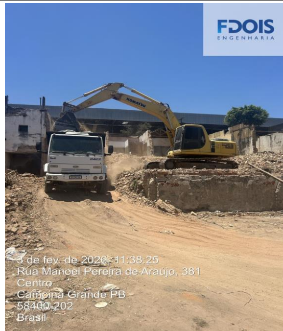
TRANSPORTE COM CAMINHÃO BASCULANTE
