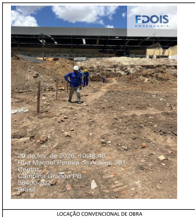
LOCAÇÃO CONVENCIONAL DE OBRA
