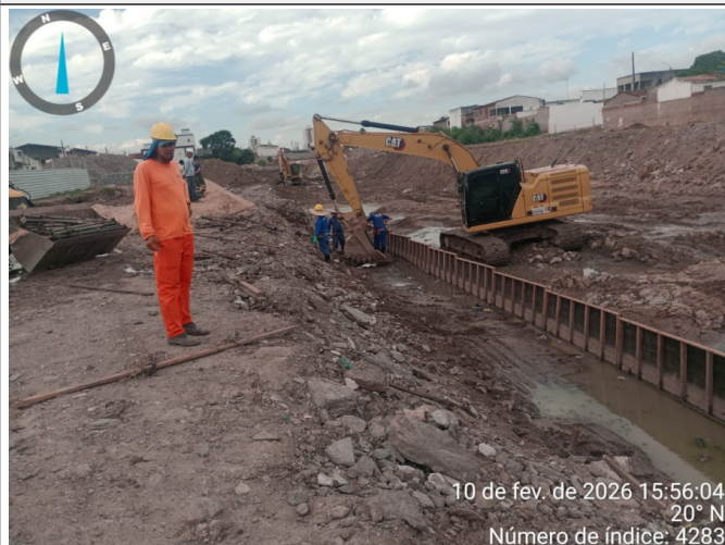
Recolhimento dos materiais da forma do lastro do canal principal.
