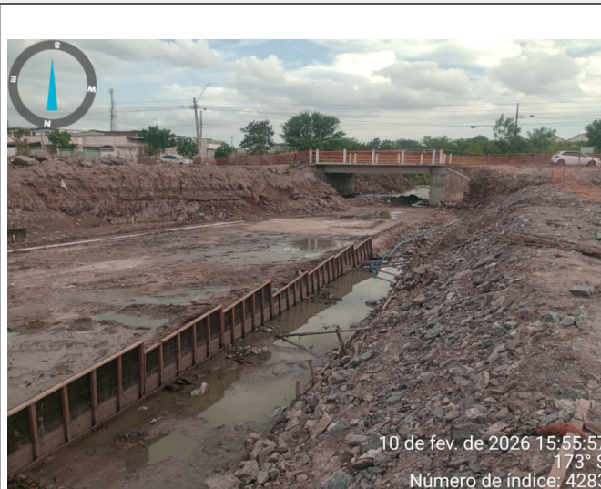
Recolhimento dos materiais da forma do lastro do canal principal.
