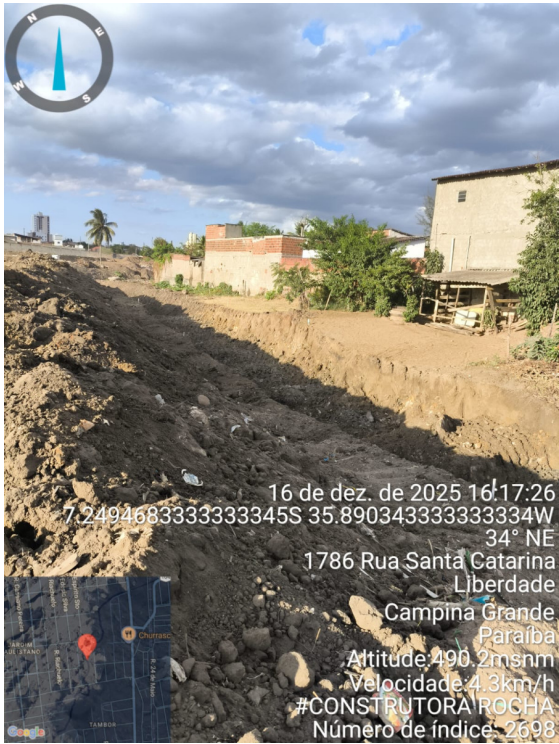
Desvio do canal
