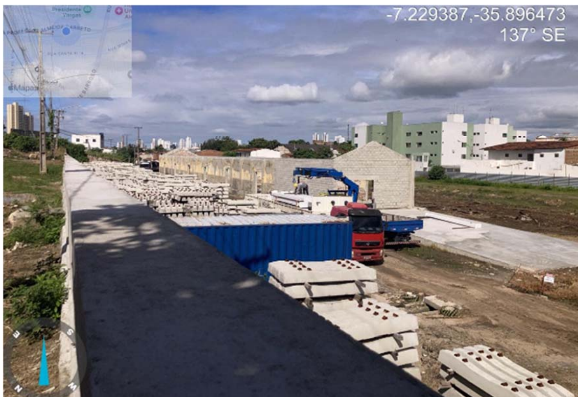
EXECUÇÃO DA ESTRUTURA METÁLICA
