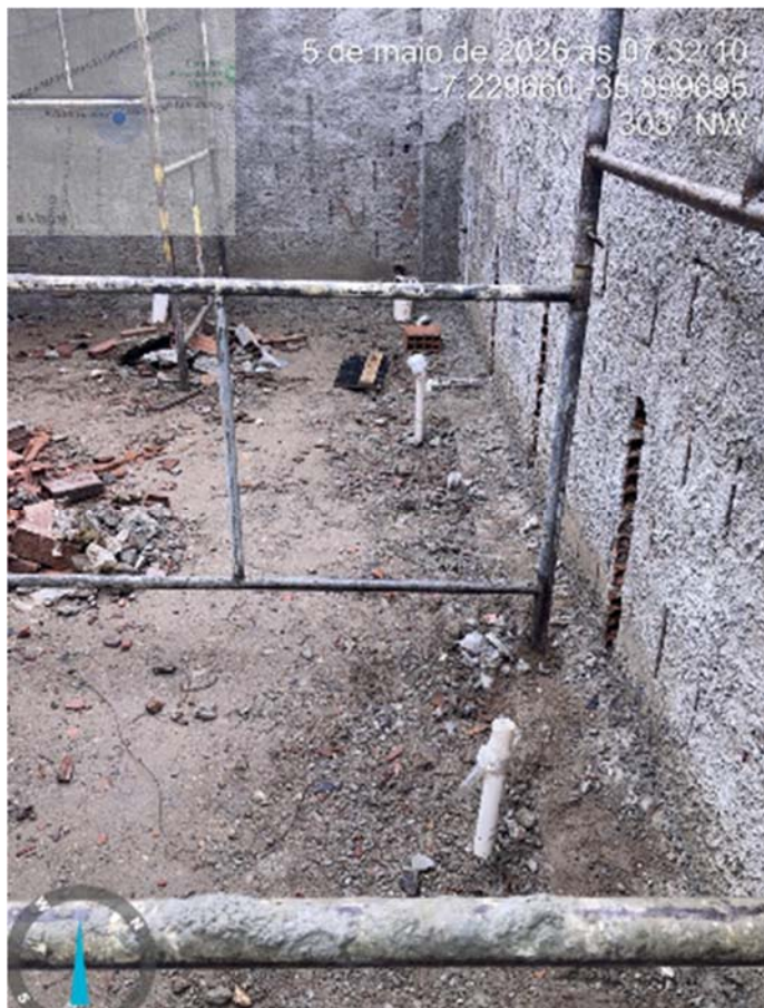
EXECUÇÃO DE REDE DE ESGOTO
