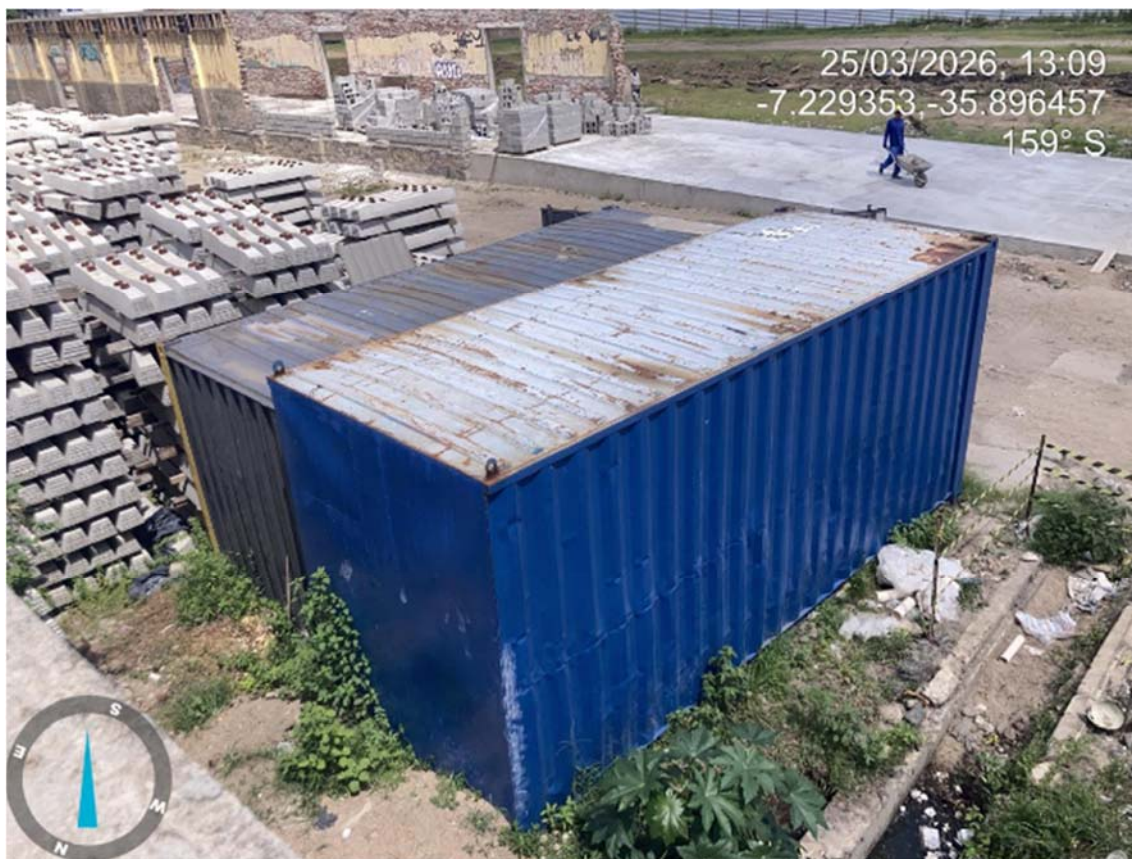
-LOCAÇÃO DE CONTEINER
