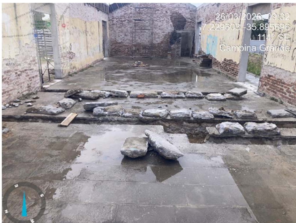
EXECUÇÃO DE REDE DE ESGOTO
