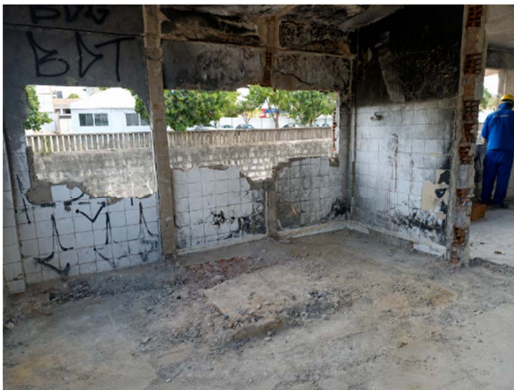
-ALVENARIA DE VEDAÇÃO COM BLOCOS CERÂMICOS
