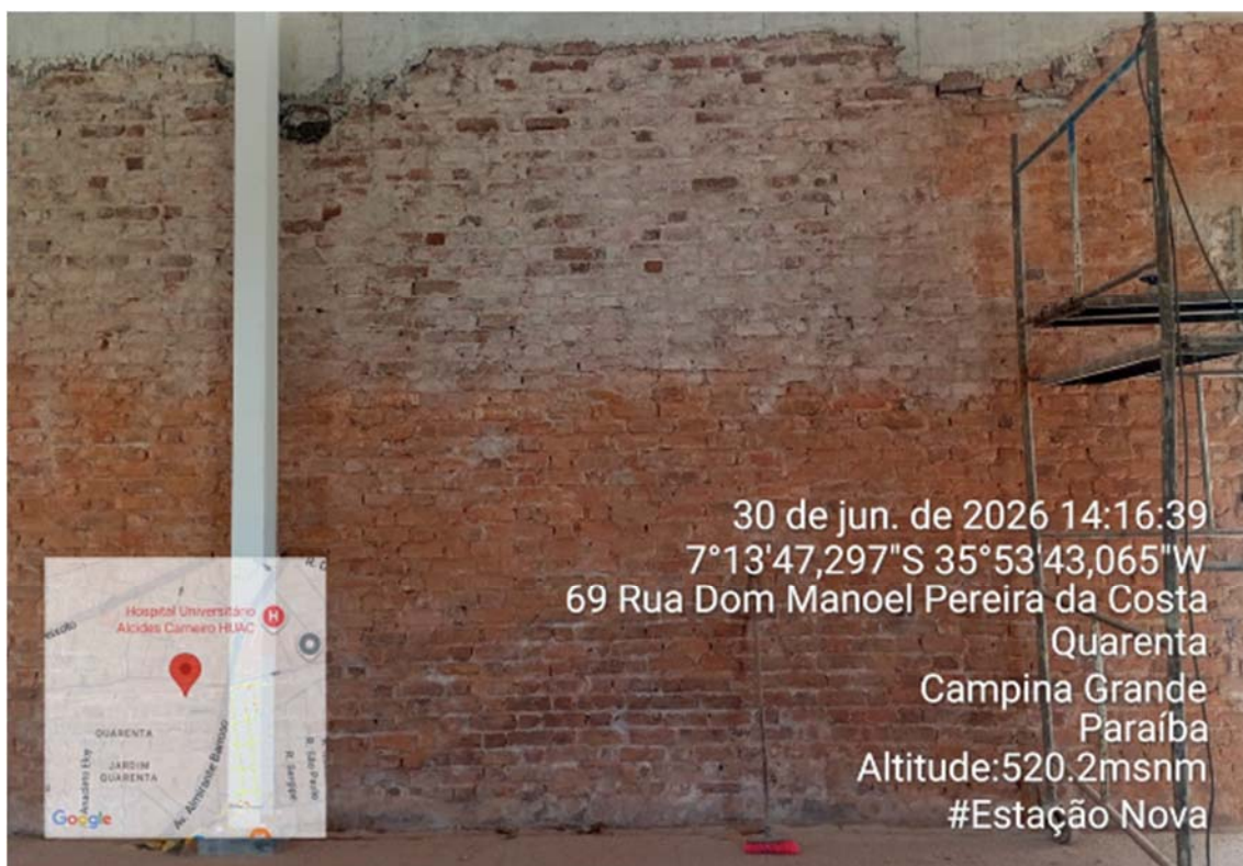
-PREPARO DE SUBSTRATO POR ESCARIFICAÇÃO
