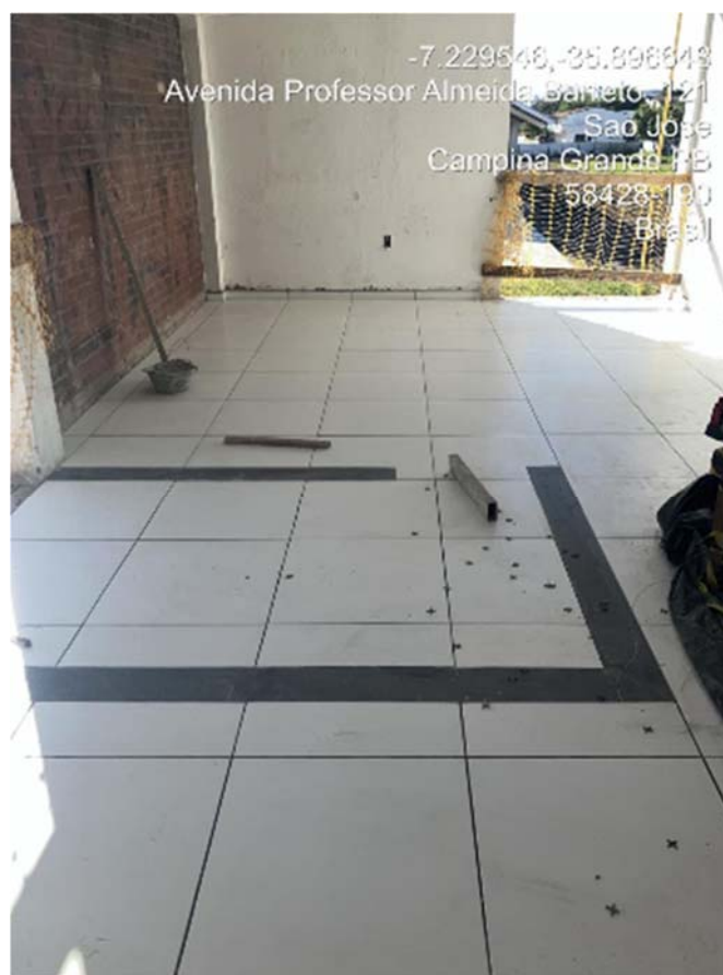
-PISO EM GRANITO APLICADO EM AMBIENTES INTERNOS.
