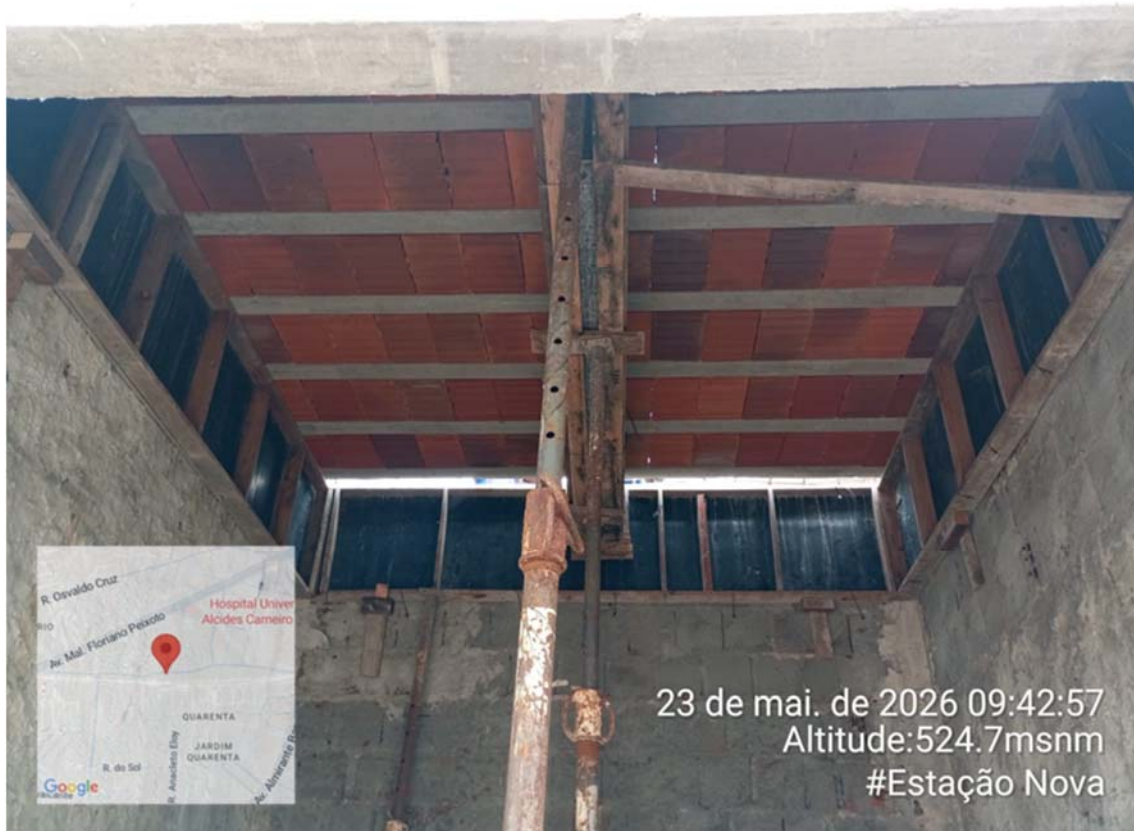
-EXECUÇÃO DE LAJE TRELIÇADA
