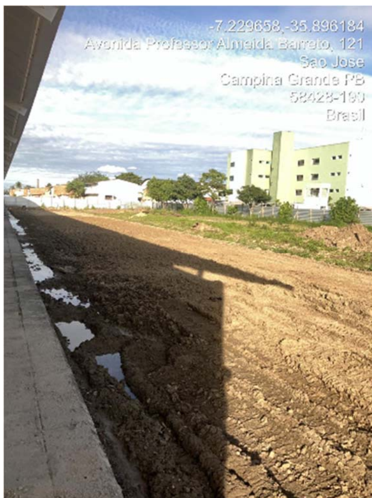
-LOCAL DO DESMONTE DE ROCHA DE 3ª CATEGORIA
