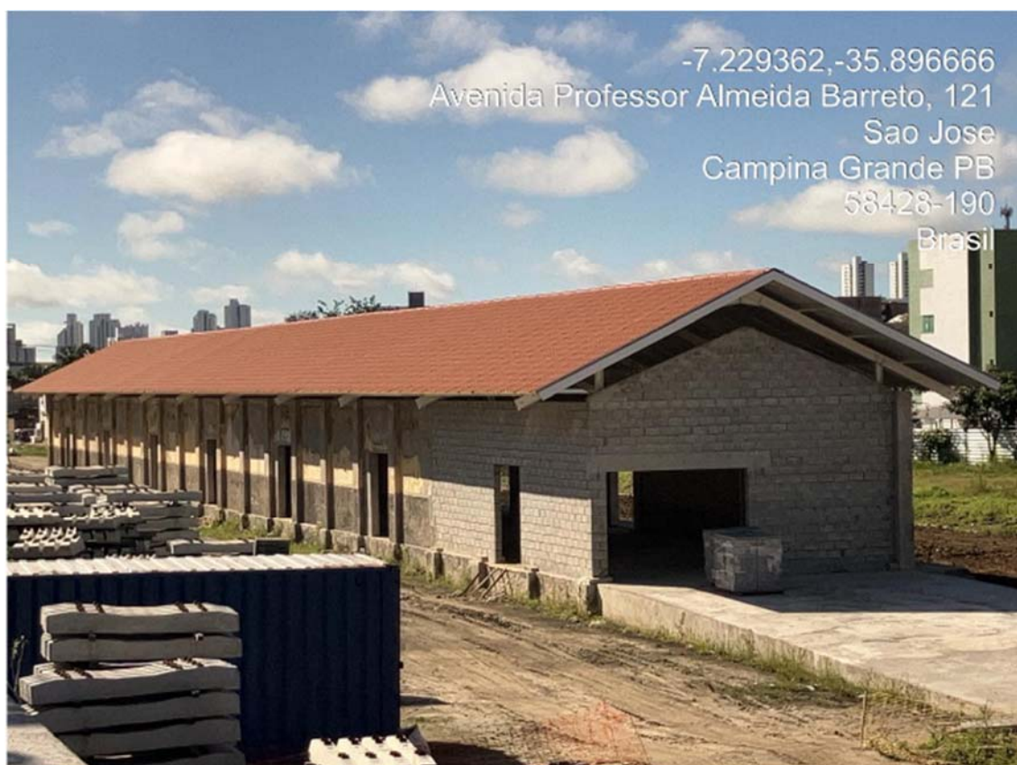
-BLOCO DE CONCRETO ESTRUTURAL
