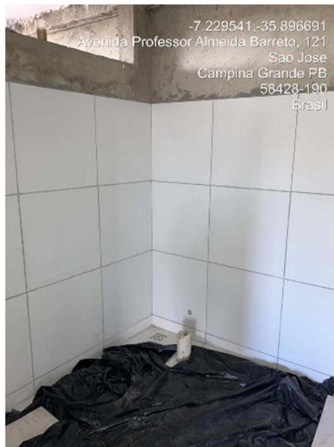
-REVESTIMENTO CERÂMICO DE PAREDE
