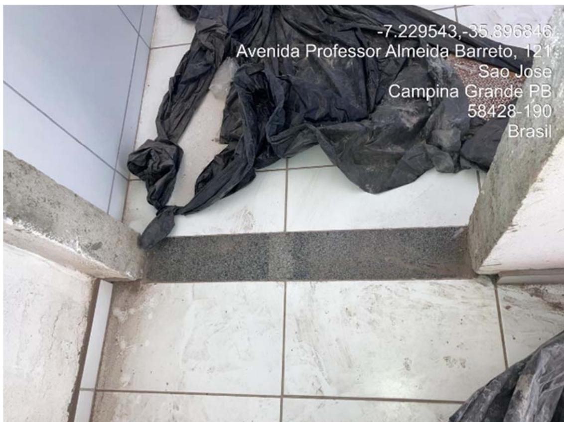
-SOLEIRA EM GRANITO, LARGURA 15 CM, ESPESSURA 2,0
