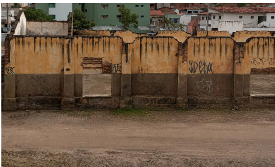
-REMOÇÃO DE TESSOURAS
