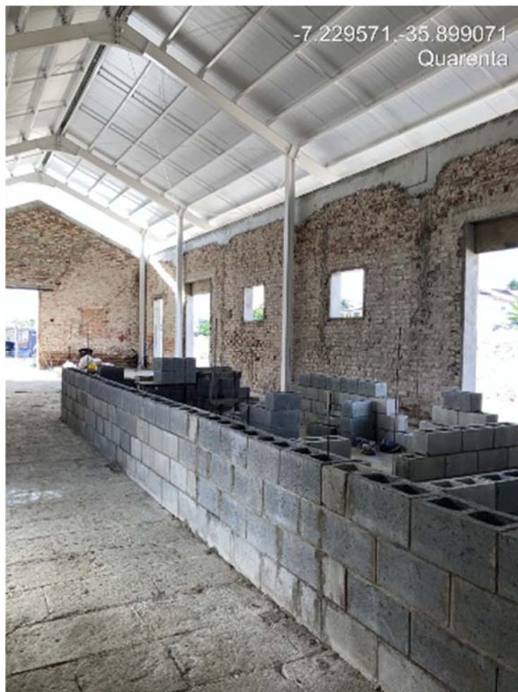
-BLOCO DE CONCRETO ESTRUTURAL
