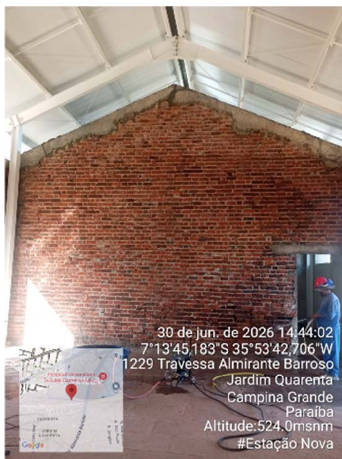
-LAVAGEM DE PAREDE COM CLORO LIQUIDO
