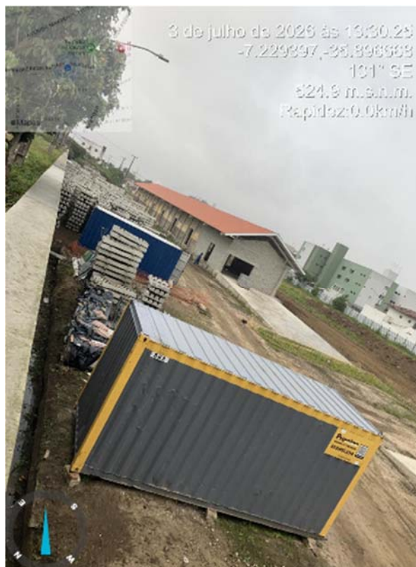
-LOCAÇÃO DE CONTEINER ALMOXARIFADO
