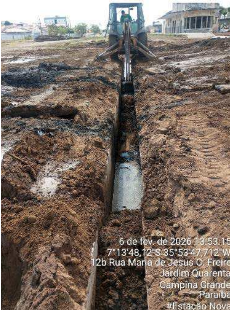
-LIMPEZA E DESOBSTRUÇÃO MECANIZADA DE GALERIA
