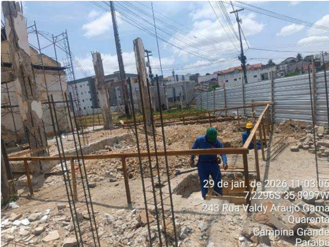
-ESTRUTURA PARA FUNDAÇÃO
