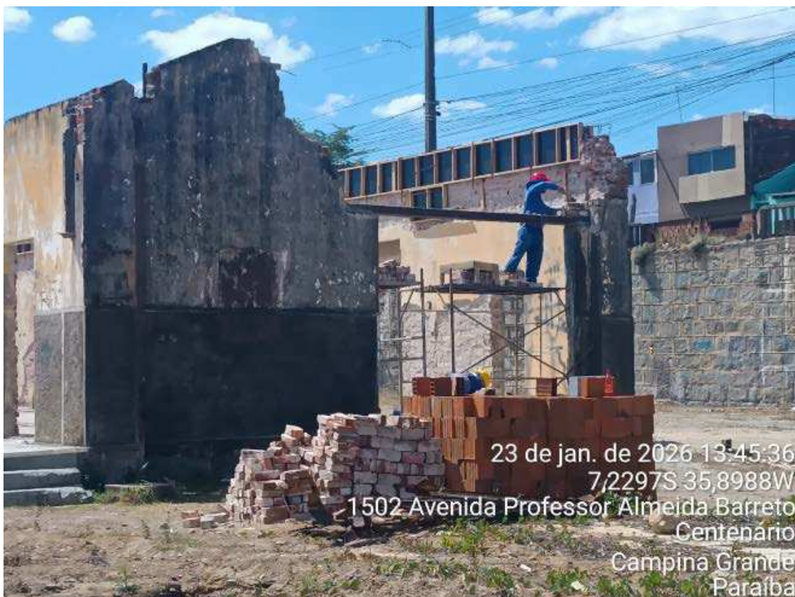
-DEMOLIÇÃO DE ALVENARIA
