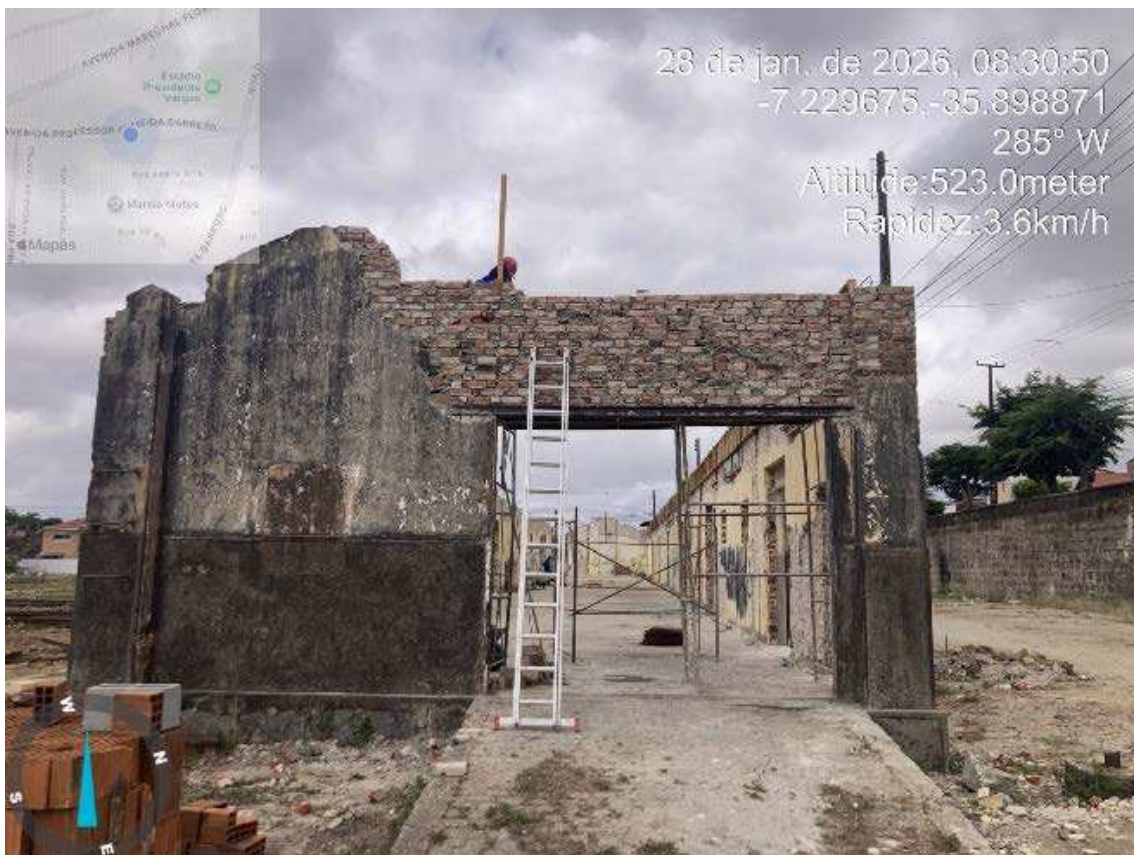
-ALVENARIA DE VEDAÇÃO
