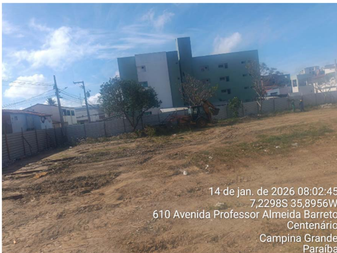
FOTO 07 - LIMPEZA MECANIZADA DE CAMADA VEGETAL
