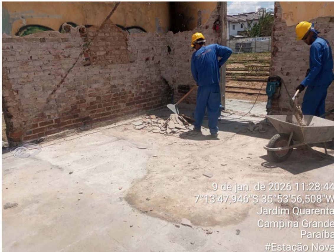
FOTO 03 – DEMOLIÇÃO DE PISO DE CONCRETO SIMPLES
