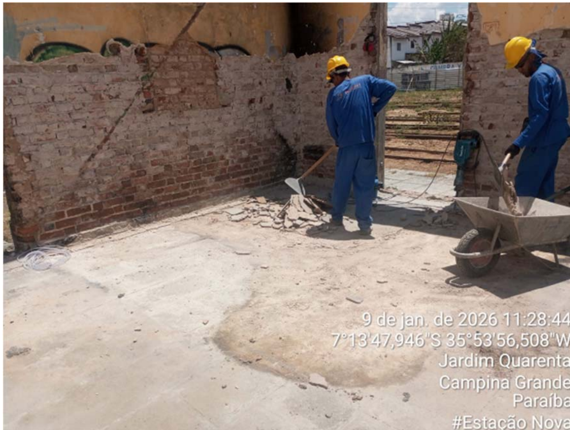
FOTO 03 – DEMOLIÇÃO DE PISO DE CONCRETO SIMPLES
