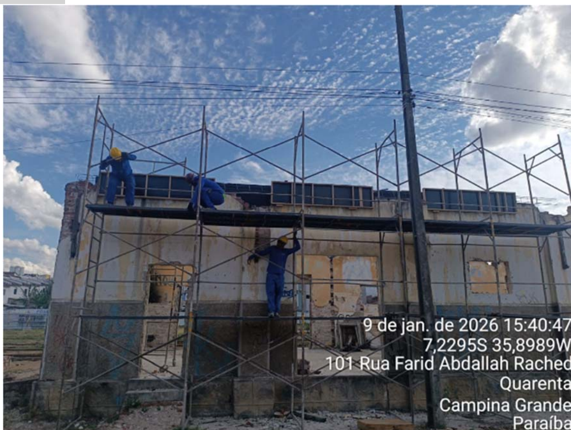
FOTO 02 – EXECUÇÃO DE ESTRUTURA PARA VIGAS EM CONCRETO ARMADO
