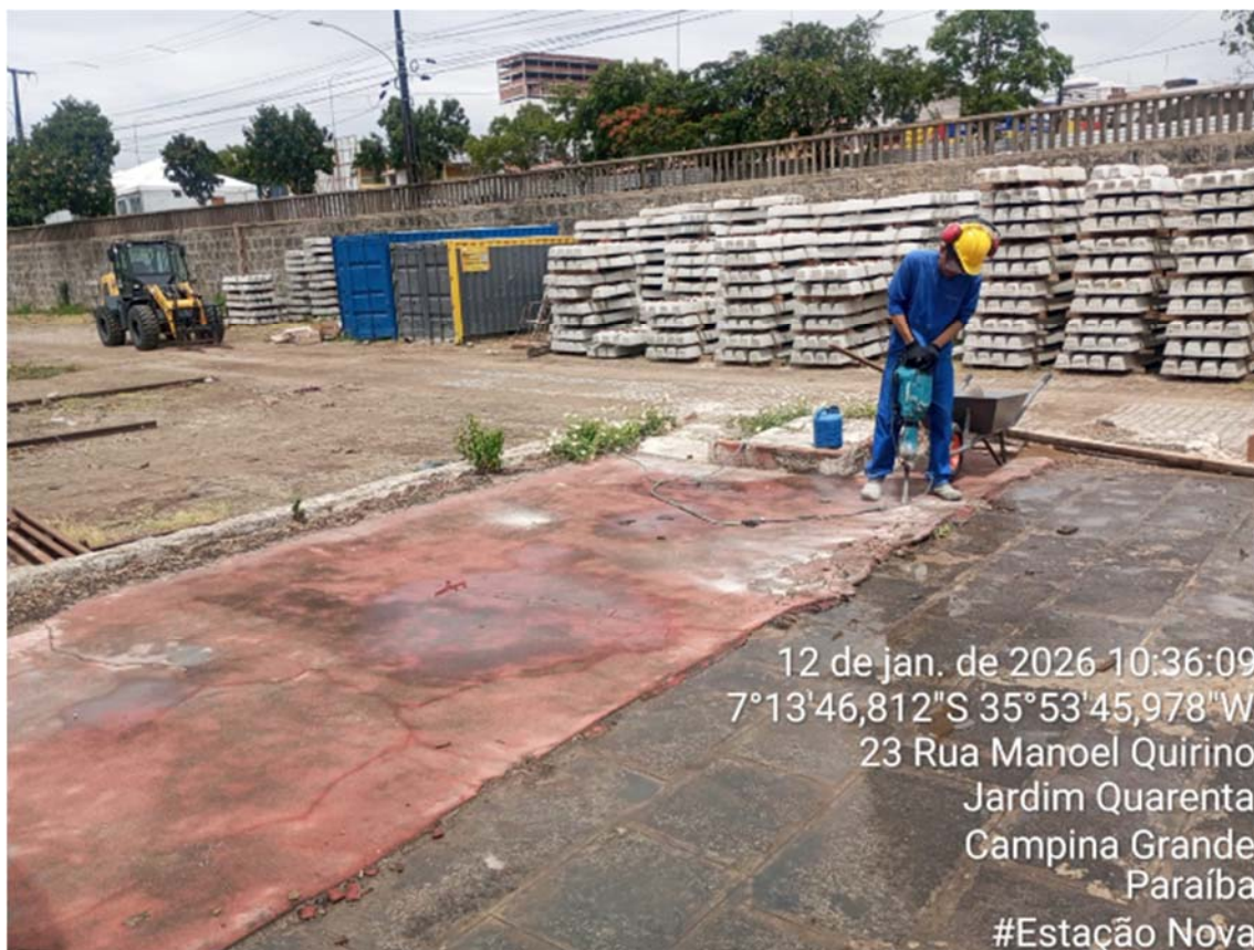
FOTO 06 – DEMOLIÇÃO DE PISO DE CONCRETO SIMPLES
