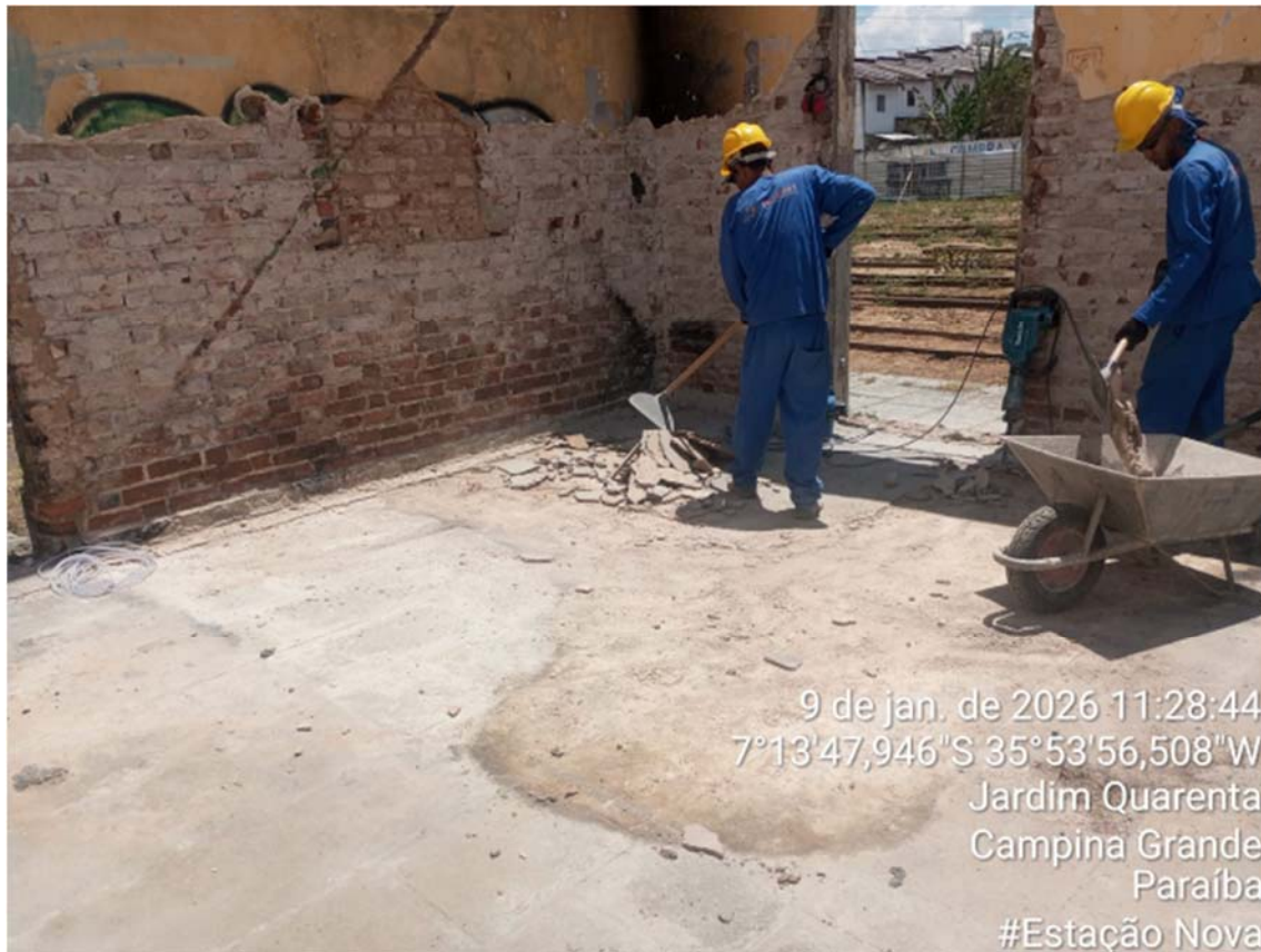
FOTO 03 – DEMOLIÇÃO DE PISO DE CONCRETO SIMPLES
