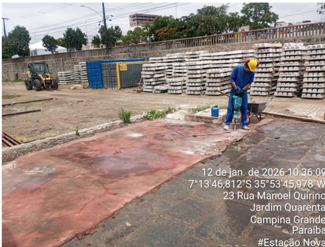
FOTO 06 – DEMOLIÇÃO DE PISO DE CONCRETO SIMPLES
