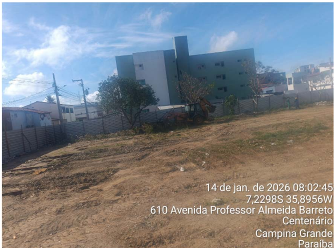
FOTO 07 - LIMPEZA MECANIZADA DE CAMADA VEGETAL
