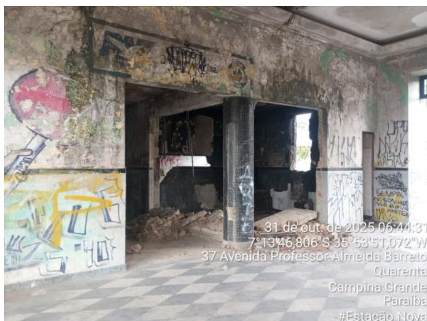
FOTO 14 – DEMOLIÇÃO DE ALVENARIA
