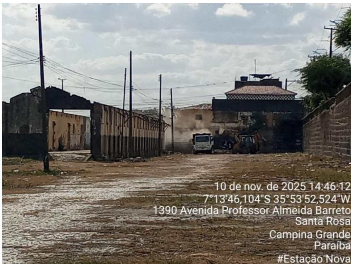
FOTO 20 – CARGA, MANOBRA, DESCARGA E TRANSPORTE
