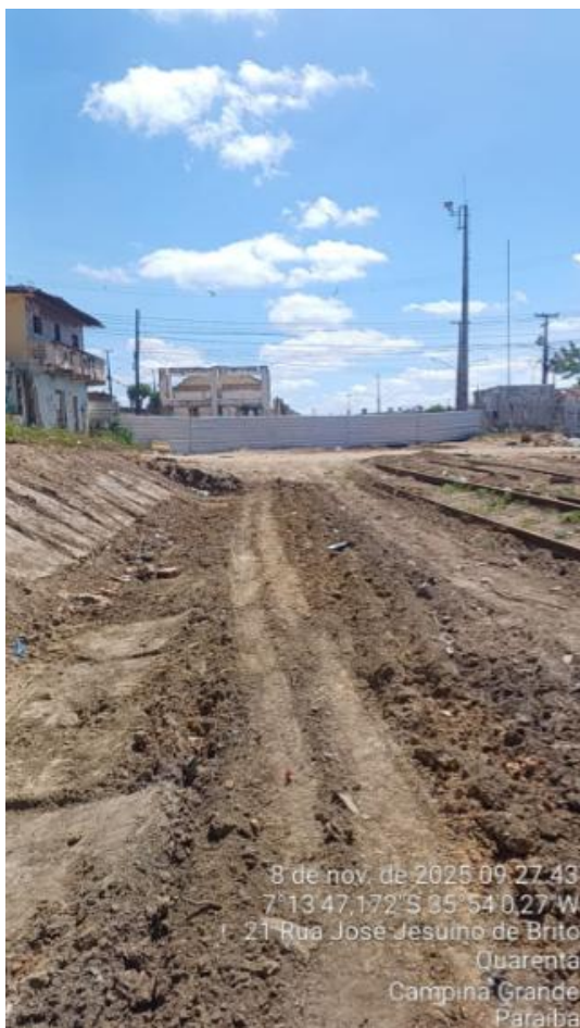
FOTO 01- LIMPEZA MECANIZADA DE CAMADA VEGETAL
