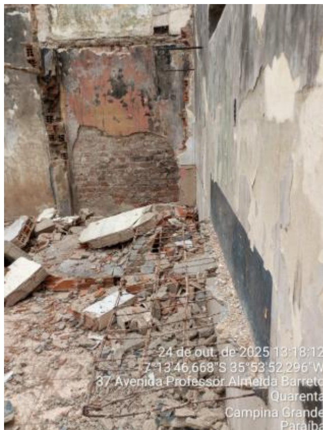
FOTO 13 – DEMOLIÇÃO DE CONCRETO ARMADO
