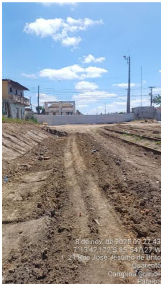
FOTO 01- LIMPEZA MECANIZADA DE CAMADA VEGETAL
