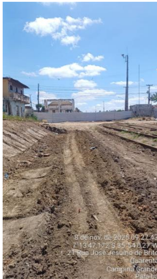
FOTO 01- LIMPEZA MECANIZADA DE CAMADA VEGETAL
