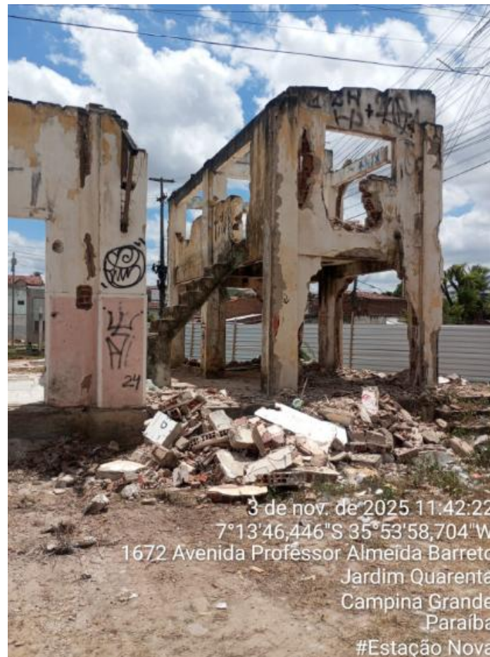
FOTO 18 – DEMOLIÇÃO DE ALVENARIA
