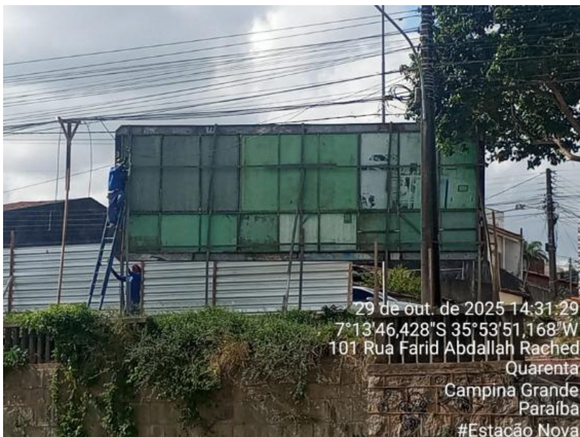
FOTO 03 - REMOÇÃO DE PLACAS
