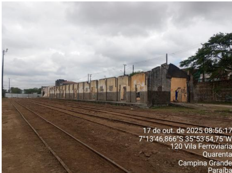
FOTO 17 – DEMOLIÇÃO DE ALVENARIA
