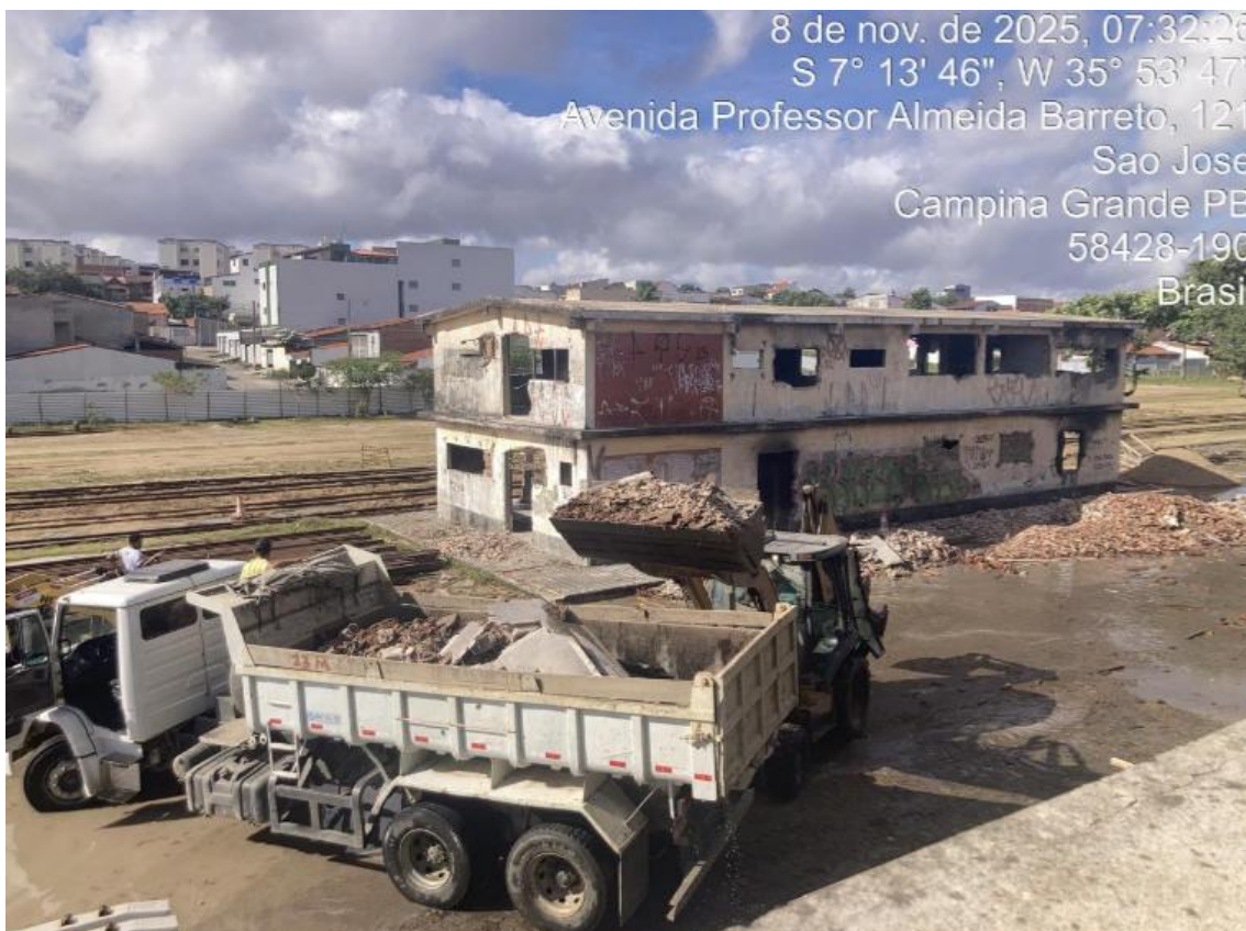
FOTO 12 – CARGA, MANOBRA, DESCARGA E TRANSPORTE
