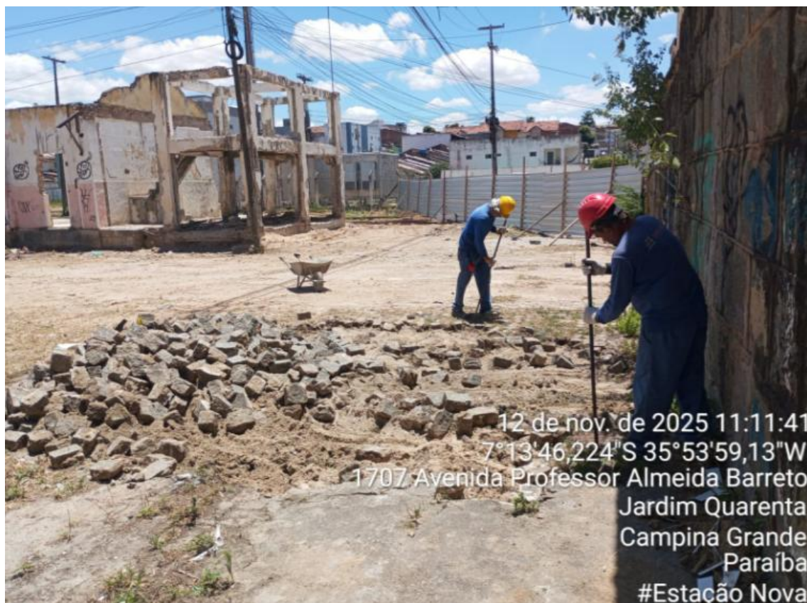
FOTO 04 - REMOÇÃO DE PARALELEPÍEDOS
