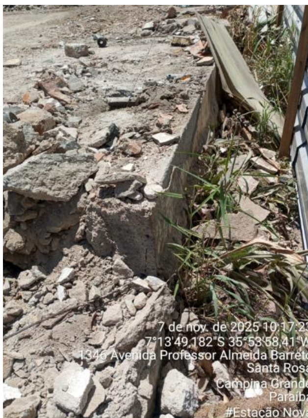
FOTO 21 – DEMOLIÇÃO DE PISO DE CONCRETO SIMPLES
