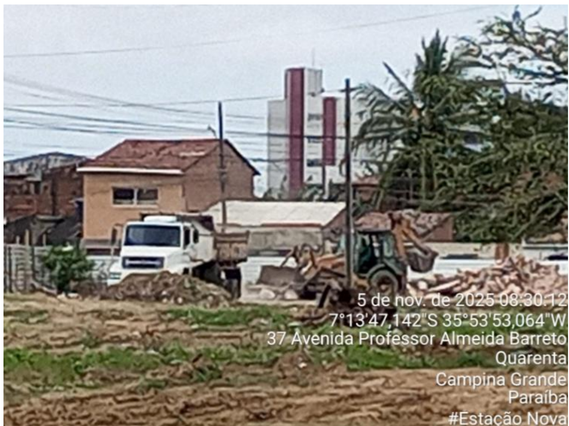
FOTO 02 - CARGA, MANOBRA, DESCARGA E TRANSPORTE
