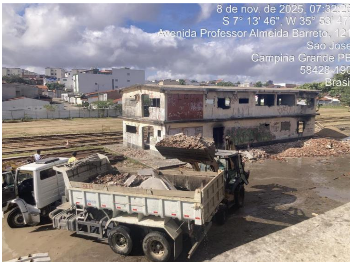
FOTO 12 – CARGA, MANOBRA, DESCARGA E TRANSPORTE
