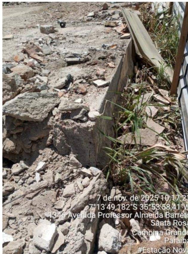
FOTO 21 – DEMOLIÇÃO DE PISO DE CONCRETO SIMPLES
