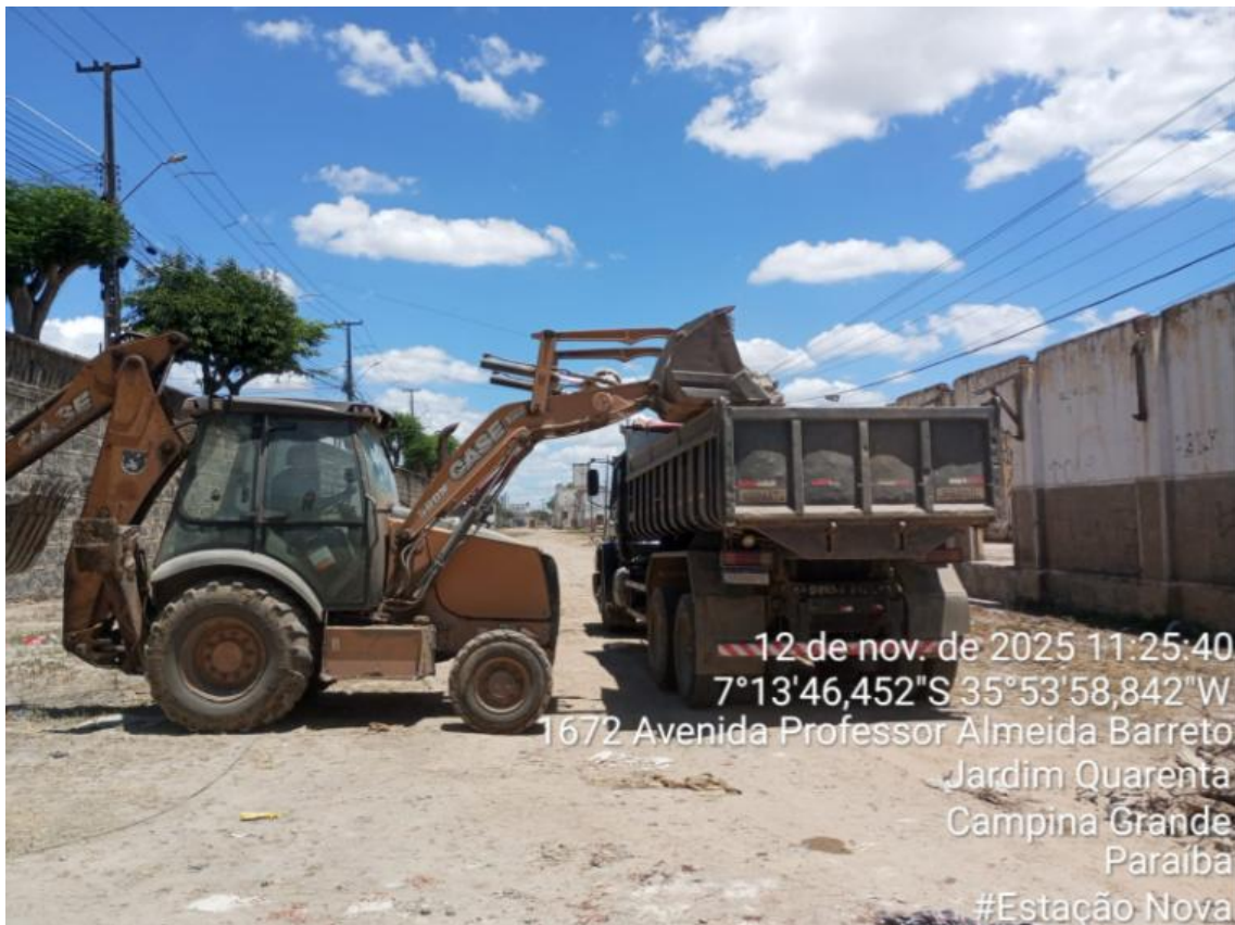
FOTO 05 - CARGA, MANOBRA, DESCARGA E TRANSPORTE
