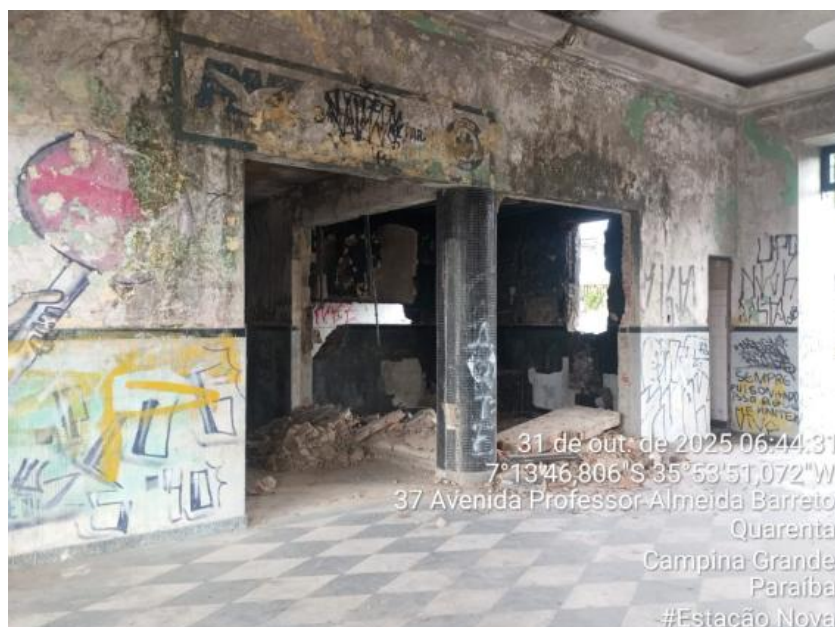
FOTO 14 – DEMOLIÇÃO DE ALVENARIA
