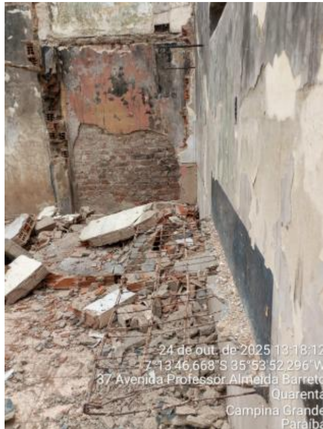
FOTO 13 – DEMOLIÇÃO DE CONCRETO ARMADO
