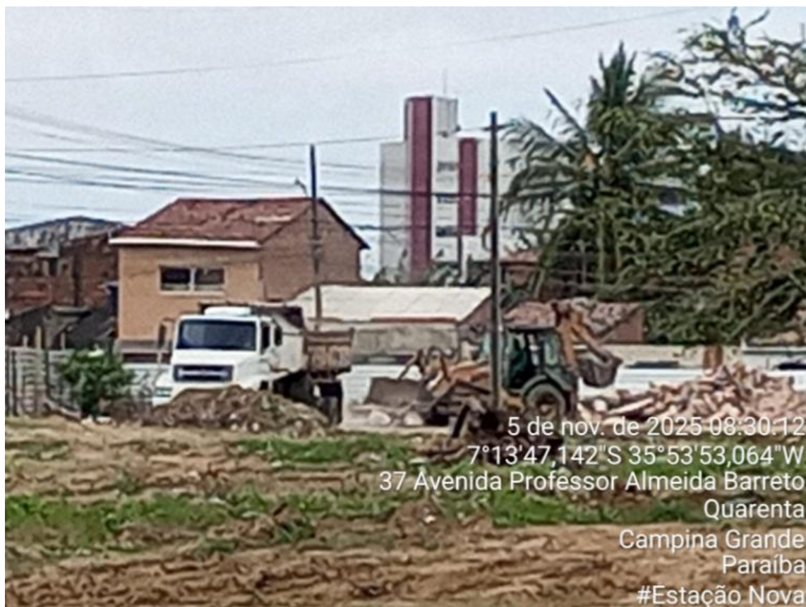
FOTO 02 - CARGA, MANOBRA, DESCARGA E TRANSPORTE
