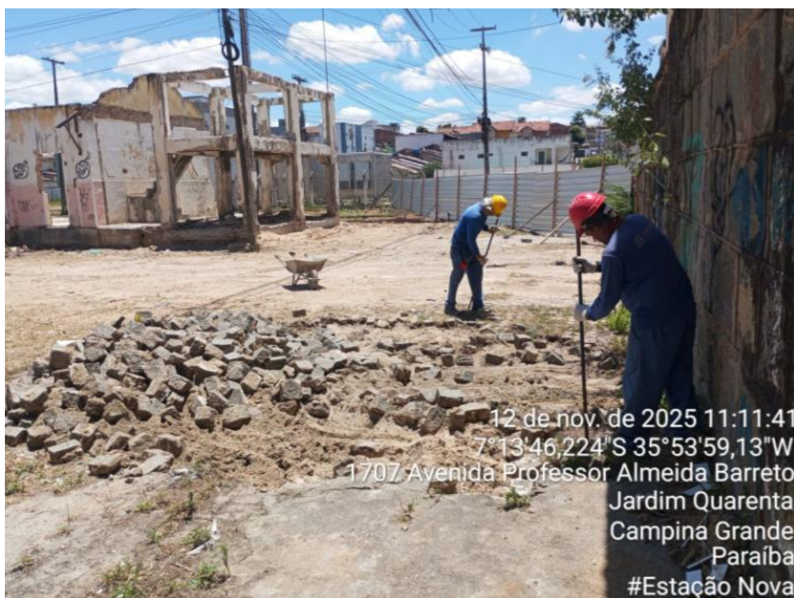
FOTO 04 - REMOÇÃO DE PARALELEPÍEDOS
