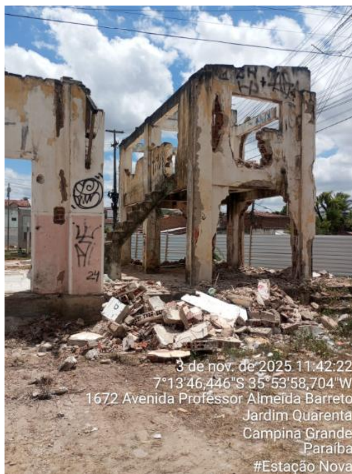
FOTO 18 – DEMOLIÇÃO DE ALVENARIA
