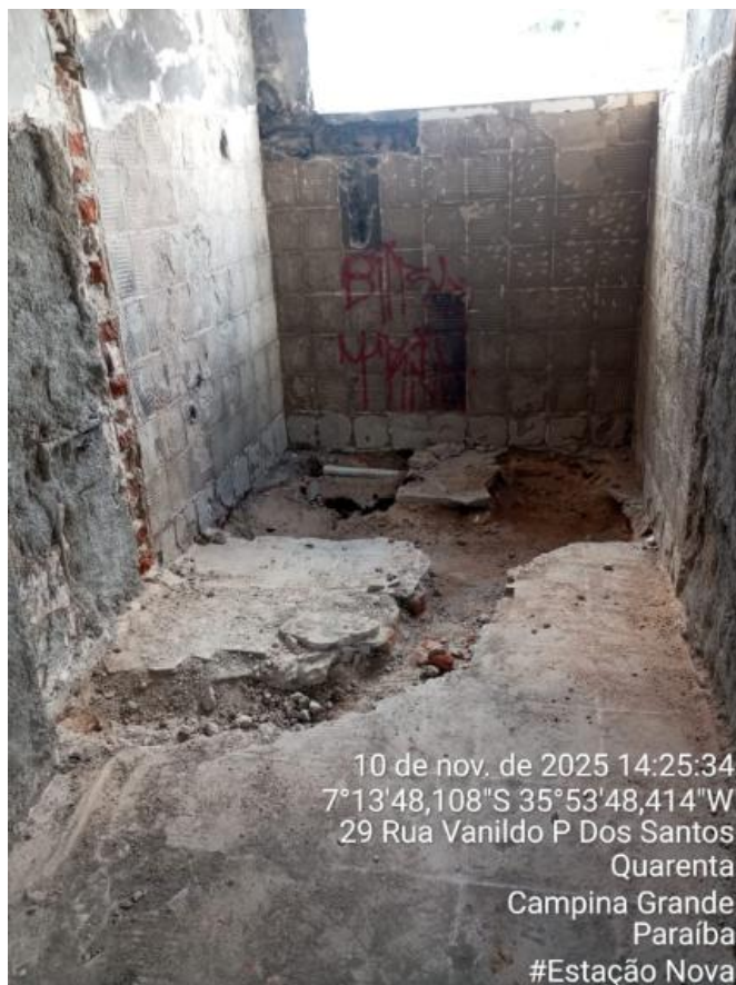
FOTO 15– DEMOLIÇÃO DE PISO DE CONCRETO
