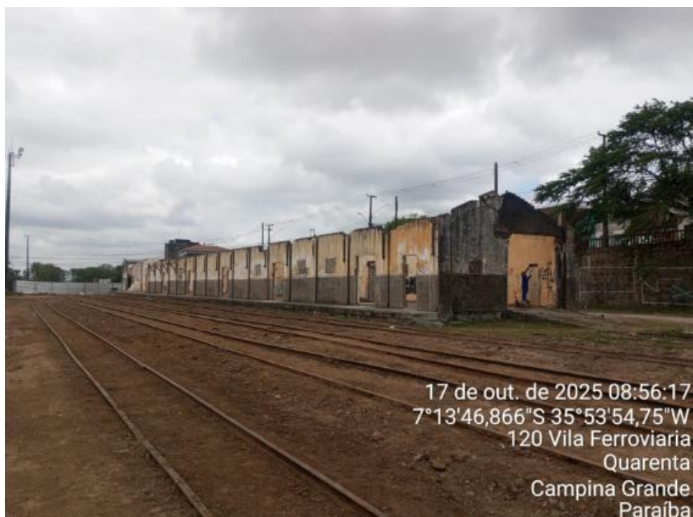
FOTO 17 – DEMOLIÇÃO DE ALVENARIA
