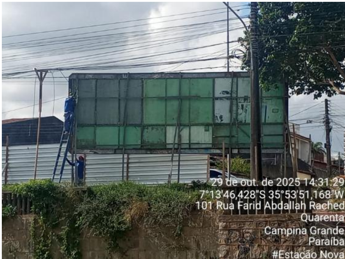
FOTO 03 - REMOÇÃO DE PLACAS
