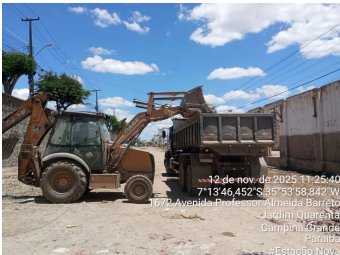
FOTO 05 - CARGA, MANOBRA, DESCARGA E TRANSPORTE
