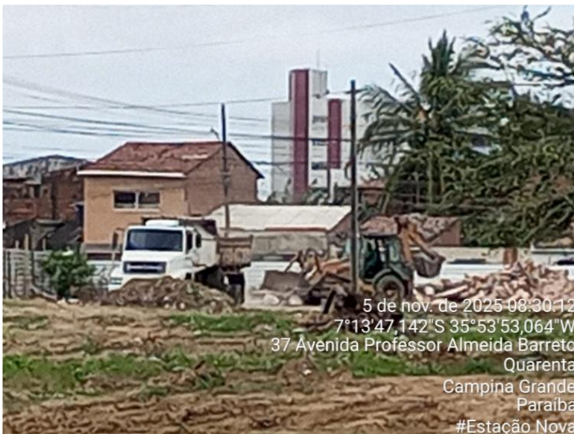
FOTO 02 - CARGA, MANOBRA, DESCARGA E TRANSPORTE
