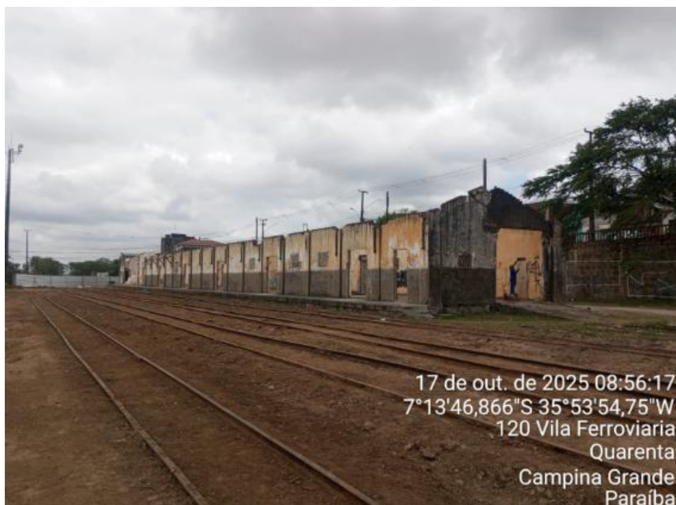
FOTO 17 – DEMOLIÇÃO DE ALVENARIA
