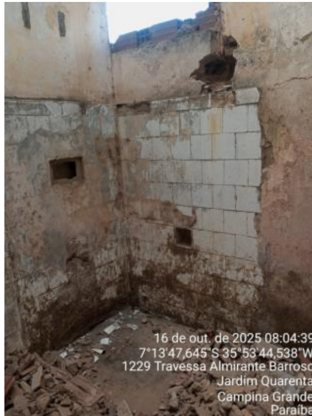
FOTO 09 – DEMOLIÇÃO DE ALVENARIA
