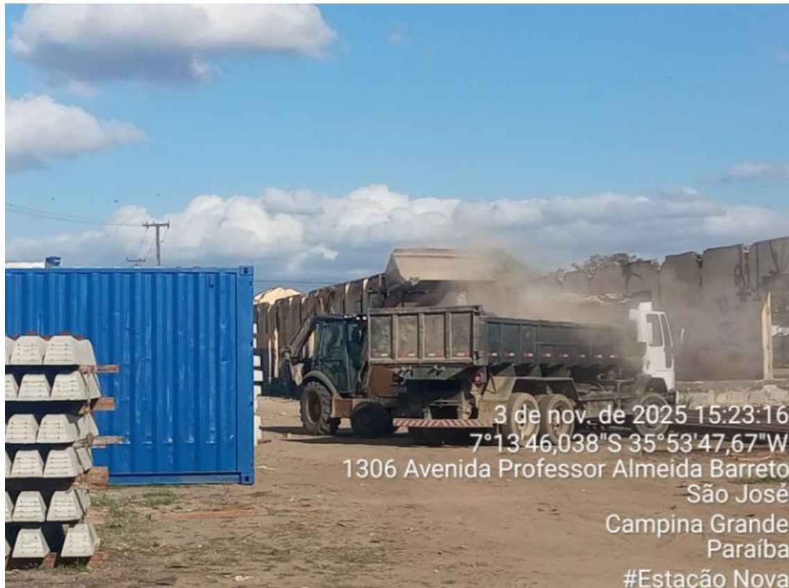
FOTO 10 – CARGA, MANOBRA, DESCARGA E TRANSPORTE
