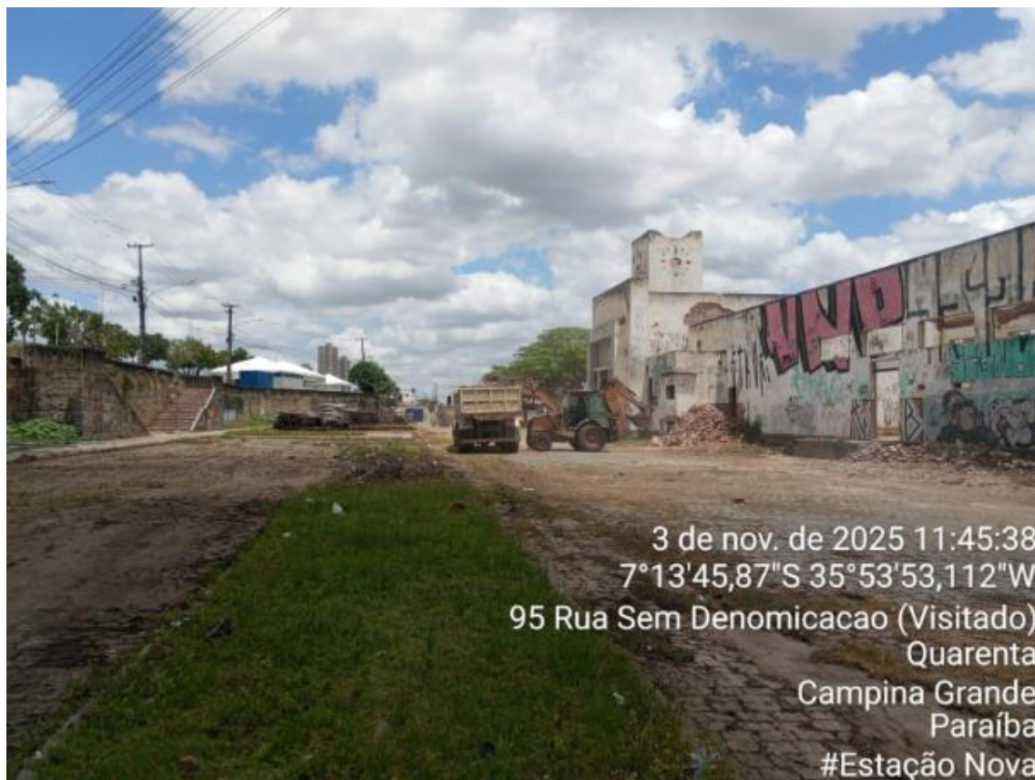
FOTO 16 – CARGA, MANOBRA, DESCARGA E TRANSPORTE
