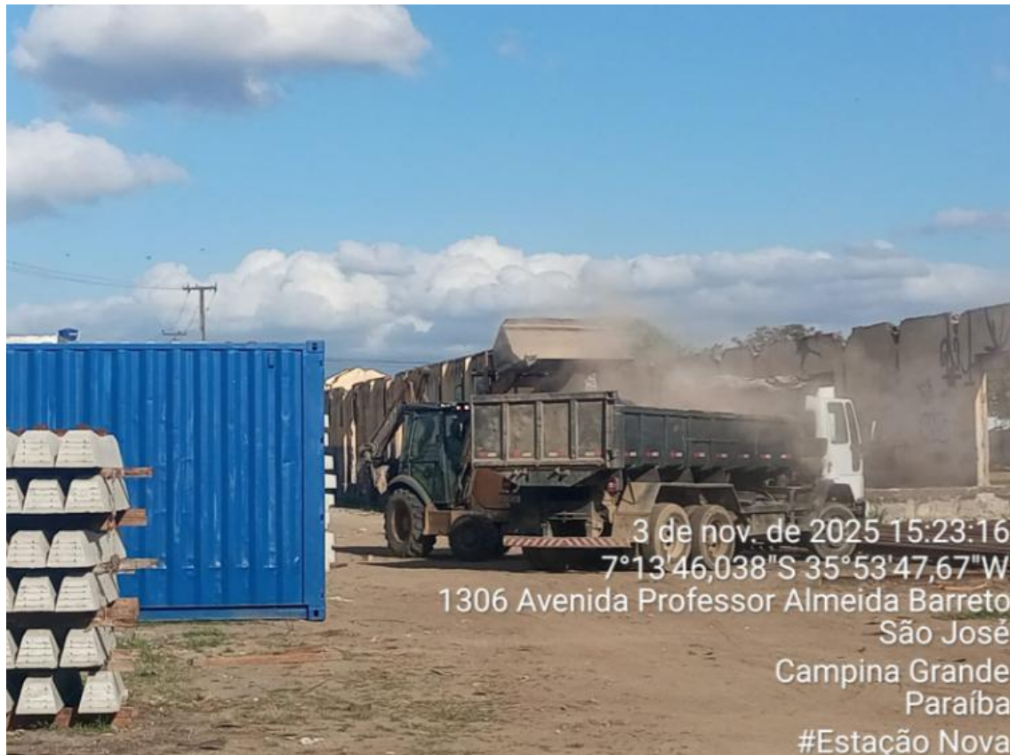
FOTO 10 – CARGA, MANOBRA, DESCARGA E TRANSPORTE
