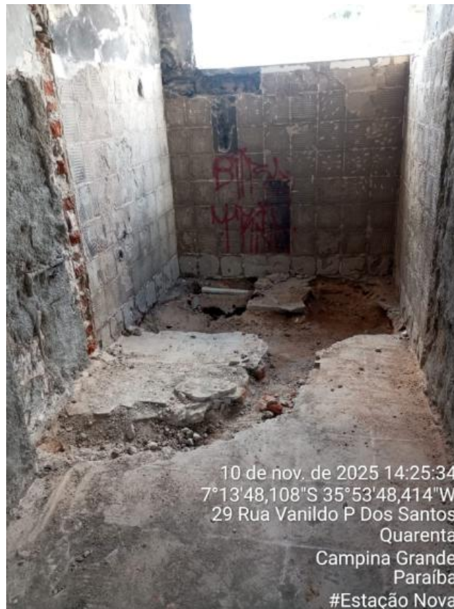
FOTO 15– DEMOLIÇÃO DE PISO DE CONCRETO
