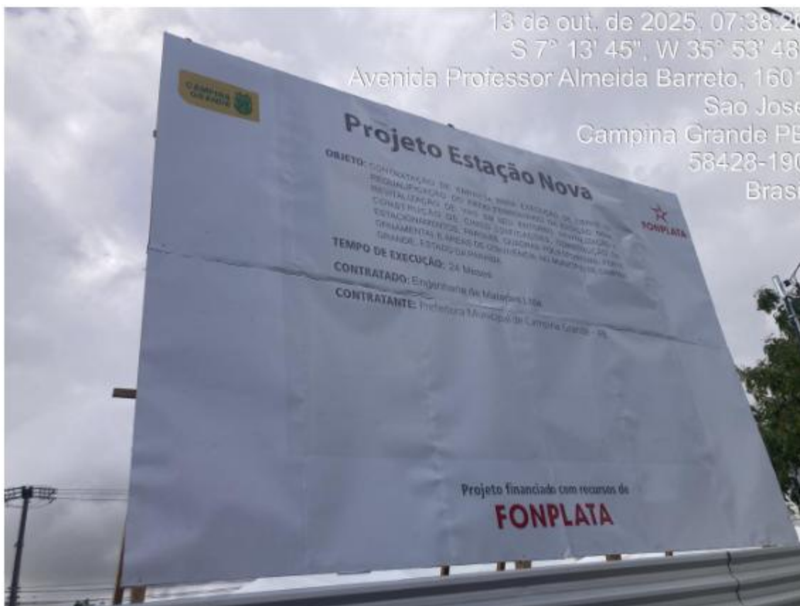
FOTO 10 – PLACA DA OBRA
