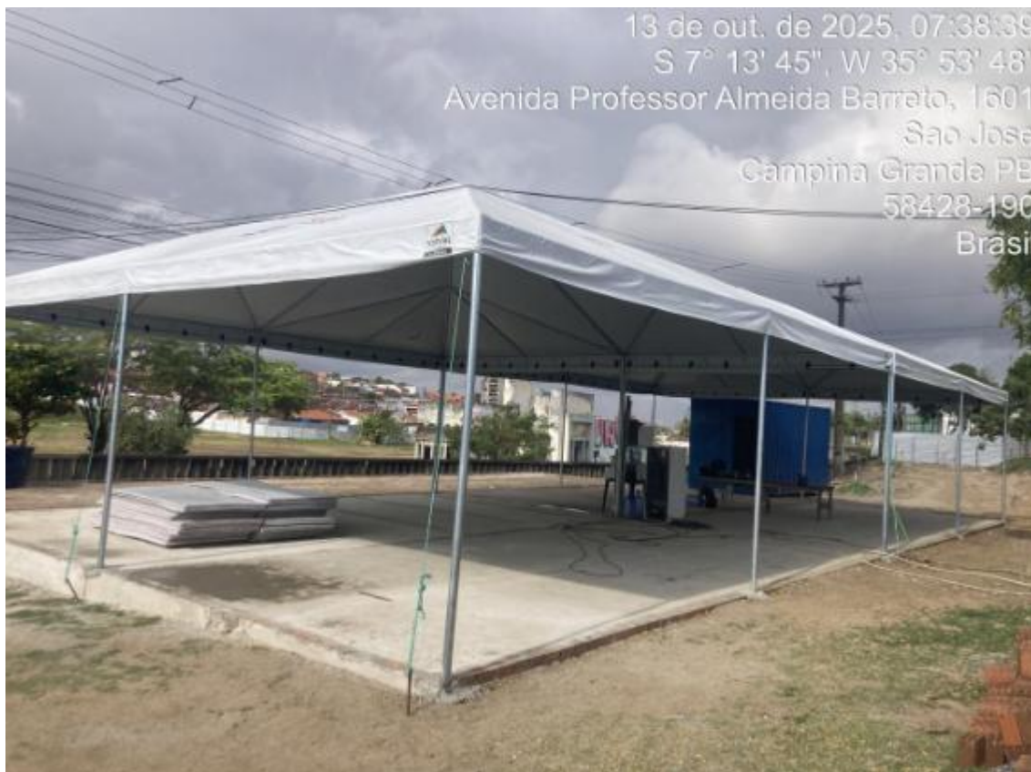
FOTO 03- BARRACÃO ABERTO PARA REFEITÓRIO DE OBRA
