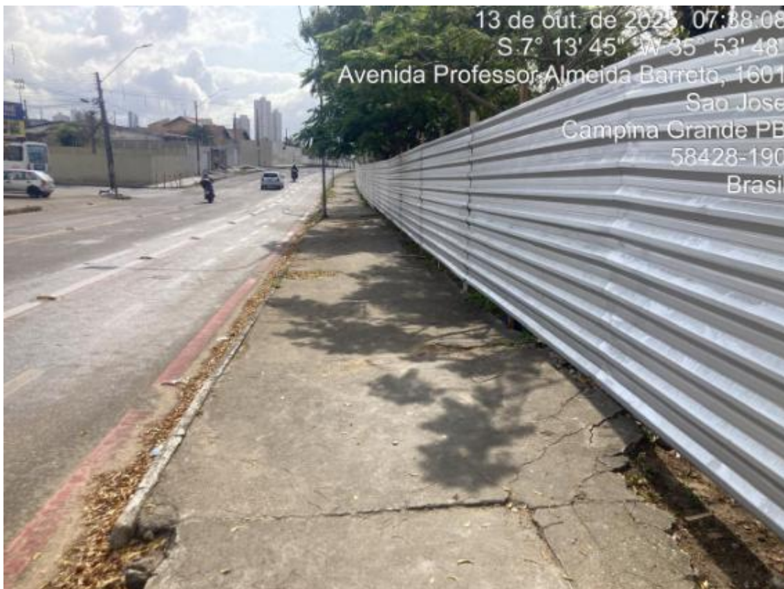
FOTO 01- TAPUME COM TELHA METÁLICA
