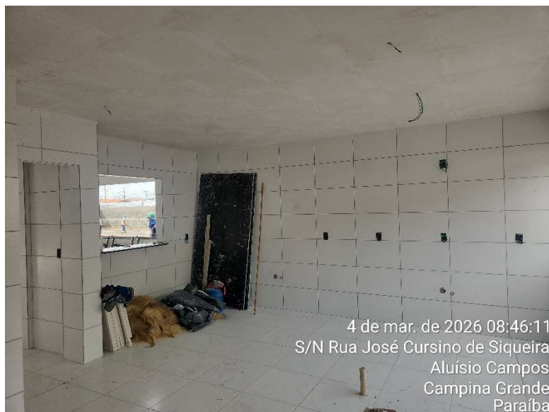
Cerâmica em piso e parede
