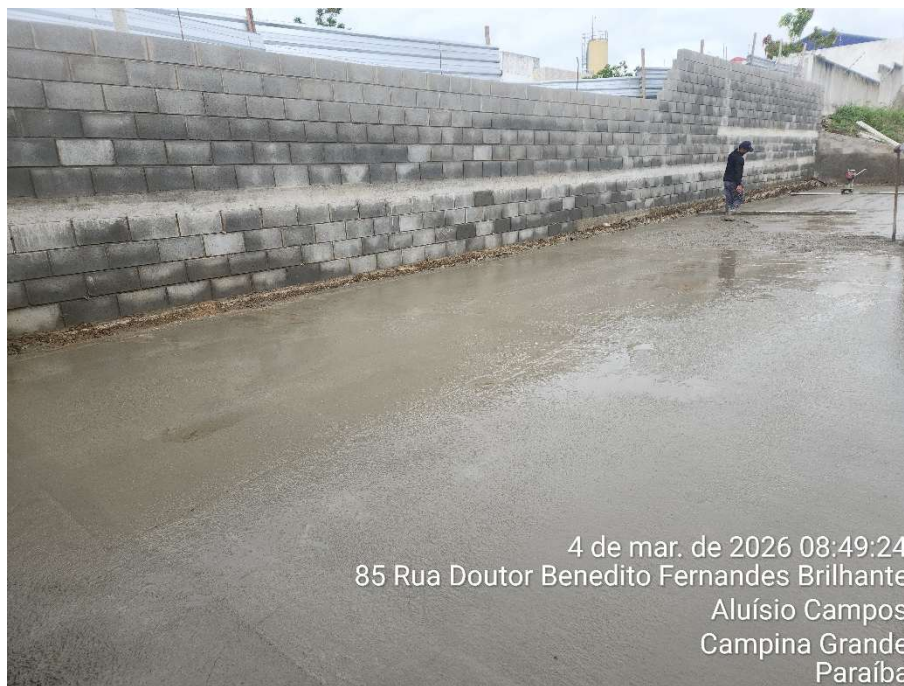
Execução de piso em concreto
