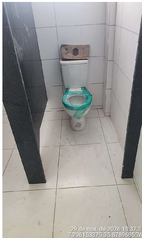
INSTALAÇÃO DE LOUÇAS
