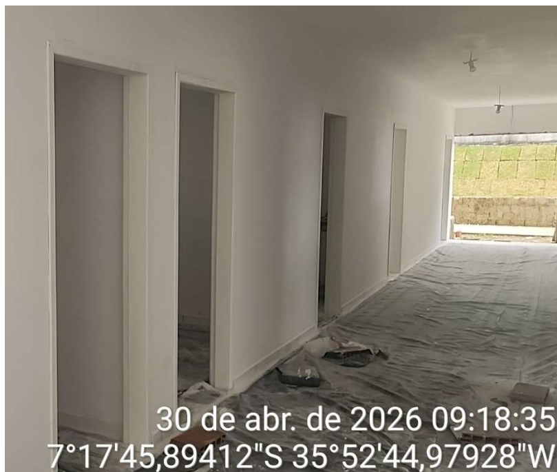
Pintura de forras de portas
