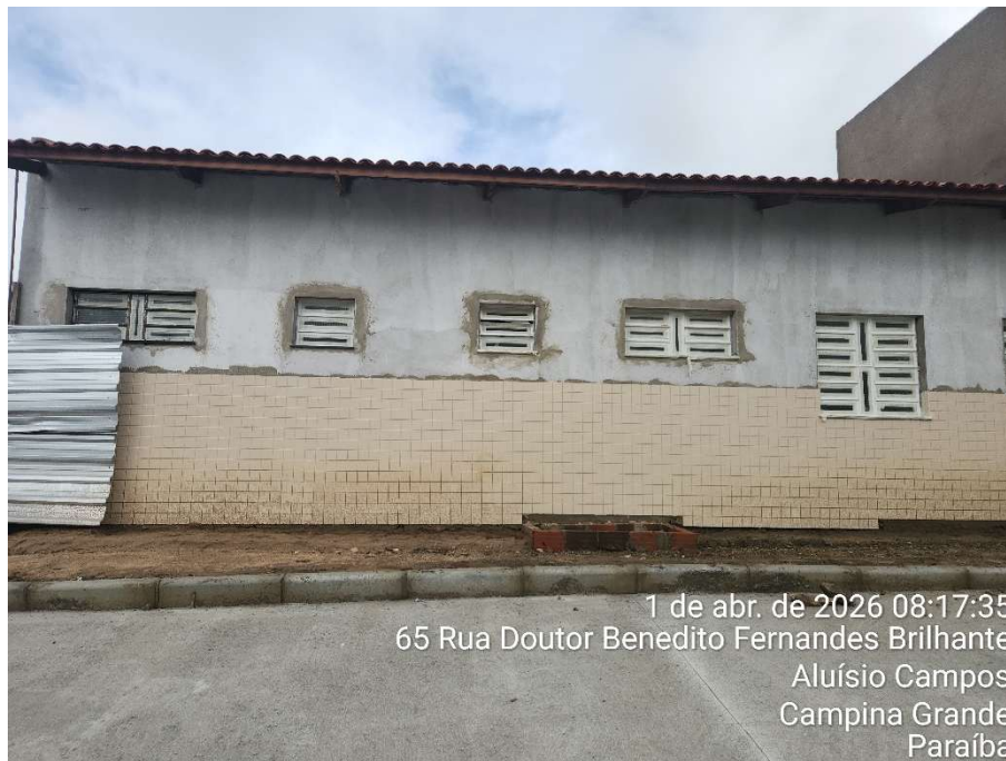
Fundo Selador em paredes externas
