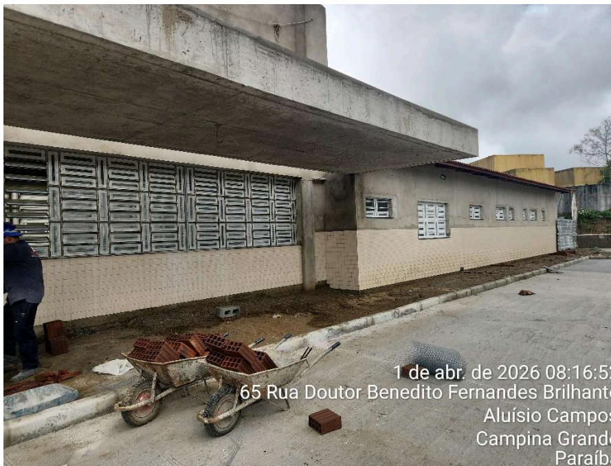
Vista Frontal da Obra
