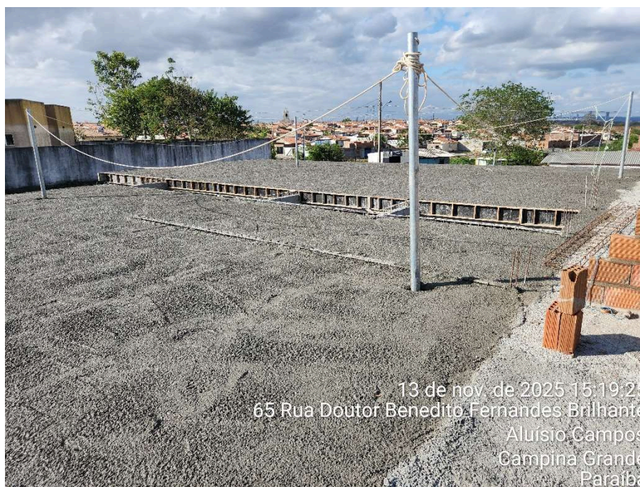
LAJE PRE MOLDADA
