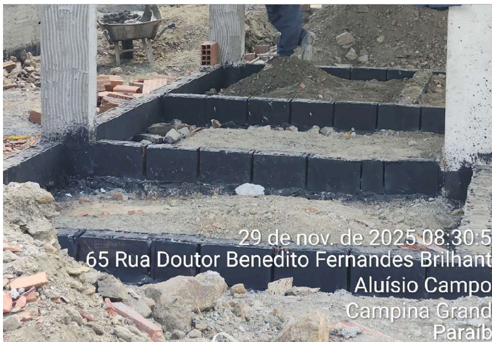
ALVENARIA DE EMBASAMENTO COM BLOCO ESTRUTURAL
