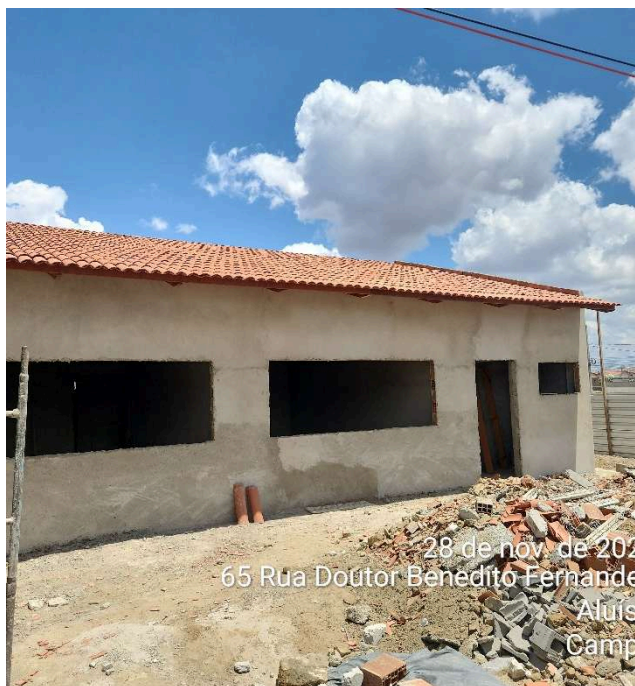
MASSA UNICA E EMBOÇO EXTERNO
