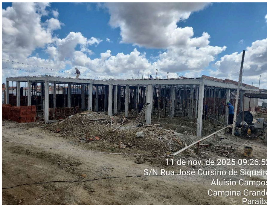
CONCRETO EM PILARES E VIGAS
