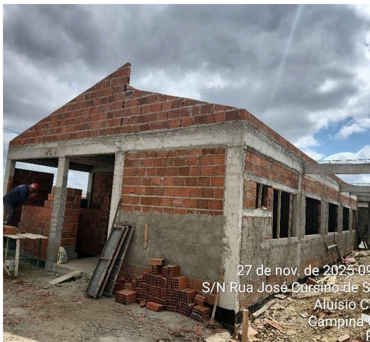
ALVENARIA E CONTRAVERGA
