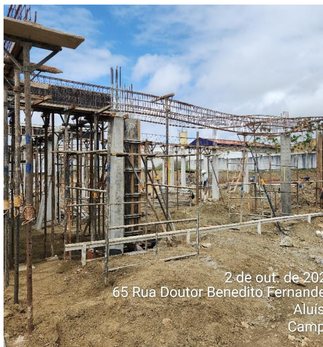
MONTAGEM E DESMONTAGEM DE FORMAS DE VIGAS
