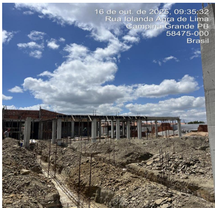
LASTRO DE CONCRETO MAGRO
