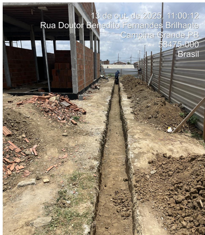
PREPARO DE FUNDO DE VALA
