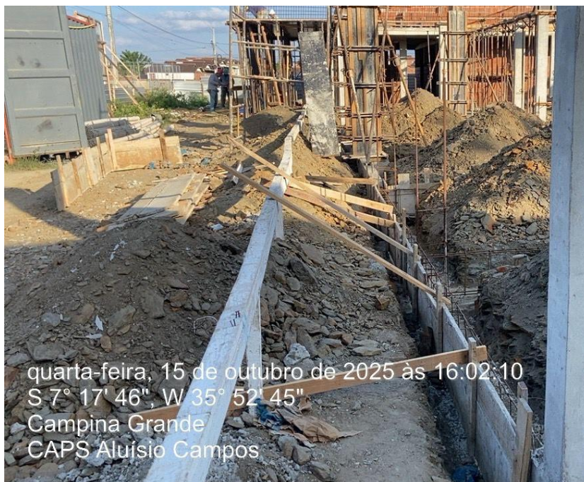
FABRICAÇÃO, MONTAGEM E DESMONTAGEM DE FÔRMA
