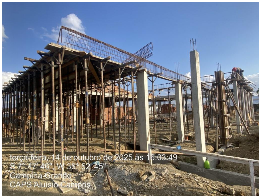
AÇO CA50 EM VIGAS
