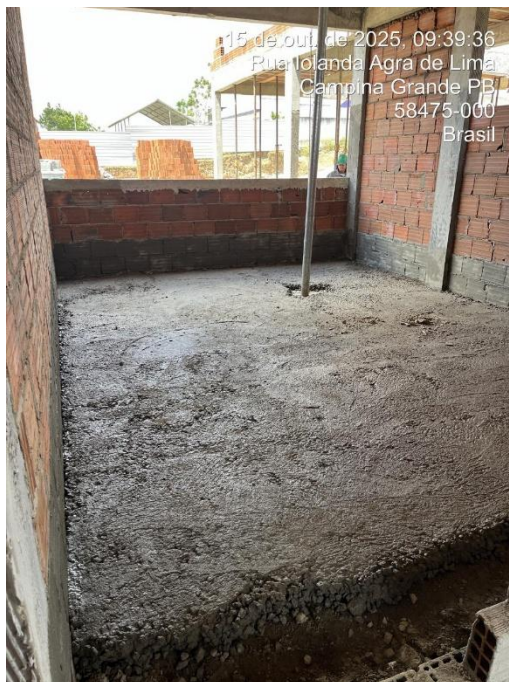
LASTRO DE CONCRETO MAGRO
