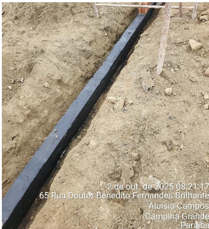
IMPERMEABILIZAÇÃO DE SUPERFÍCIE COM EMULSÃO ASFÁLTICA
