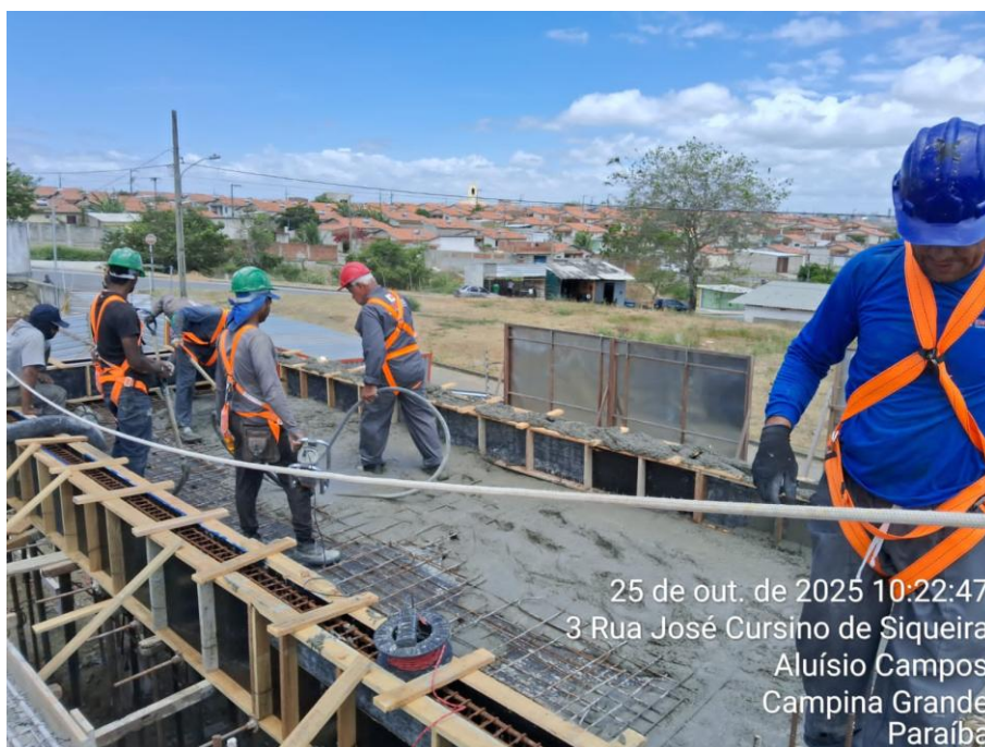
CONCRETAGEM DE LAJE
