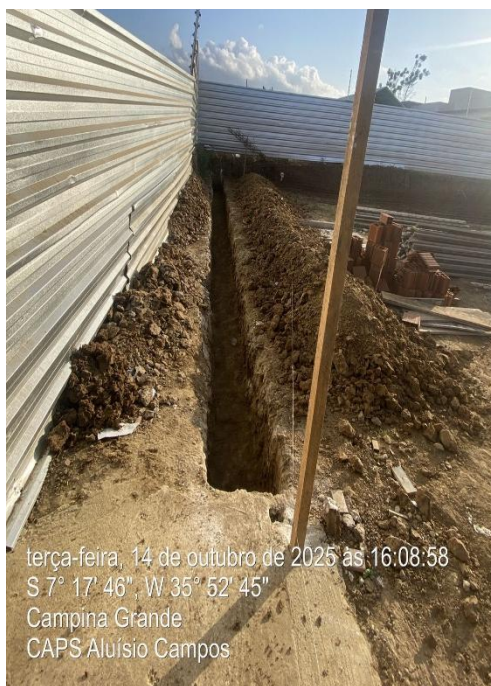
ESCAVAÇÃO MANUAL DE VALA
