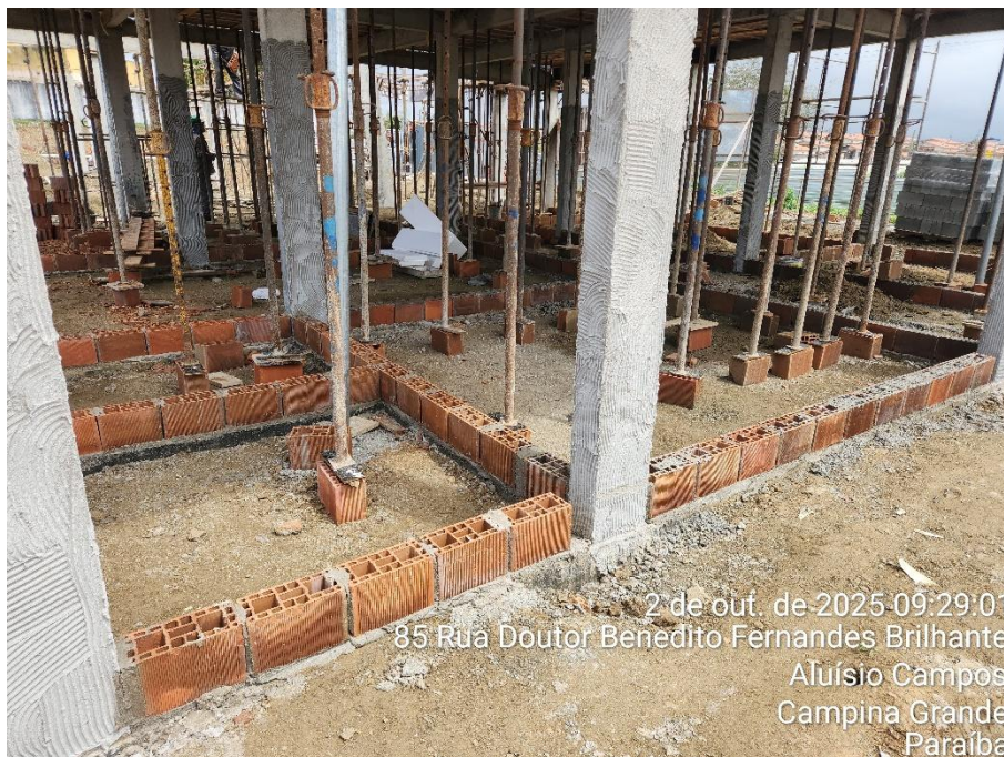
ALVENARIA DE EMBASAMENTO
