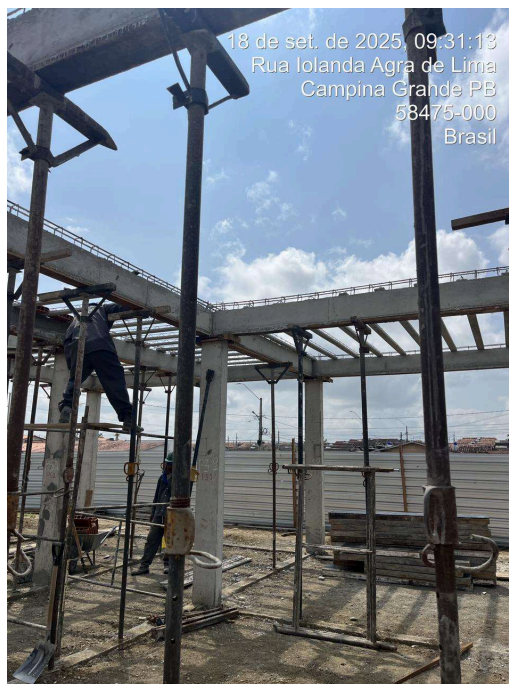
CONCRETO 25MPA EM ESTRUTURAS
