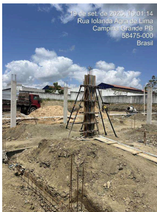
MONTAGEM E DESMONTAGEM DE FORMAS DE PILARES
