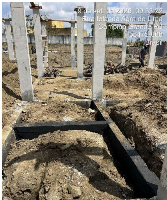
IMPERMEABILIZAÇÃO DE SUPERFÍCIE COM EMULSÃO ASFÁLTICA
