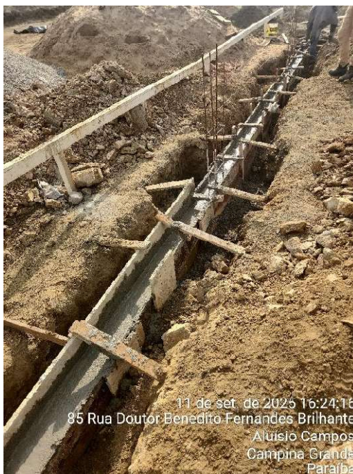
FABRICAÇÃO, MONTAGEM E DESMONTAGEM DE FÔRMA
