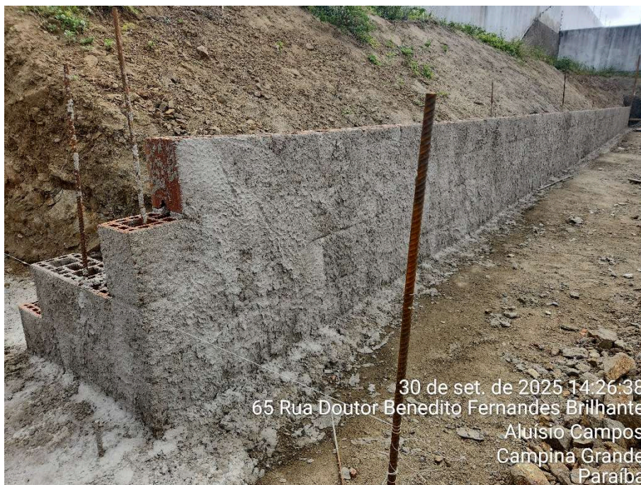
ALVENARIA DE CONTENÇÃO DE TALUDE
