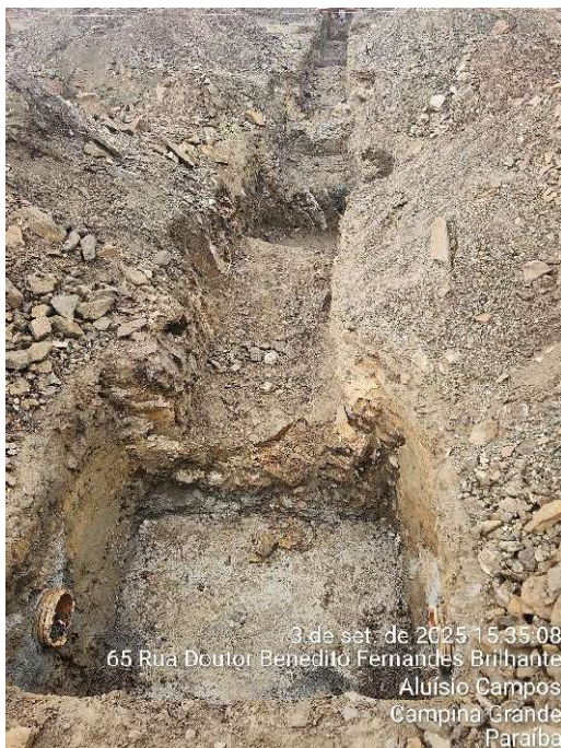
ESCAVAÇÃO MANUAL DE VALA
