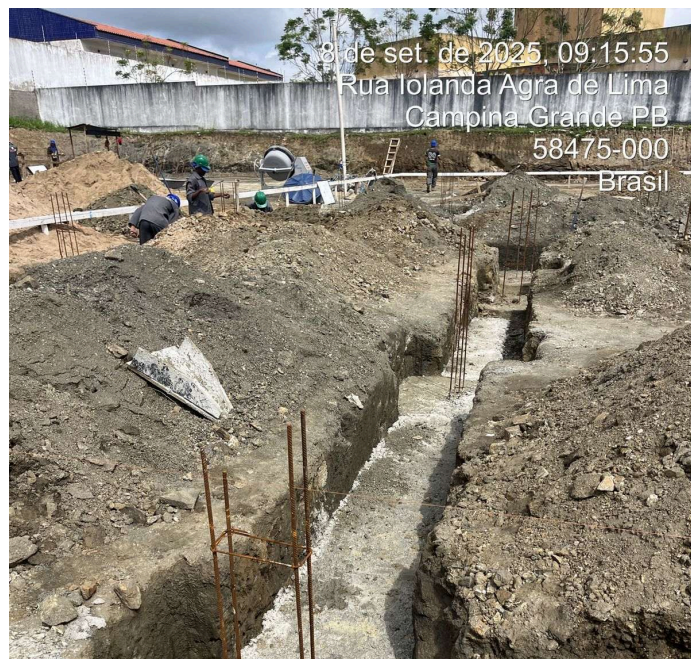
PREPARO DE FUNDO DE VALA
