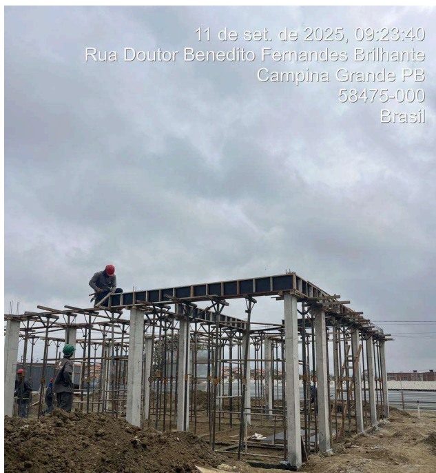
MONTAGEM E DESMONTAGEM DE FORMAS DE VIGAS
