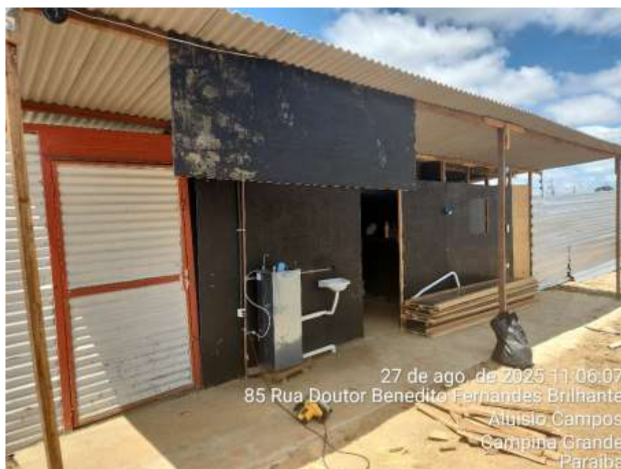
BARRACAO DE OBRA PARA ALOJAMENTO/ESCRITORIO
