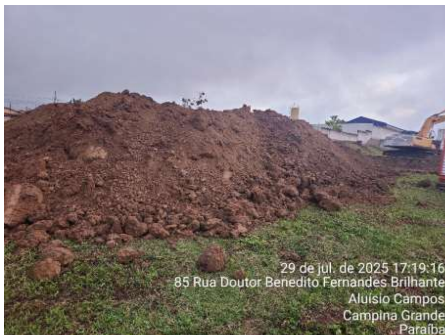
ESCAVAÇÃO HORIZONTAL EM SOLO DE 1A CATEGORIA
