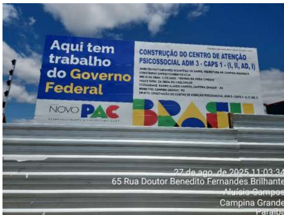
PLACA DE OBRA EM CHAPA DE ACO GALVANIZADO
