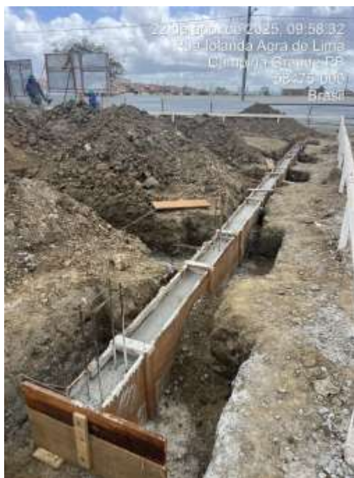
FABRICAÇÃO, MONTAGEM E DESMONTAGEM DE FÔRMA
