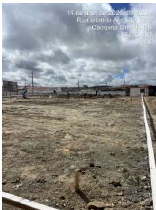
LOCAÇÃO CONVENCIONAL DE OBRA, UTILIZANDO GABARITO
