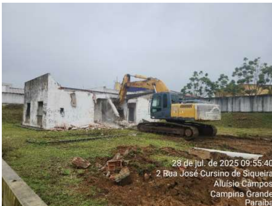
DEMOLIÇÃO DE ALVENARIA, PILARES, VIGAS E LAJE EM CONCRETO ARMADO
