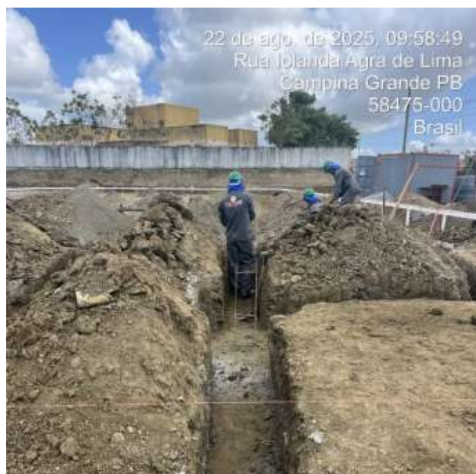
PREPARO DE FUNDO DE VALA
