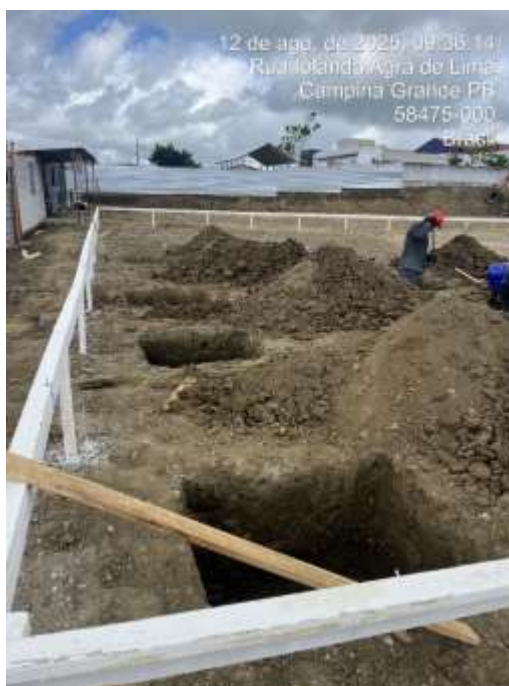
ESCAVAÇÃO MANUAL DE VALA
