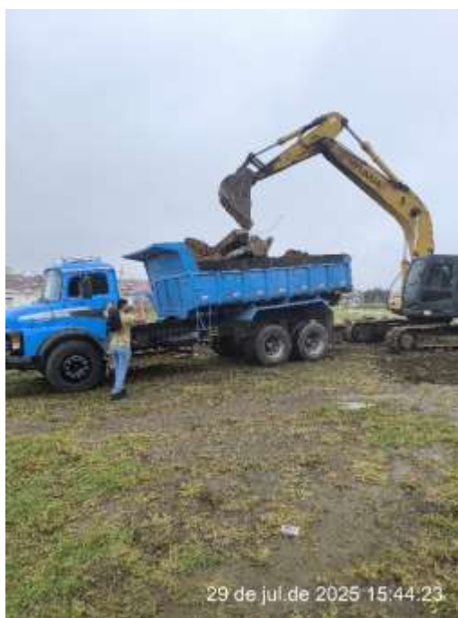
CARGA, MANOBRA E DESCARGA DE ENTULHO EM CAMINHÃO BASCULANTE
