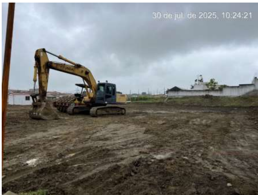
LIMPEZA MECANIZADA DE CAMADA VEGETAL
