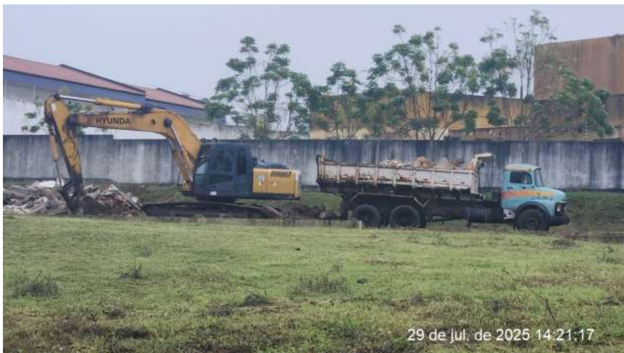
TRANSPORTE COM CAMINHÃO BASCULANTE DE 14 M 3
