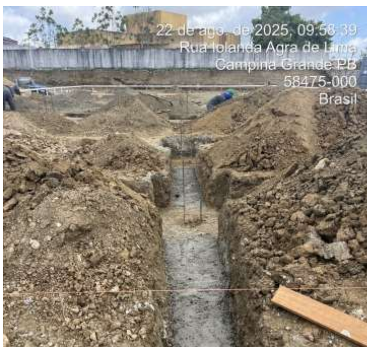
LASTRO DE CONCRETO MAGRO
