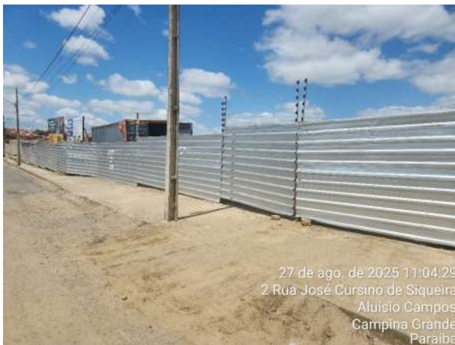
TAPUME COM TELHA METÁLICA.
