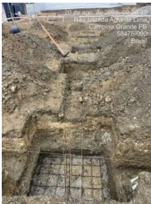
AÇO CA - 50 Ø 6,3 A 12,5MM, INCLUSIVE CORTE, DOBRAGEM, MONTAGEM
