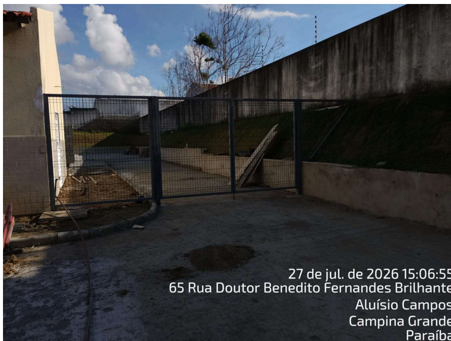
INSTALAÇÃO DE GRADIS
