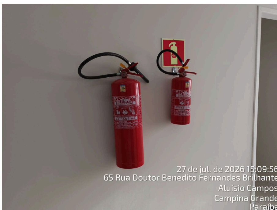
INSTALAÇÃO DE EXTINTORES
