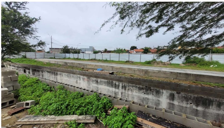
Figura 07: Muro de Arrimo executado
