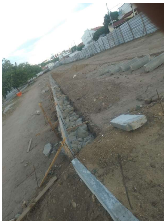
Figura 06: Muro de Arrimo antes de acabamento
