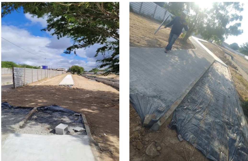
Figura 08: Lona antes de concretagem de ciclofaixa e pista de caminhada
