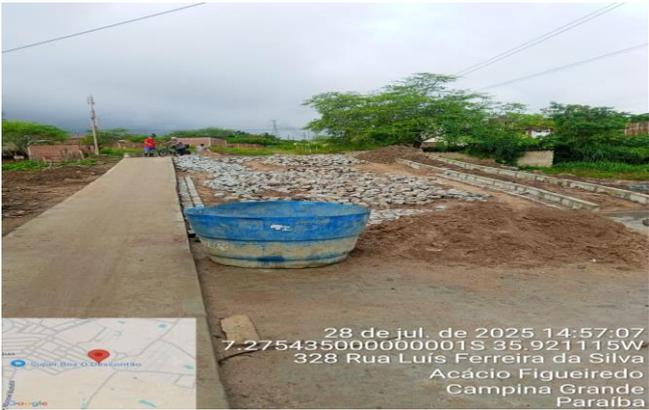
FOTO 9: EXECUÇÃO DE PASSEIO EM CONCRETO
