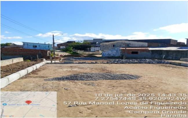
FOTO 5: ASSENTAMENTO DE MEIO FIO DE CONCRETO
