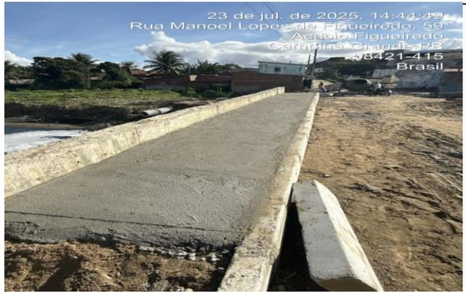
FOTO 10: EXECUÇÃO DE PASSEIO EM CONCRETO
