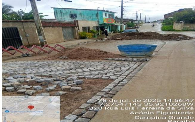
FOTO 8: EXECUÇÃO DE PAVIMENTAÇÃO EM PARALELEPÍEDOS
