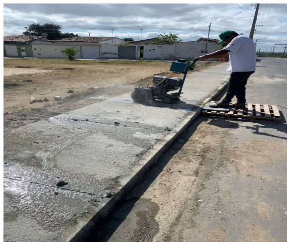
Foto 12: Juntas de dilatação das calçadas .
