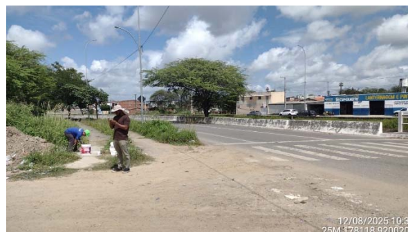
Figura 03 – Marcação dos Pontos de controle para auxiliar nos ajustes e na precisão dos levantamentos.
