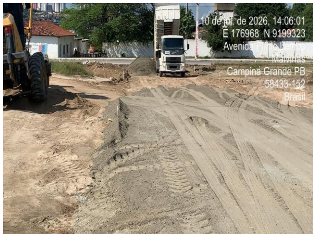
Foto 07: Compactação de base e sub base rua Olinda.
