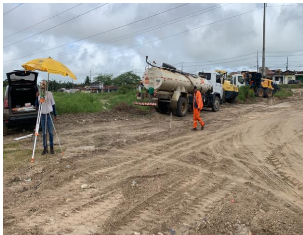
Foto 03: Aterro com material de jazida Rua Olinda .
