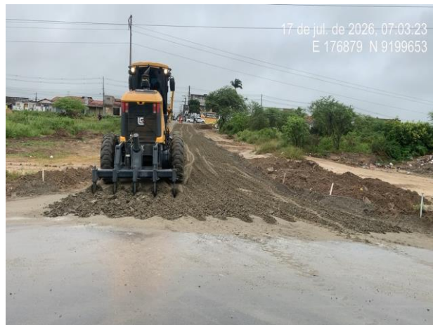
Foto 04: Compactação de aterro de jazida Rua Olinda .
