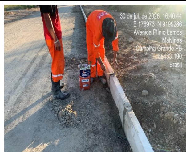
Foto 16: Assentamento de meio fio E0 a 5 lado direito .
