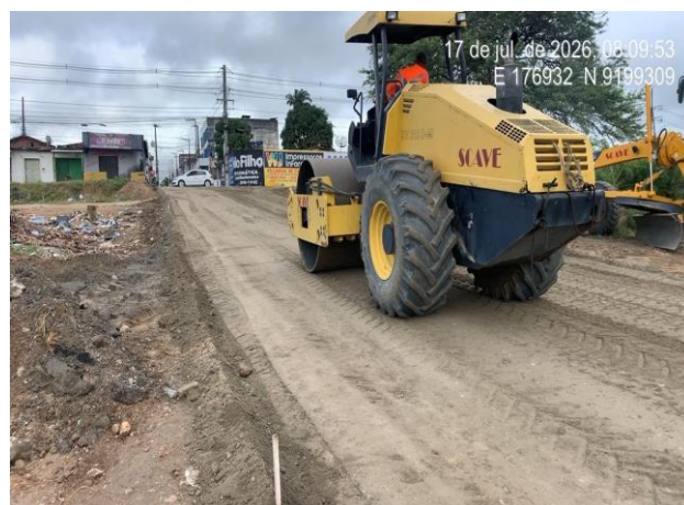
Foto 04: Compactação de aterro de jazida Rua Olinda .
