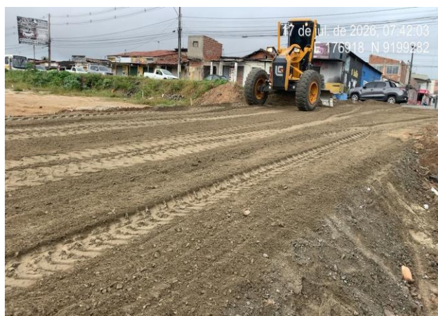
Foto 03: Aterro com material de jazida Rua Olinda .
