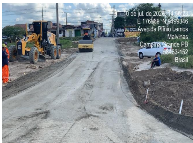
Foto 07: Compactação de base e sub base rua Olinda.
