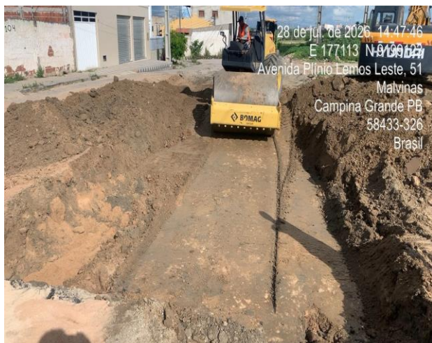
Foto 11: Lançamento de brita graduada E0 a 5 lado direito. .
