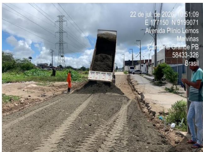
Foto 11: Lançamento de brita graduada E0 a 5 lado direito. .
