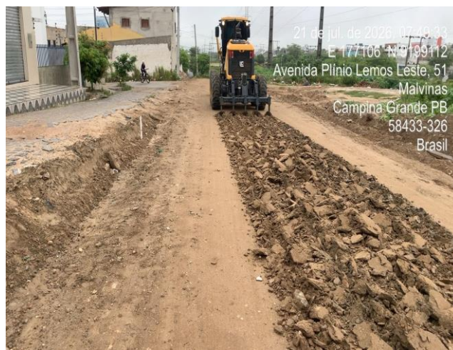
Foto 12: Execução de base e sub base em brita graduada E0 a 5 lado direito. .
