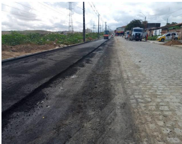
Foto 07: Pavimentação asfáltica E43 a 61 lado direito (Cagepa)
