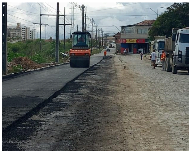
Foto 08: Pavimentação asfáltica E43 a 61 lado direito (Cagepa)
