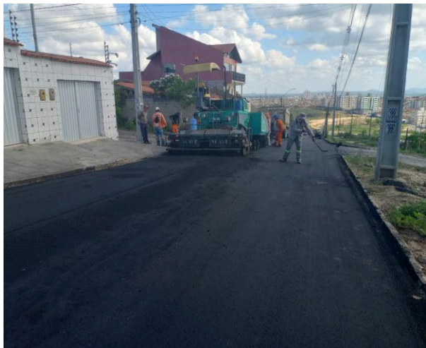
Foto 07: Pavimentação asfáltica E43 a 61 lado direito (Cagepa)
