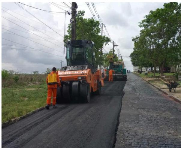
Foto 08: Pavimentação asfáltica E43 a 61 lado direito (Cagepa)
