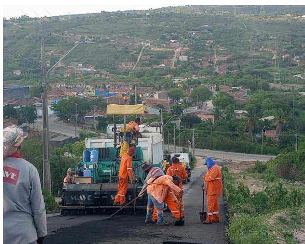
Foto 12: Recapeamento lado esquerdo E 135 a 147.
