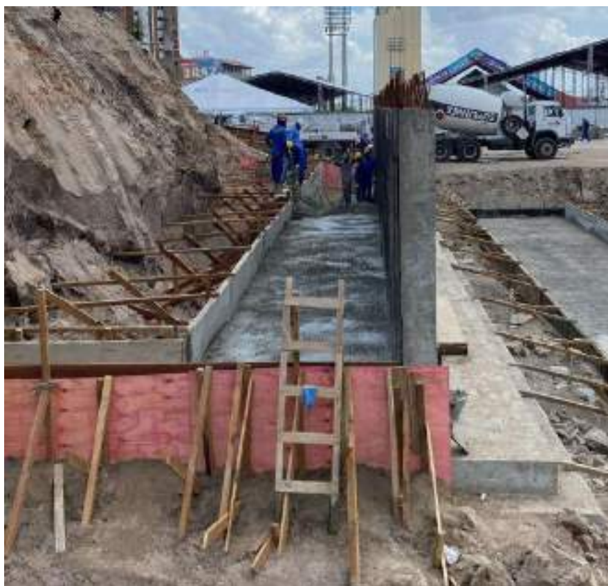
Figura 4 – Aplicação de concreto onde seria usado solo-cimento
