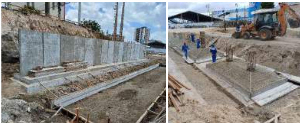
Figura 2 – Fundações já sobre a solução dada que permitiu velocidade à obra
