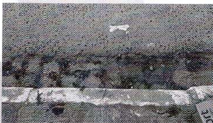
Figura 16 - Camadas de revestimento existente – Av. Santa Clara (próximo à Bia Lanches). Fonte: Autoria Própria (2022).
