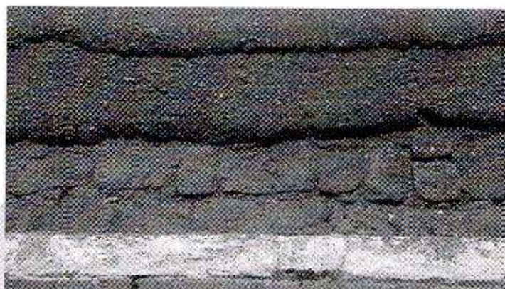
Figura 15 – Camadas de revestimento existente – Av. Santa Clara (próximo a Lindo Olhar Lanches). Fonte: Autoria Própria (2022).
