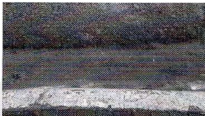
Figura 18 - Camadas de revestimento existente – Av. Floriano Peixoto (próximo ao Empresarial Palazzo). Fonte: Autoria Própria (2022).
