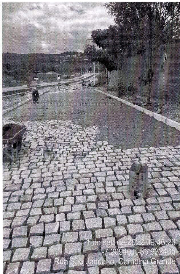
Fotos 10, 11 e 12 – Pavimentação em paralelepípedos
