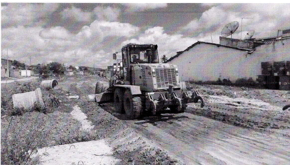
Fotos 19 e 20- Terraplanagem Canal da ramadina
