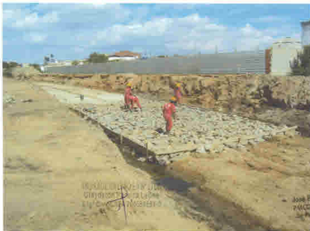
CONCRETAGEM DO PISO ESTACA 80 + 10,00 O MESMO FOI CONCRETADO ATÉ 86 + 12,00.
